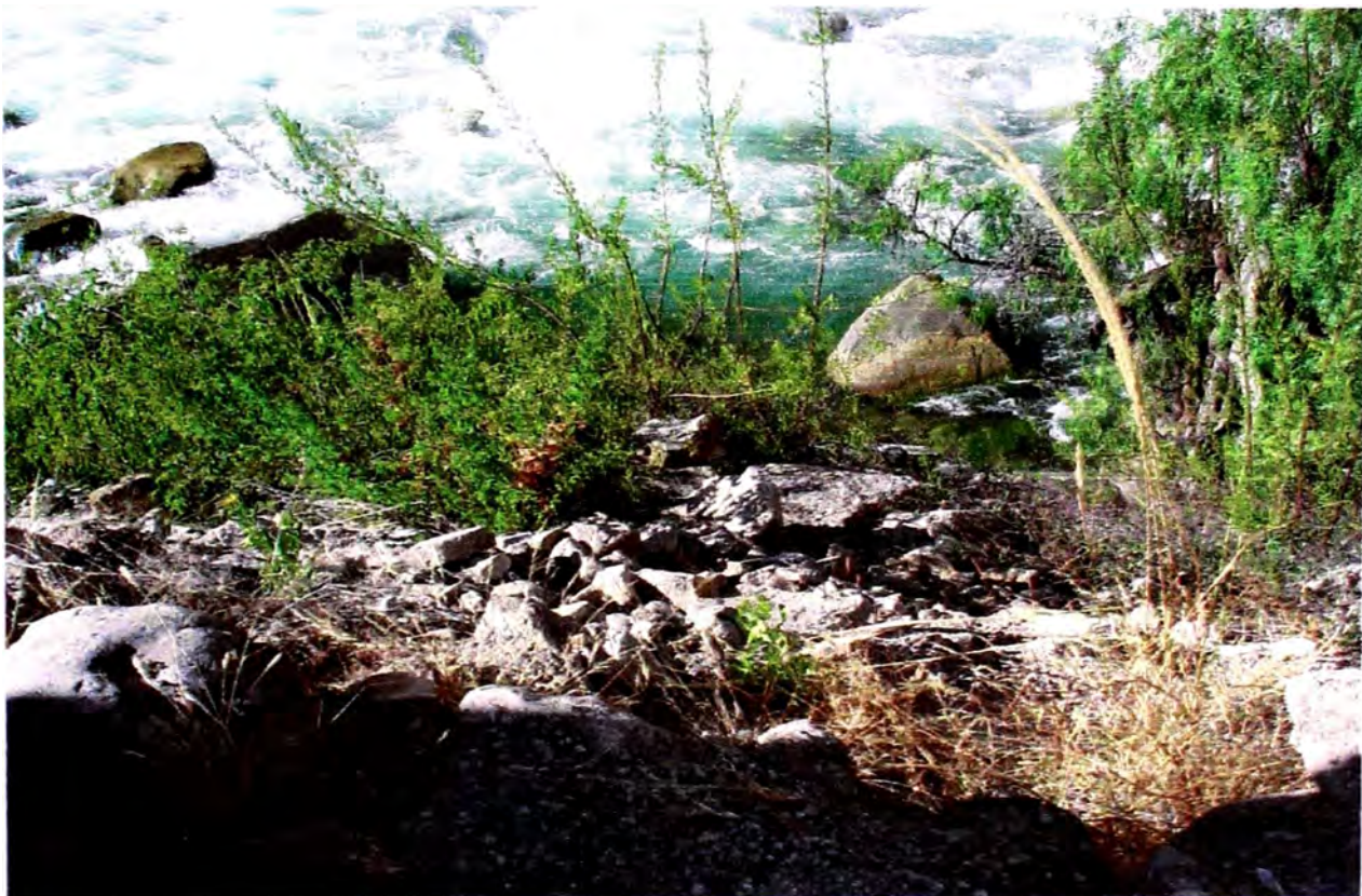
Fotografía 4.08 Erosión cercana a la vía
