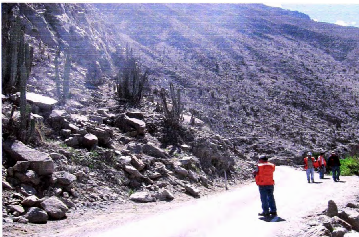
Fotografía 4.10 Talud variable del terreno
