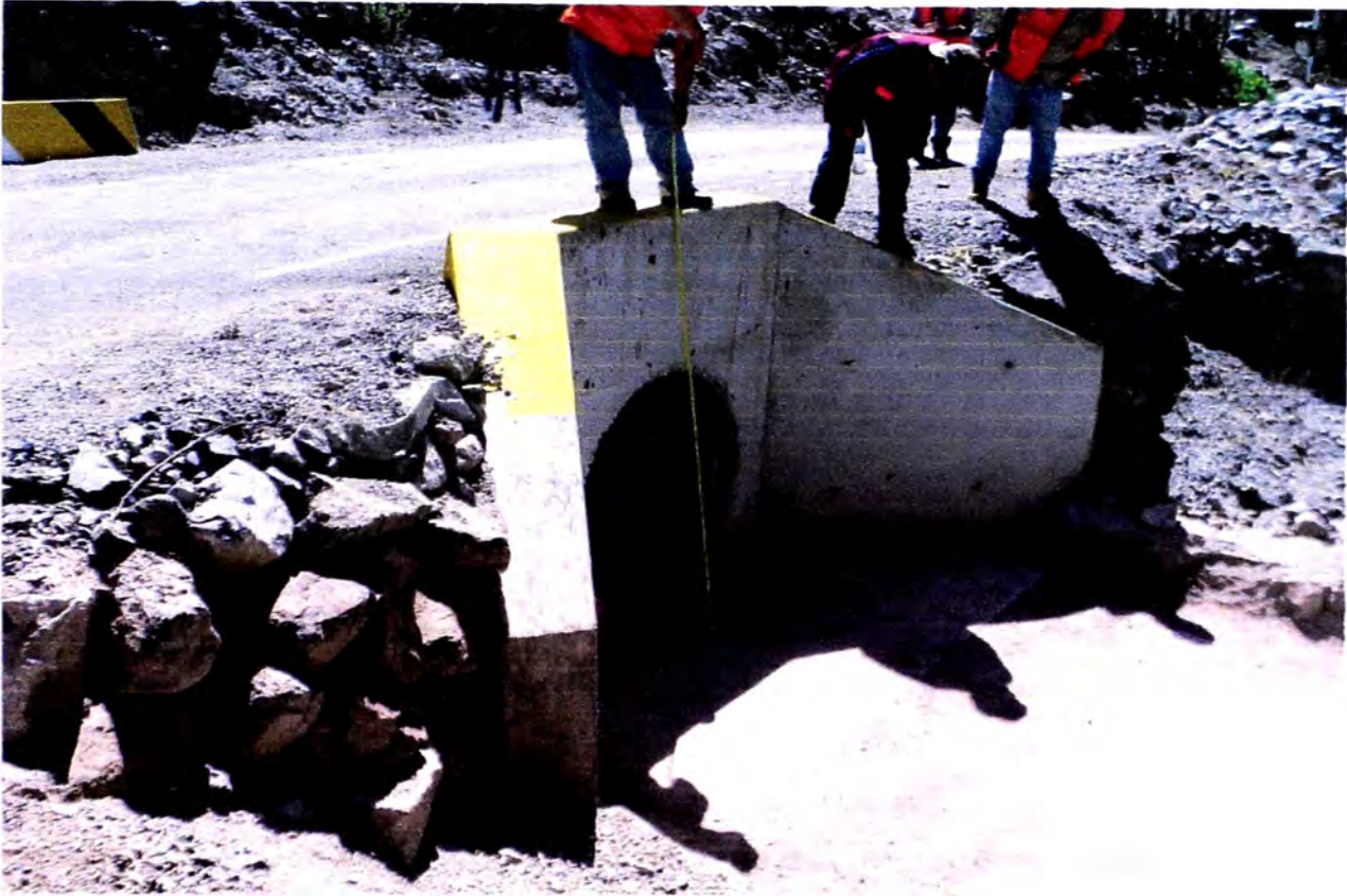
Fotografía 4.21 Alcantarillas en buen estado de mantenimiento
