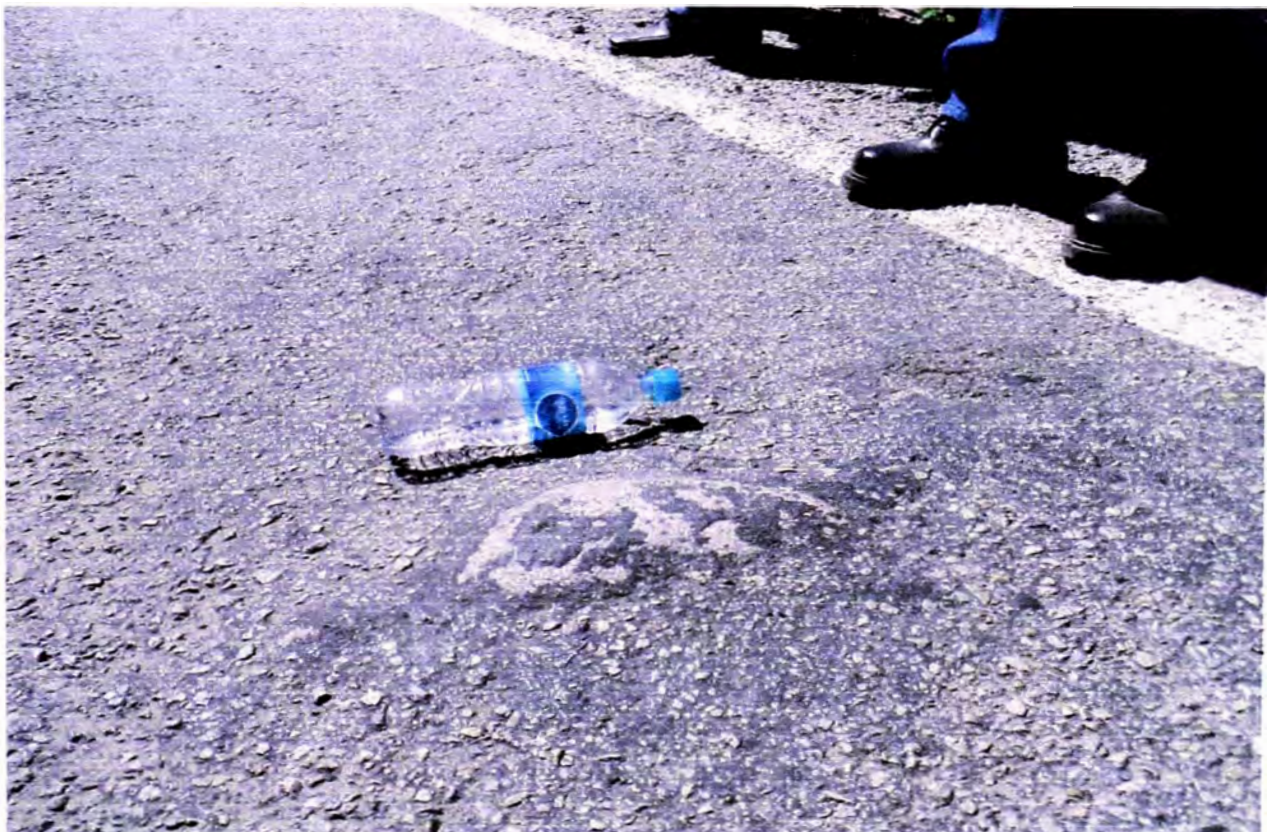
Fotografía 4.06 Levantamiento en el pavimento
