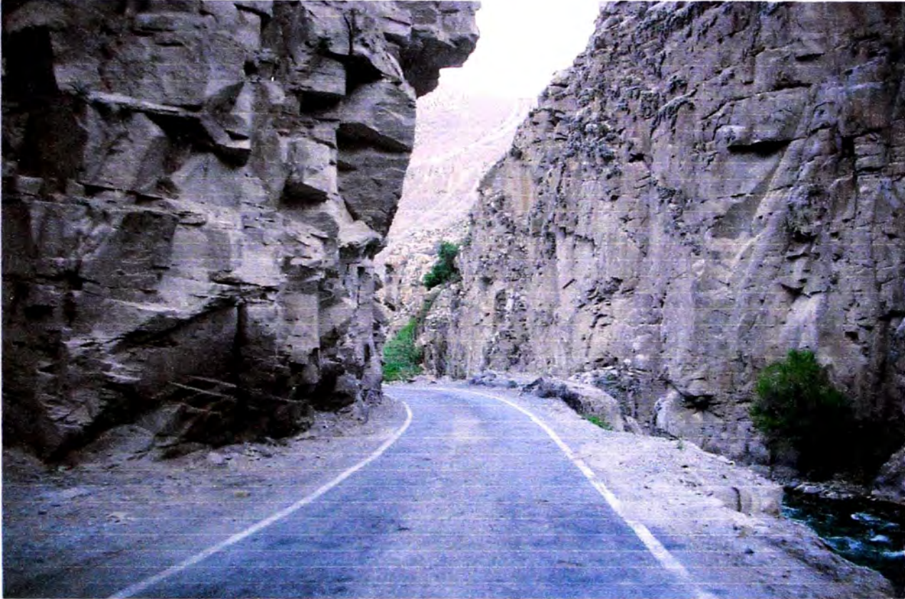
Fotografía 4.11 Talud variable del terreno
