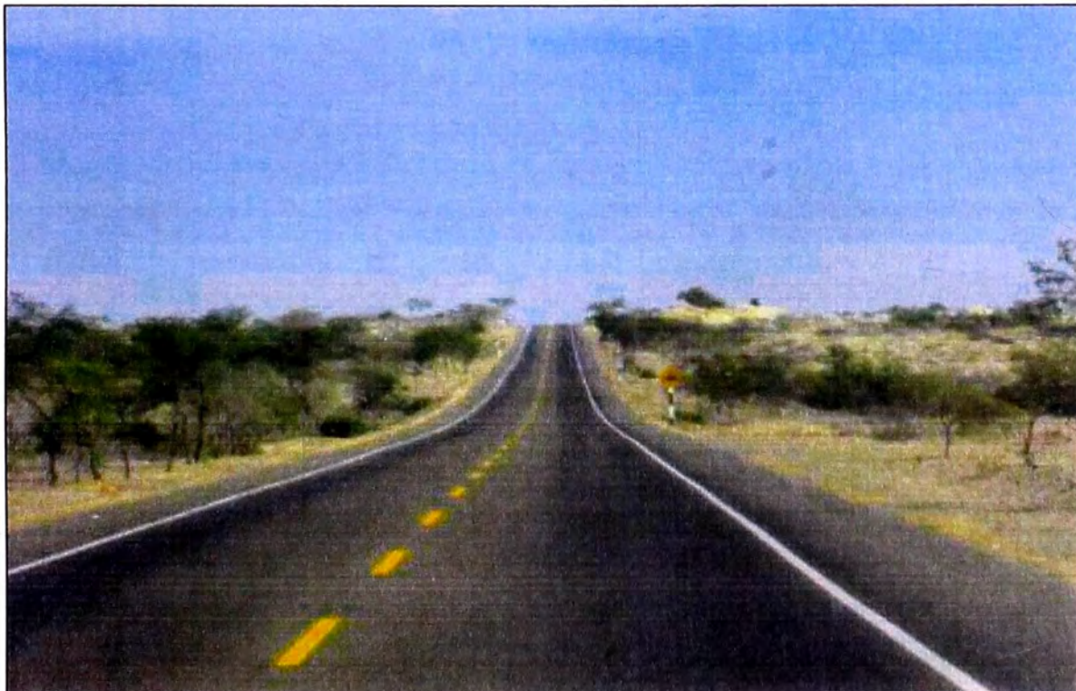
Figura N°1.3 Tramo Paita – Piura. Visita de campo – Jun. 2011 Fuente: Elaboración Propia
