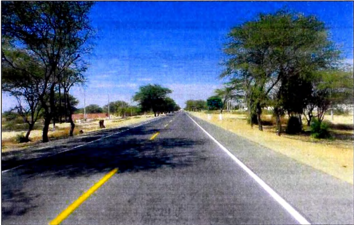
Figura N°1.4 Tramo Piura – Sullana. Visita de campo – Jun. 2011
