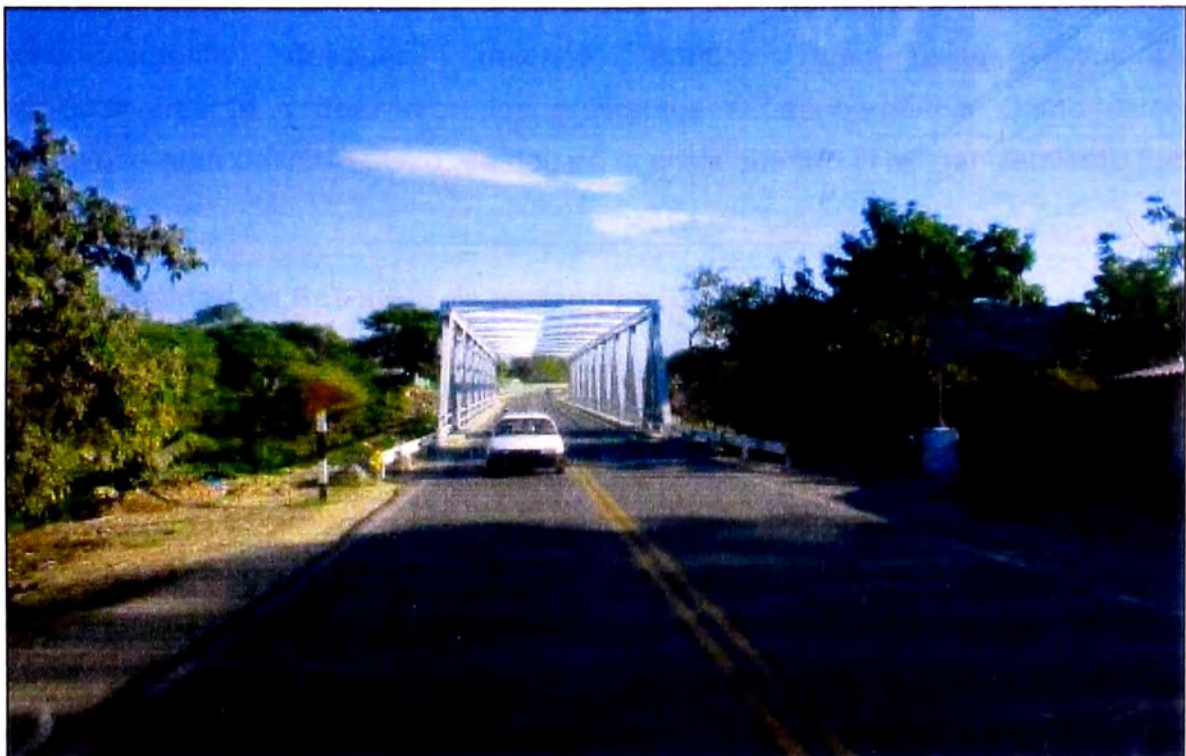
Figura N°1.5 Tramo Sullana – Pte. Macará. Visita de campo Jun. 2011
