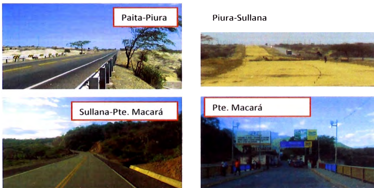
Figura N° 1.8: Características de la carretera por tramos Fuente: Elaboración propia
