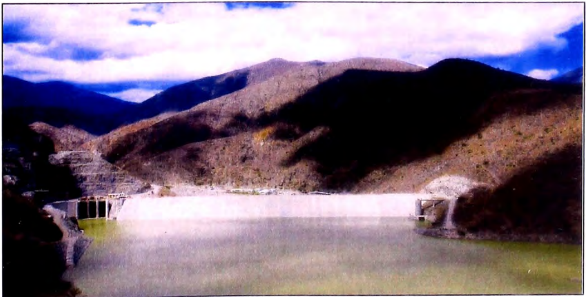
Foto 06: Vista Presa Limón, capacidad de almacenamiento de la presa para la primera etapa es de 44 millones de metros cúbicos de agua. Km 86
