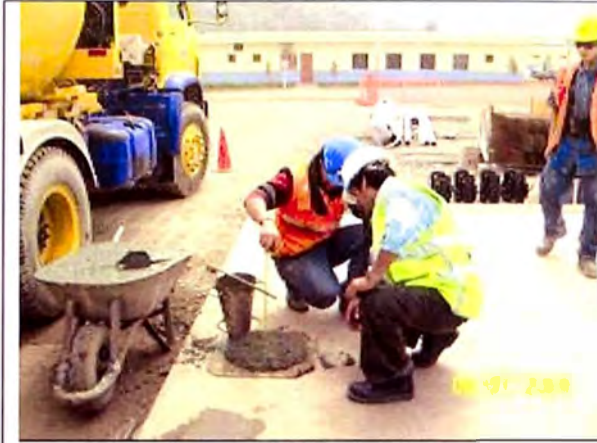
Foto N° 3.19.- Control de la medida del Slump.
