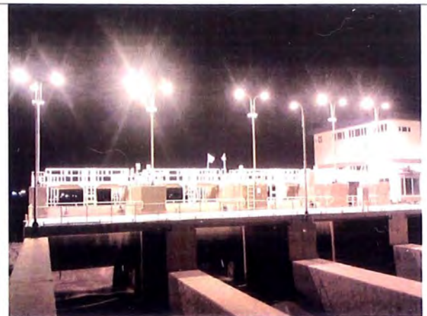
FOTO N°7.8.- Puente de maniobra
