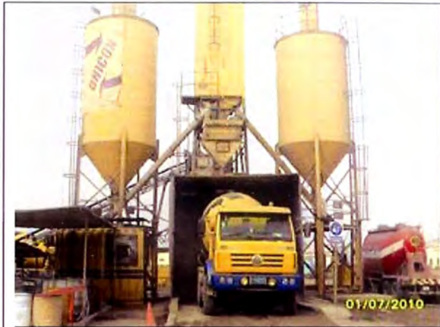
Foto N° 3.17.- Planta concretera de UNICON instalada en obra.
