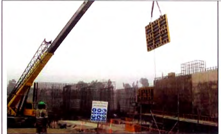
Foto N° 3.31.- Desencofrado del muro del Bocal de Captación.
