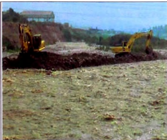
Foto N° 3.05.- Desvío del río Rímac con la ayuda de 02 excavadoras.
