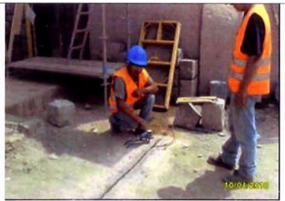
Foto N° 3.35.- Introducción de aire mediante una bomba a través de la válvula.
