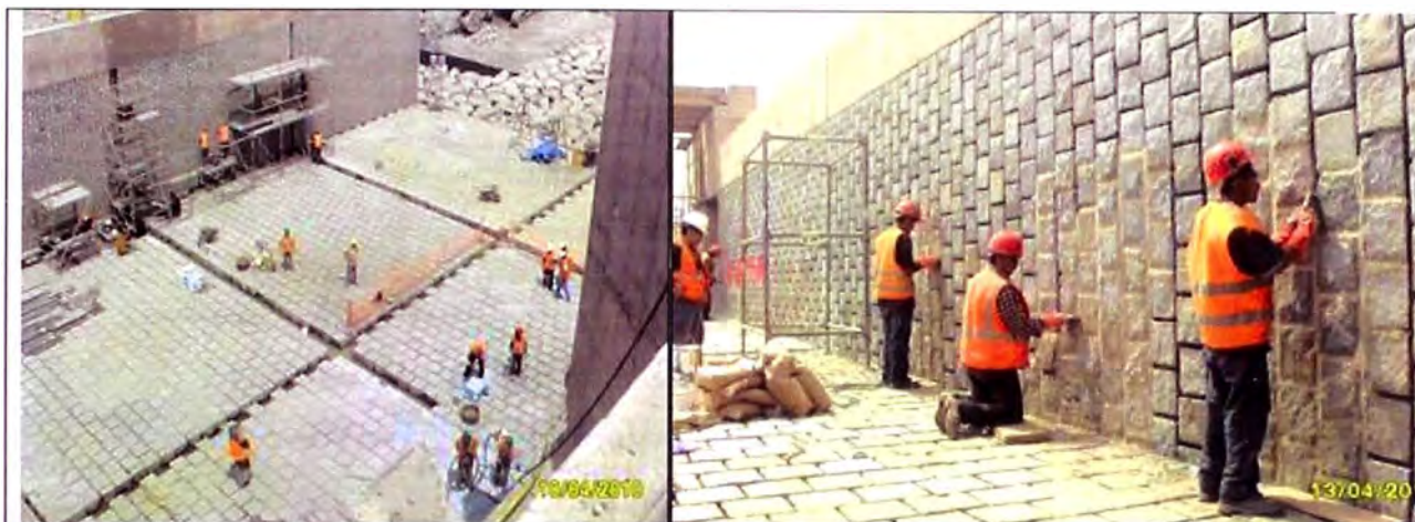
Foto N° 3.37.- Colocación del blindaje con piedras labradas en la Poza de Disipación.
