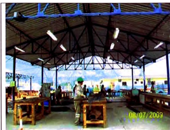
Foto N° 3.01.- Taller de fierreteria
