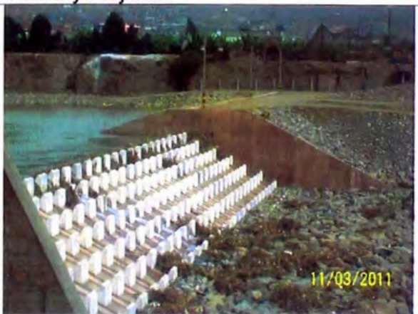
FOTO N°7.6.- Aliviadero Fijo y la Presa no Vertedora.
