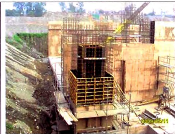
Foto N° 3.15.- Encofrado del buzón N° 05.
