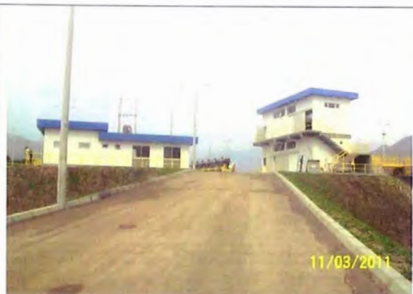
FOTO N°7.2.- Sala de Mando y la Sala de Maestranza
