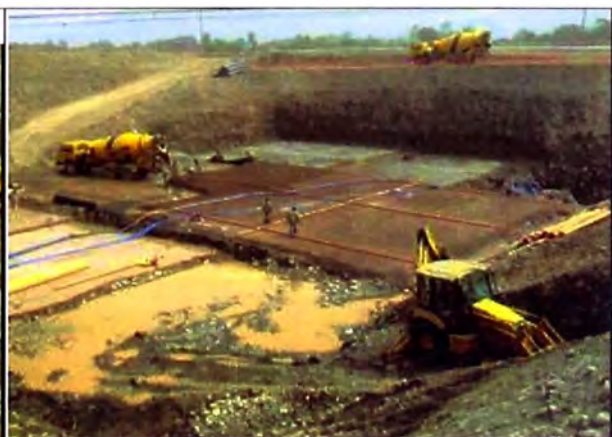
Foto N° 3.14.- Colocación del concreto poroso que cubren las tuberías.
