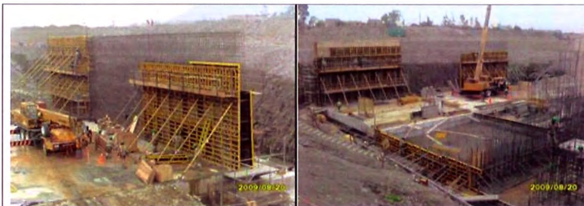
Foto N° 3.21.- Encofrado de los muros de la Poza de Disipación.
