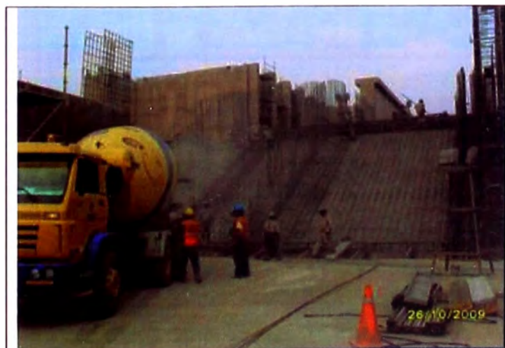
Foto N° 3.28.- Vaciado de concreto f'c=280 kg/cm 2 .
