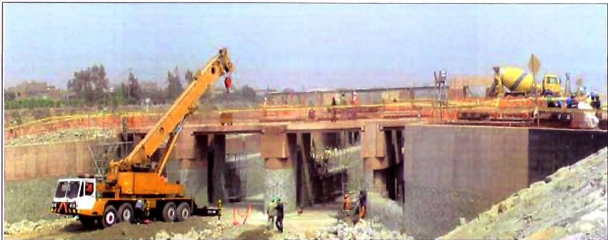
Foto N° 6.56.- Trabajos de montaje y enchapado de rocas labradas en los Canales de Aproximación.
