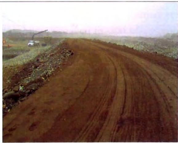
Foto N° 3.06.- Ataguia temporal ejecutado.
