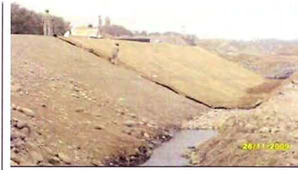
Foto N° 3.11.- Colocación de la arena sobre el geotextil que cubre el dique conformado.
