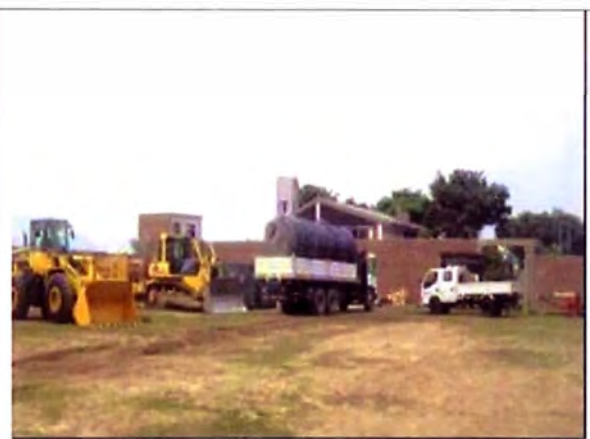
Foto N° 3.04.- Parque de máquinas y equipos pesados en la Planta.
