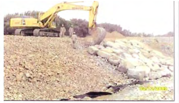
Foto N° 3.12.- Colocación del enrocado en Dique margen derecha.
