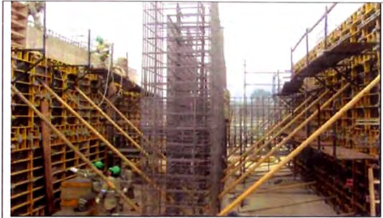
Foto N° 3.27.- Encofrado en los muros del Bocal de Captación.
