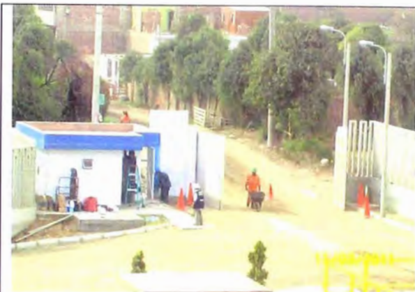
FOTO N°7.1.- Puerta de Ingreso y Garita de Control.
