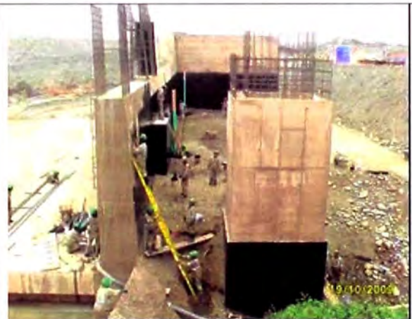
Foto N° 3.16.- Ejecución del sistema de drenaje en la poza e disposición.
