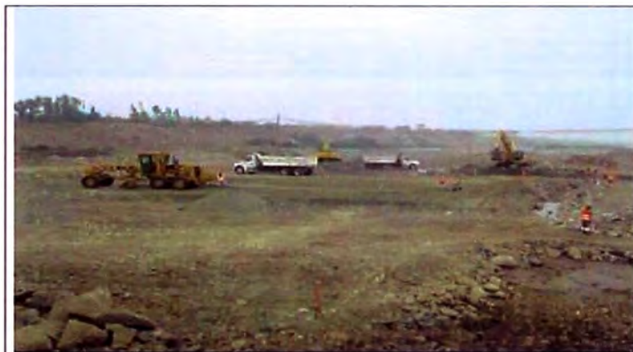
Foto N° 3.25.- Trabajos de Limpieza, Trazos y Replanteo.
