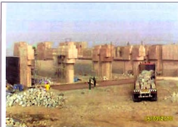
Foto N° 3.23.- Ingreso a los Canales de Aproximación en pleno ejecución.
