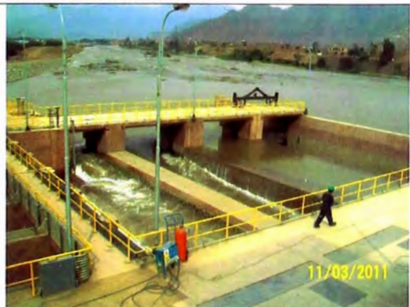
FOTO N°7.5.- Canales de Aproximación del Aliviadero Movil.
