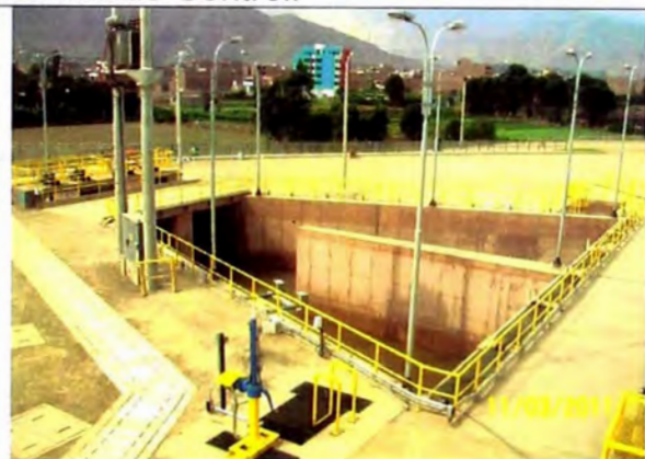
FOTO N°7.3.- Bocal de Captación y la Zona de Transición.
