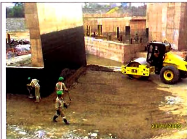
Foto N° 3.09.- Compactación con rodillo liso en los espaldones de los muros de Transición.
