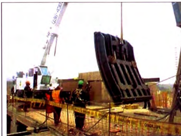
Foto N° 3.39.- Se realiza el izaje de la compuerta radial y se guía con 02 líneas de viento.
