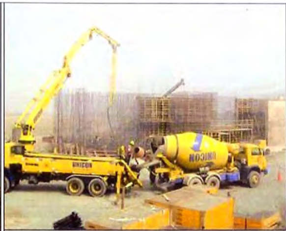
Foto N° 3.18.- Colocación del concreto fresco con bomba de UNICON.
