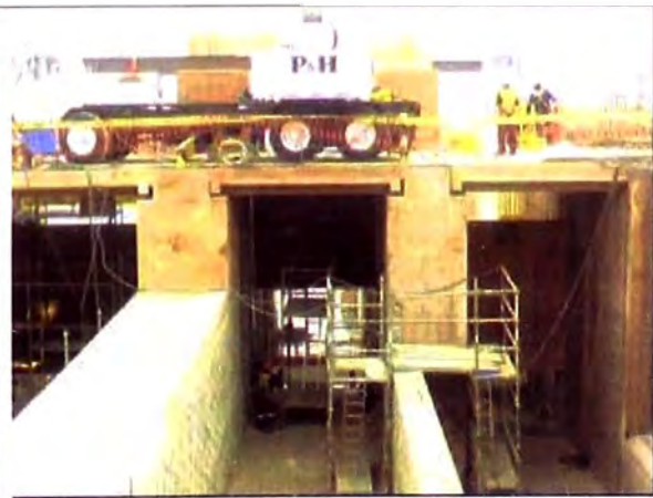
Foto N° 3.40.- Colocación de la compuerta radial en los Canales de Aproximación.
