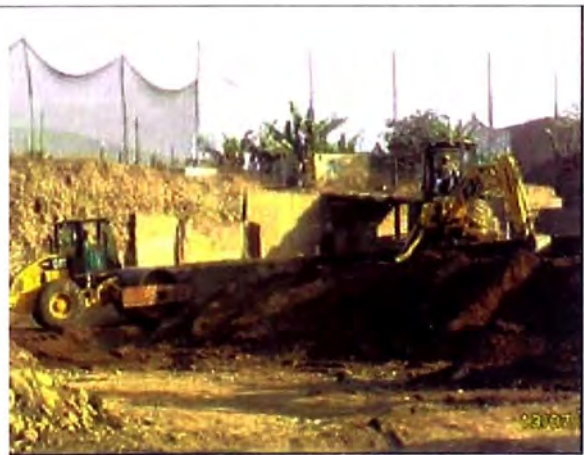
Foto N° 3.10.- Compactación en el área de la Presa no Vertedora
