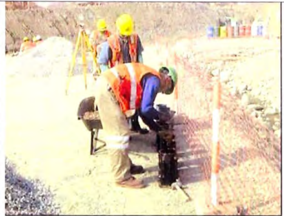
Foto N° 3.20.- Toma de muestra del concreto antes del vaciado.
