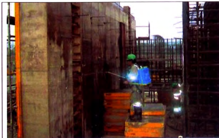
Foto N° 3.32.- Curado a los muros de la Bocal Captación con curador químico.
