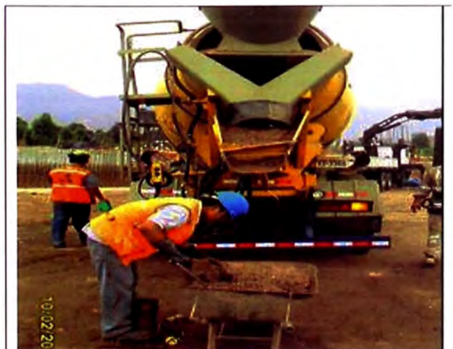
Foto N° 3.30.- Tomando muestras del concreto fresco para verificar la calidad del mismo.
