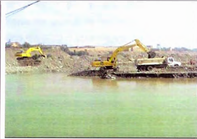
Foto N° 3.07.- Excavación en el área de la Poza de Disipación.
