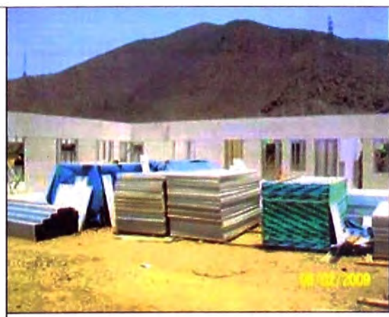
Foto N° 3.02.- Construcción del tópic.
