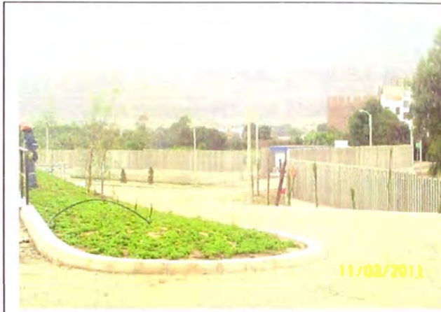
FOTO N°7.7.- Cerco Perimétrico y las áreas verdes.
