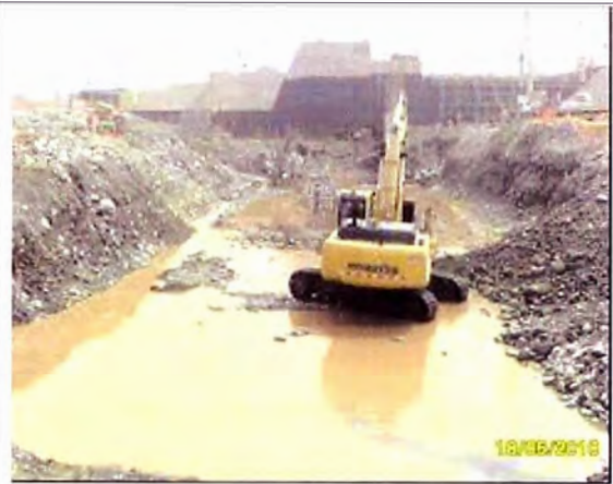
Foto N° 3.08.- Excavación en el área del Barraje Fijo.
