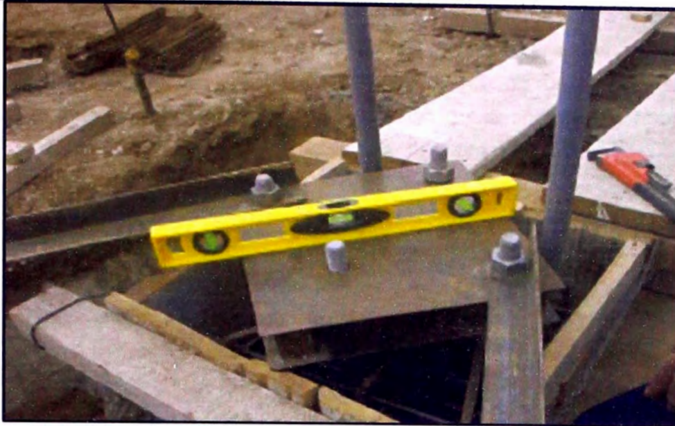
Figura 15.- Verificación de plantilla nivelación
