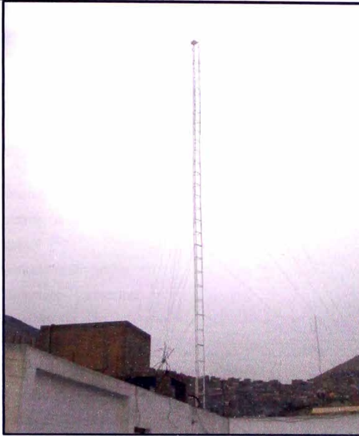
Figura 8.- Torre Ventada
