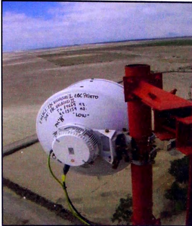
Figura 23.- Soporte de Microondas
