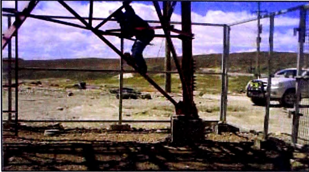
Figura 38.- Vista de la accesibilidad a la EBC
