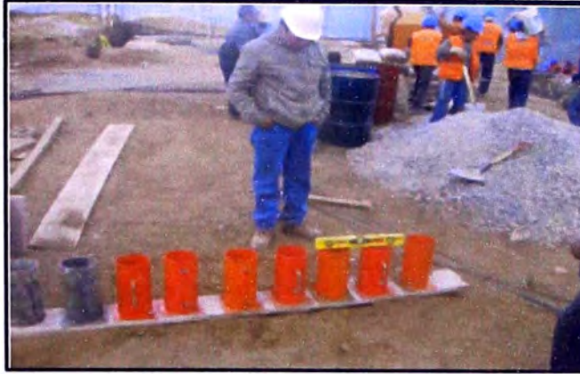
Figura 14.- Vista del vaciado de concreto y elementos de control de calidad.
