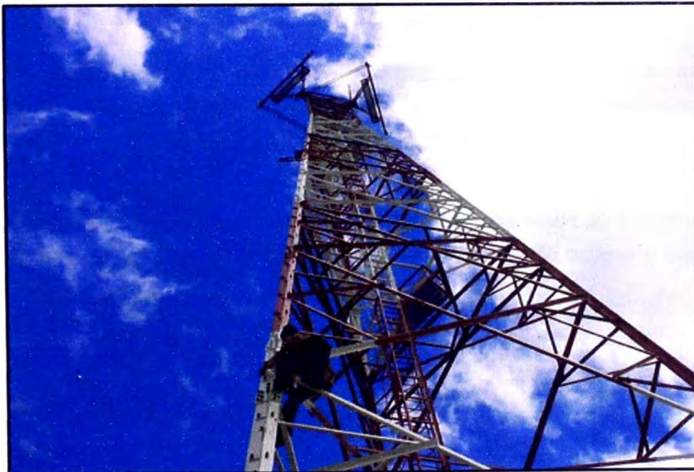
Figura 9.- Torre de base triangular (EBC Real)
