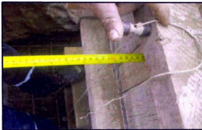
Figura 17.- Verificación de verticalidad del encofrado
