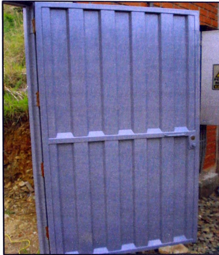
Figura 26.- Vista de puerta metálica
