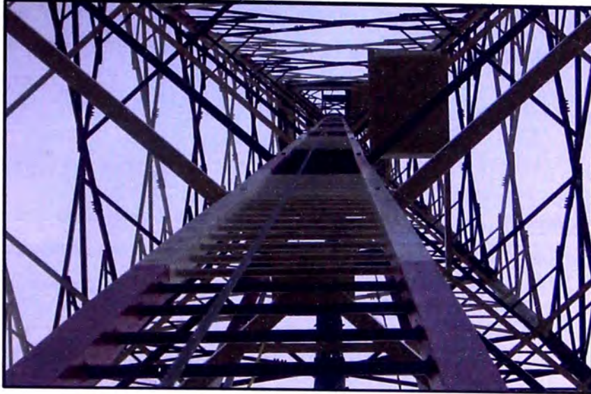
Figura 20.- Vista interior de torre h=42m
