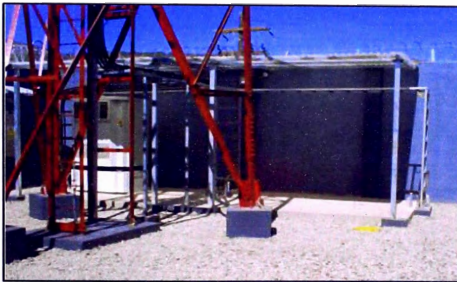
Figura 25.- Escalera Rack (EBC Cabanaconde)
