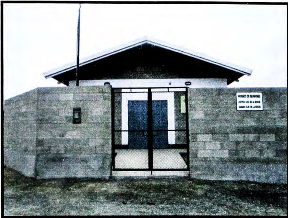
Figura Nº 2.2 Construcción de material noble
