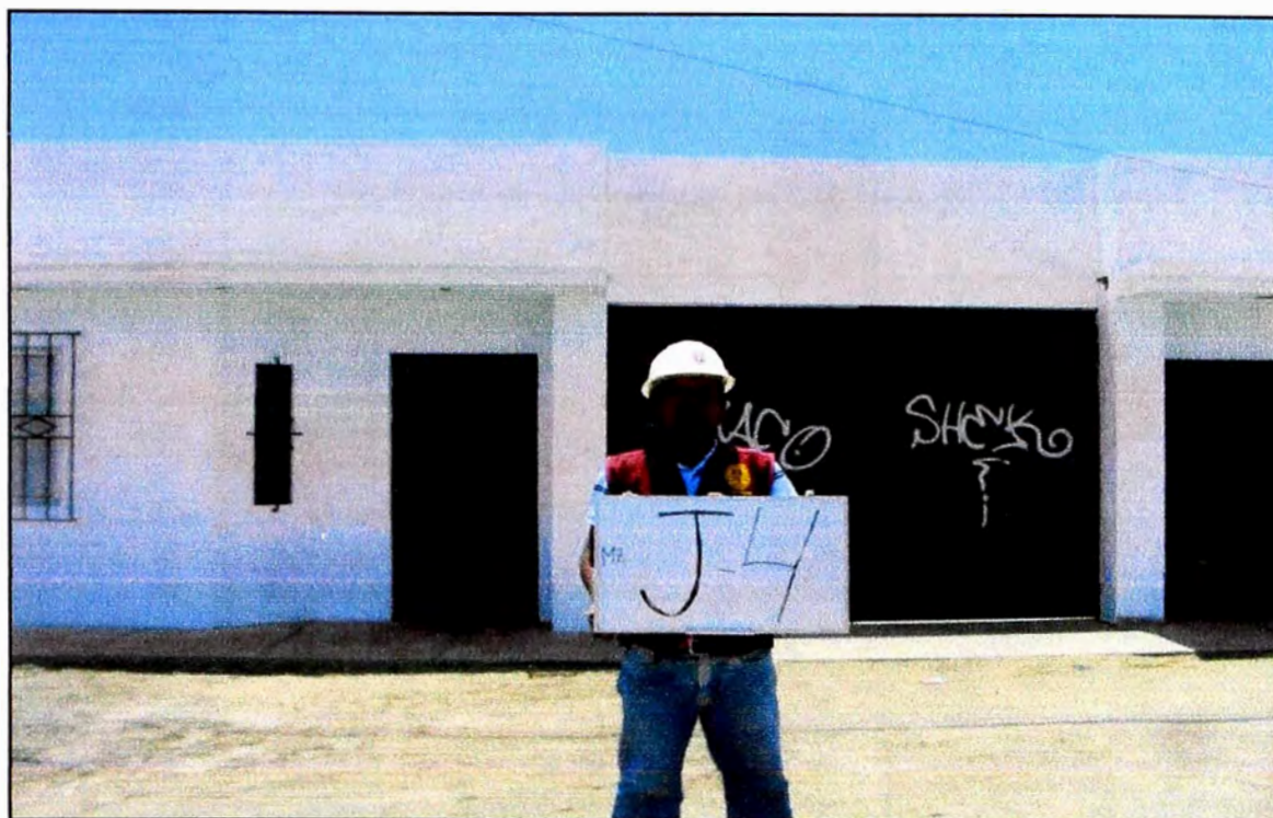
Figura 2.28. Vivienda de albañilería de arcilla en estado de conservación bueno. Mz "93" Lt "4" (Mz "J" Lt "4").
