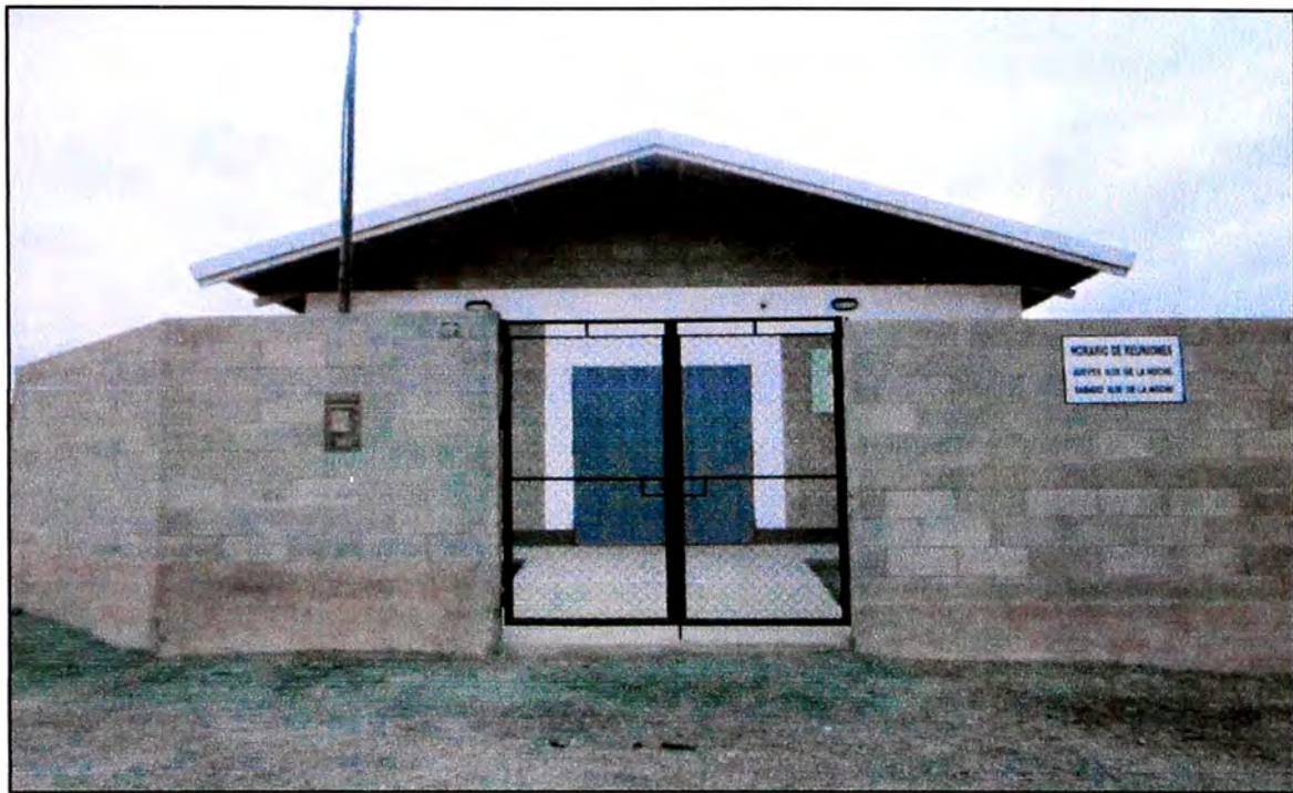
Figura 2.21. Edificación de bloques de concreto. Mz "91" Lt "14".
