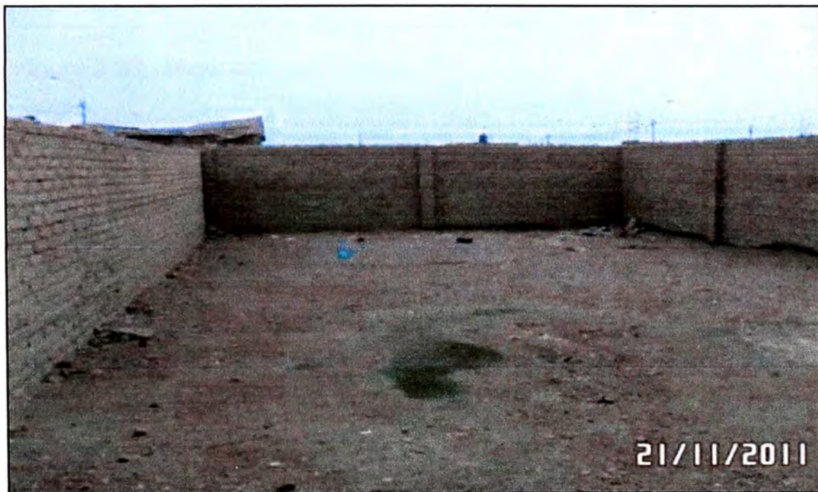
Figura 2.22. Predio vacío, cercado con muros de adobe. Mz "15" Lt "2".
