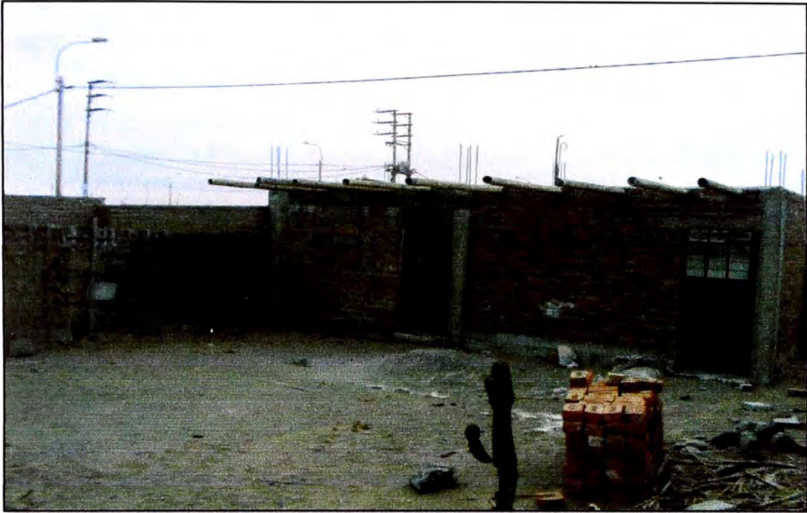
Figura 2.19. Vivienda de ladrillo de arcilla. Techo de caña con barro.
