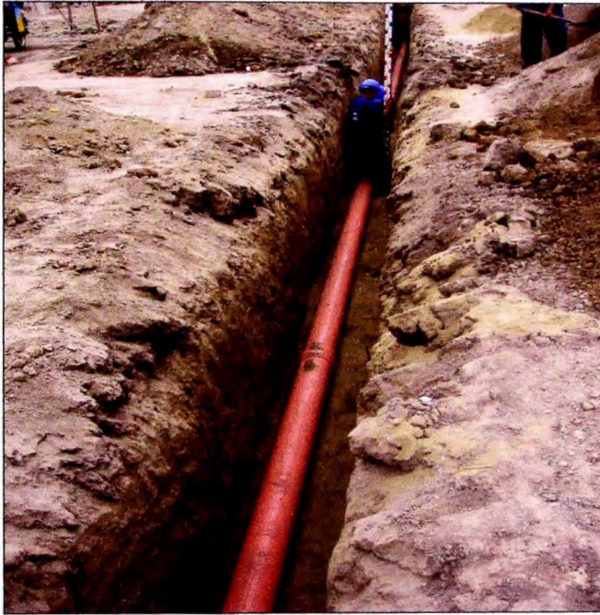
Figura N°3.10 ALINEAMIENTO Y NIVELACION.
