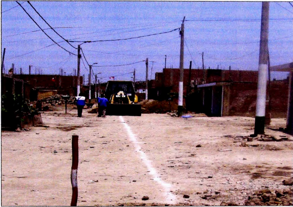
Figura N°3.2 TRAZO Y REPLANTEO
