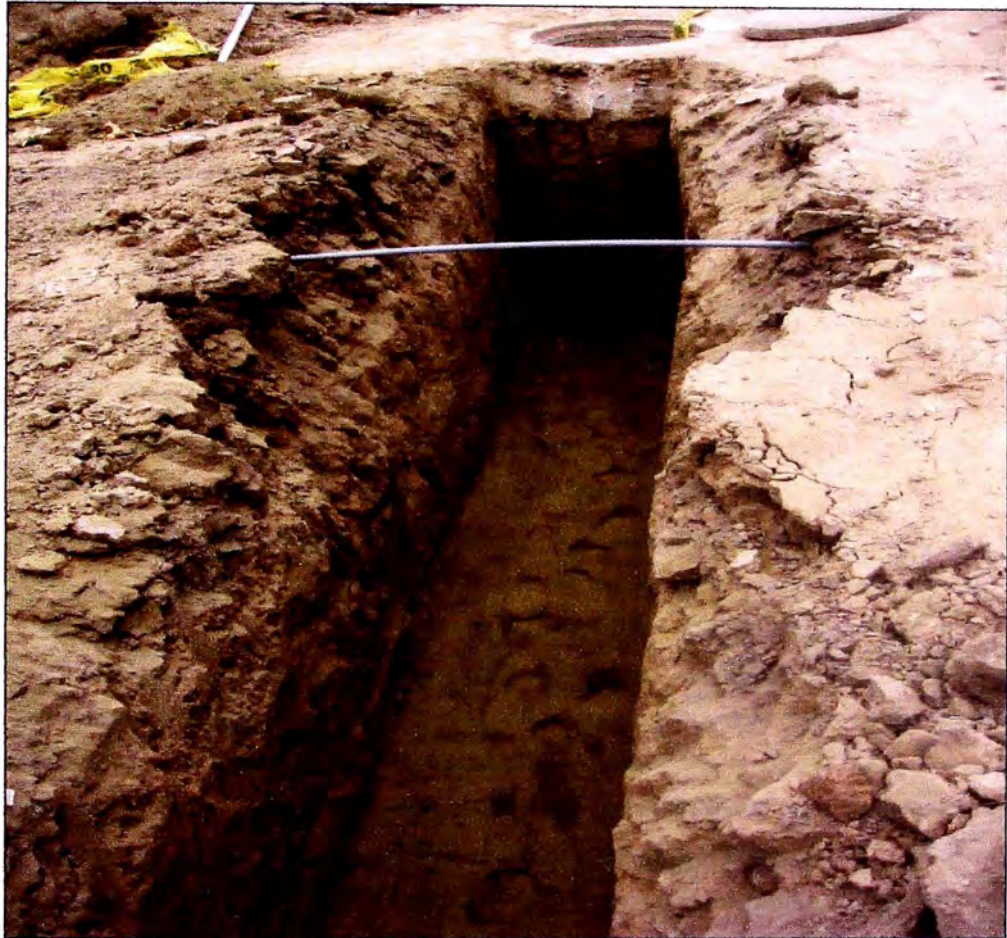
Figura N°3.4 REFINE Y NIVELACION
