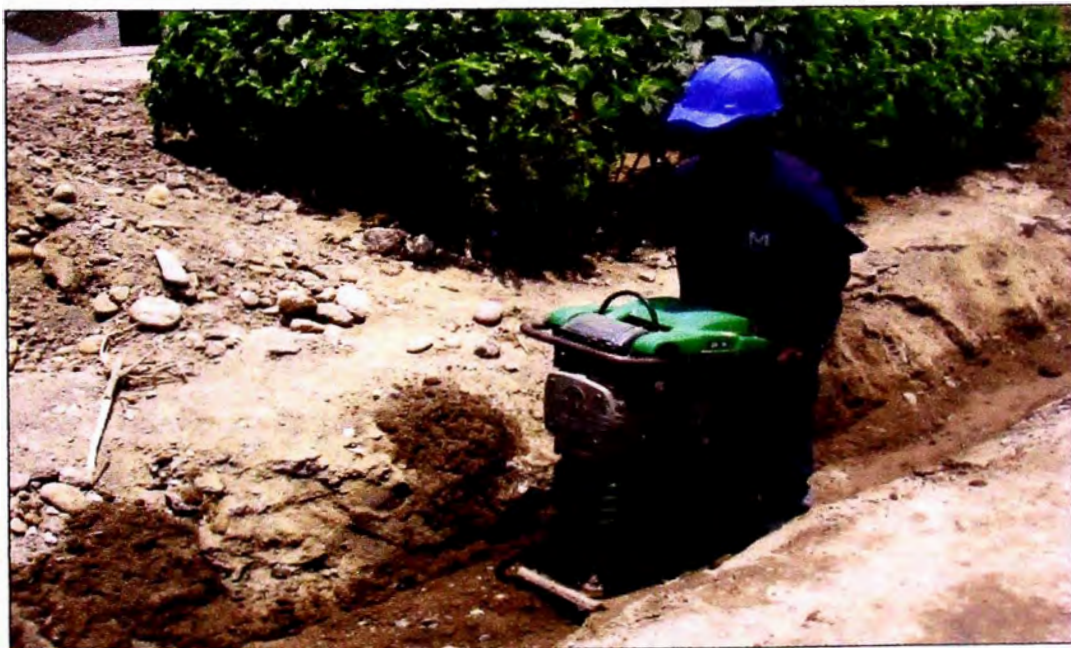
Figura N°3.6 COMPACTACIÓN DE ZANJA
