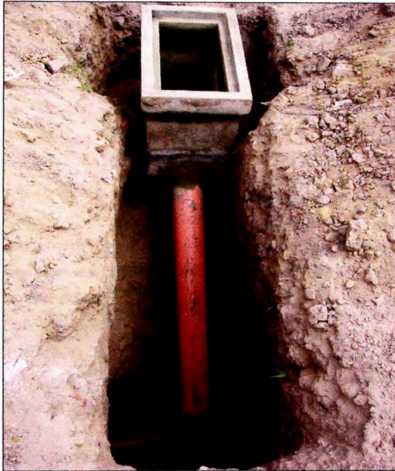
Figura N°4.1 INSTALACION DE CONEXIÓN DOMICILIARIA.
