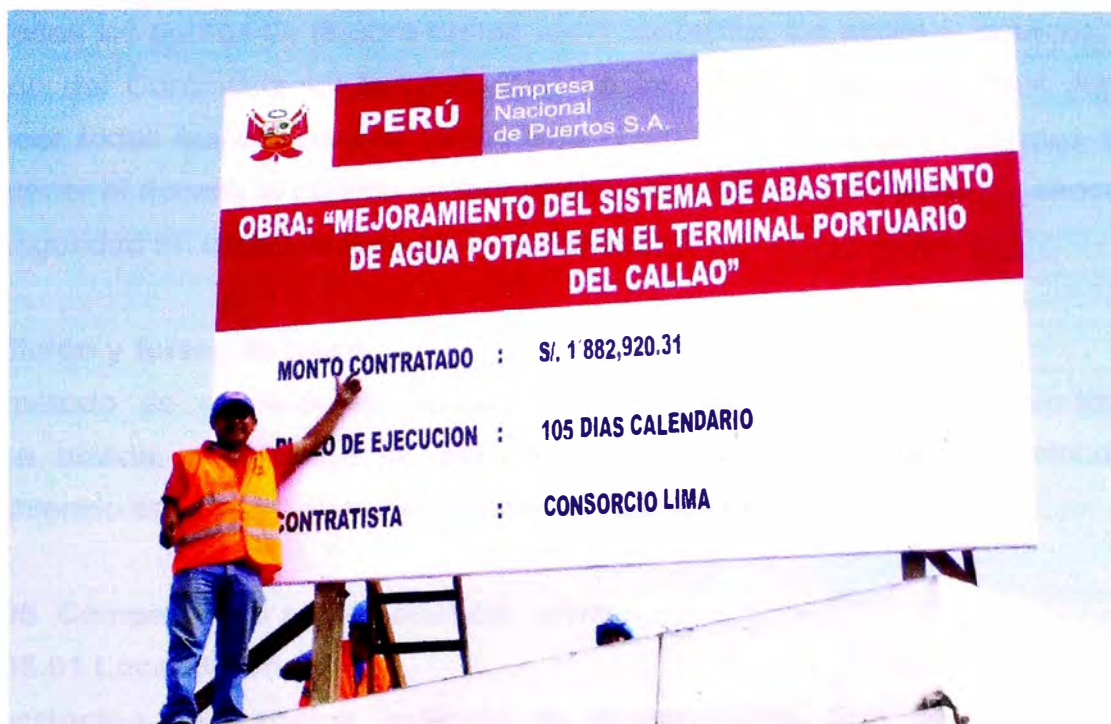
Figura N° 3.1 CARTEL DE OBRA
