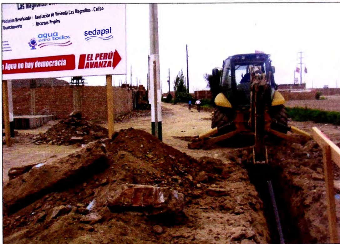
Figura N°3.3 EXCAVACION DE ZANJAS
