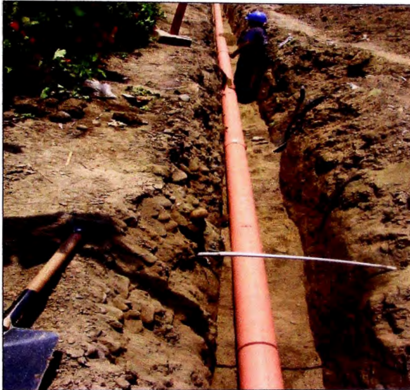
Figura N°3.9 INSTALACION DE TUBERIA.
