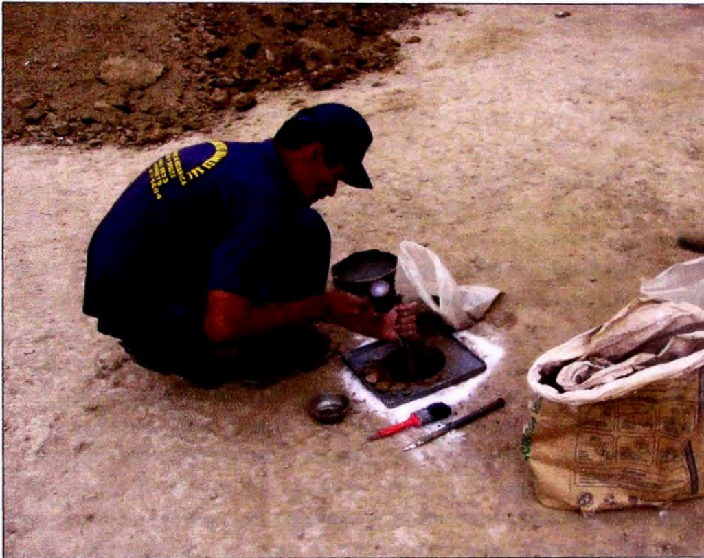
Figura N°3.7 PRUEBA DE COMPACTACION.
