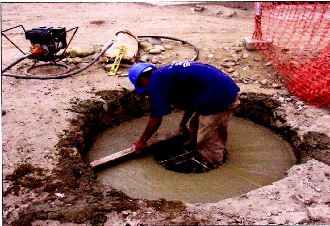
Figura N°3.14 TECHO DE BUZONES.
