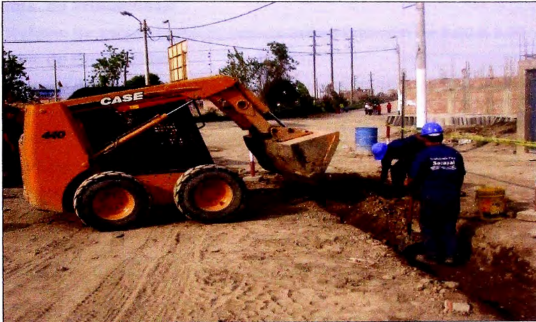
Figura N°3.5 RELLENO DE ZANJA
