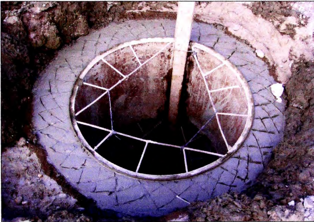
Figura N°3.13 PAREDES DE BUZONES.
