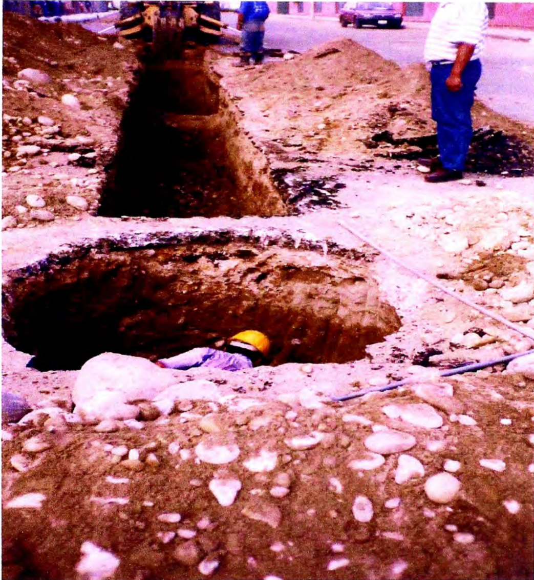
Figura N°3.12 EXCAVACION MANUAL DE BUZONES.
