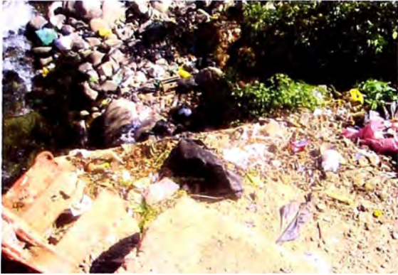
Foto N° 07: (Basura en el puente)
