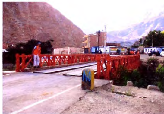
Foto N° 18: (Muretes en acceso izquierdo)
