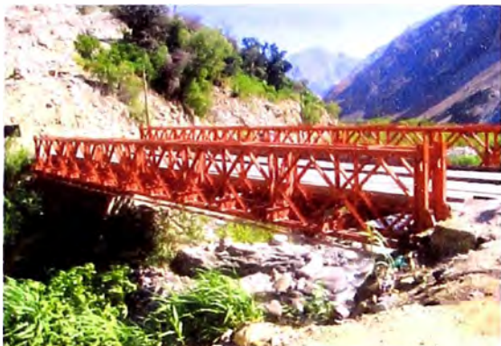
Foto N° 19: (Bolonería vista aguas abajo)
