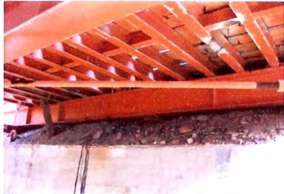
Foto N° 09: (Material granular bajo el puente)
