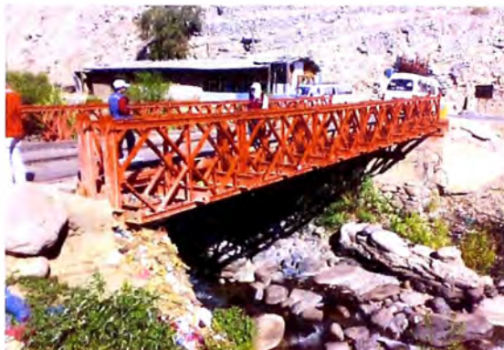
Foto N° 20: (Bolonería vista aguas arriba)
