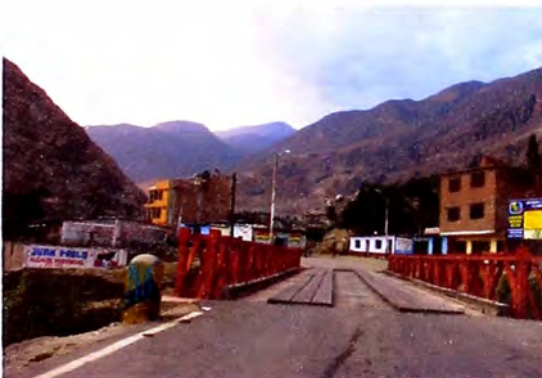
Foto N° 17: (Muretes en acceso izquierdo)
