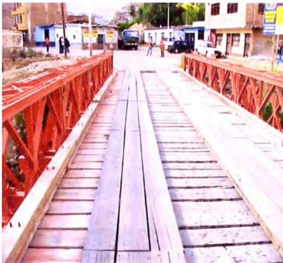
Foto N° 12: (Tablero de madera)
