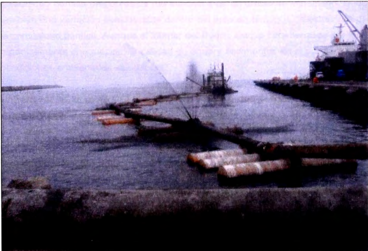
Figura N° 4.8 : Dragas estacionarias existentes.
