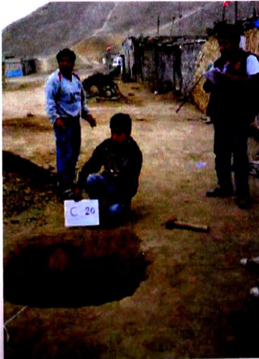
Foto N° 01: Vista panorámica de la Calicata.
