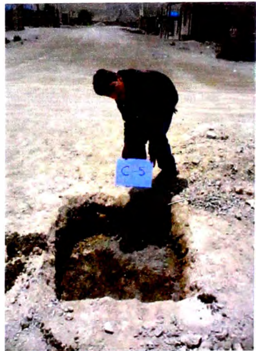
Foto N° 02: Vista del perfil estratigráfico.
