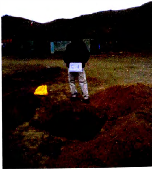
Foto N° 01: Vista panorámica de la Calicata.
