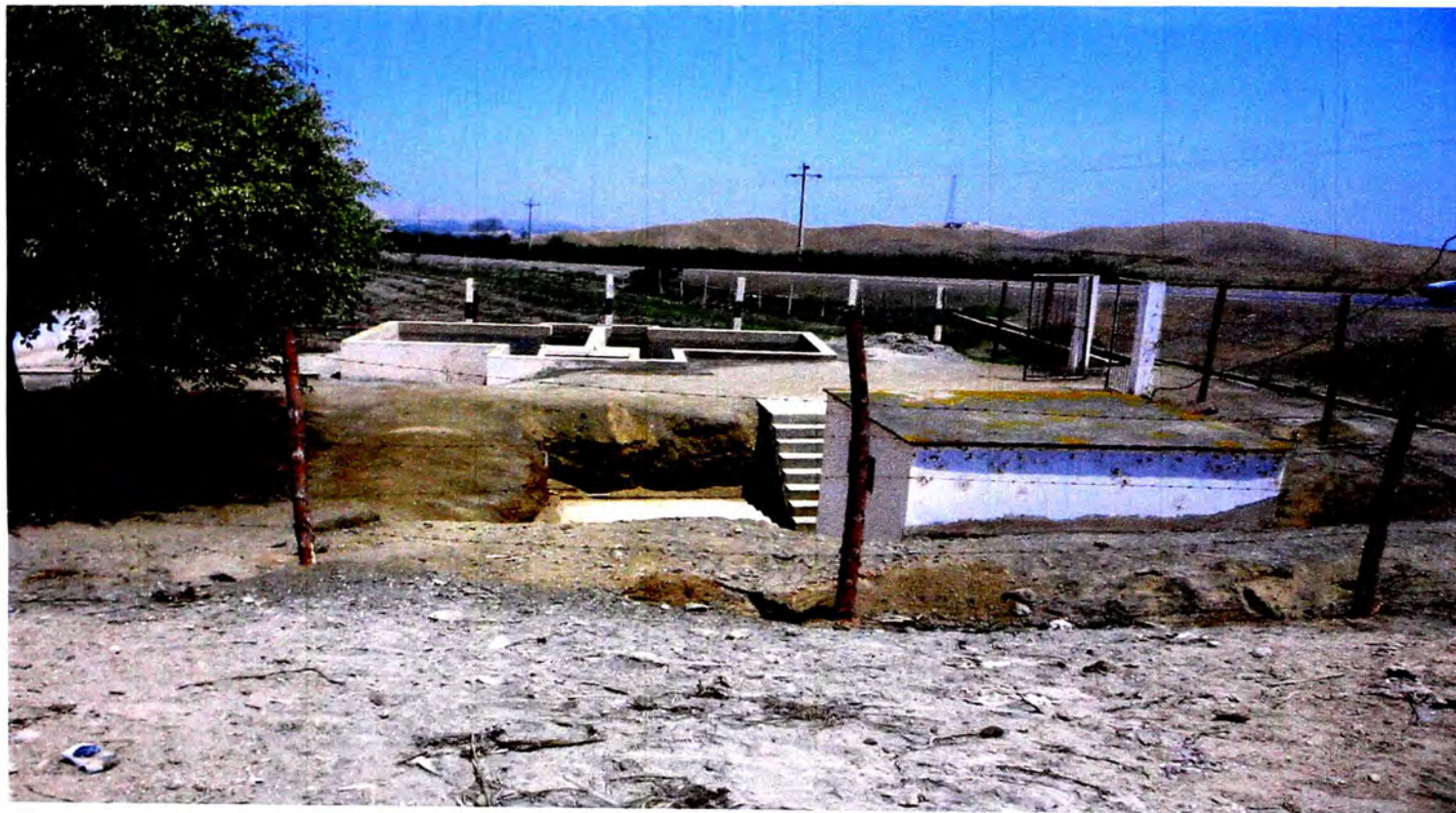
Foto N° 01: Vista panorámica de la planta de tratamiento existente.
