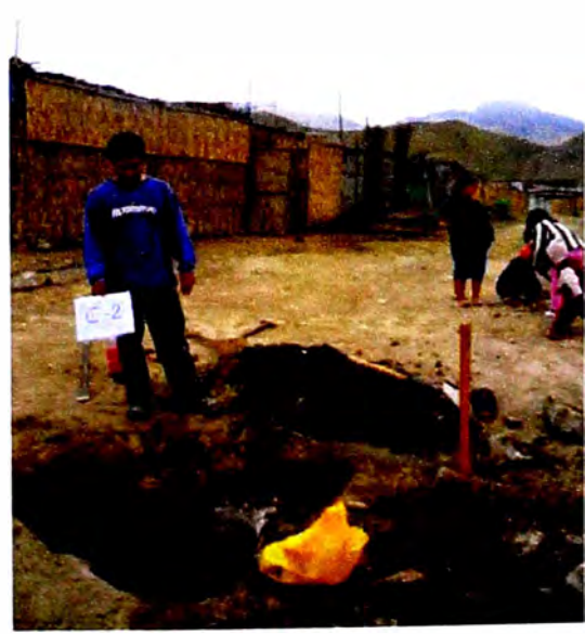
Foto N° 01: Vista panorámica de la Calicata.
