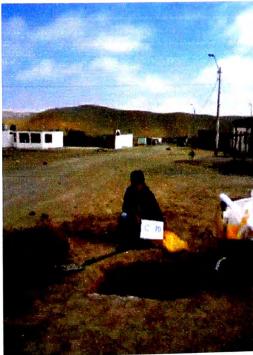
Foto N° 01: Vista panorámica de la Calicata
