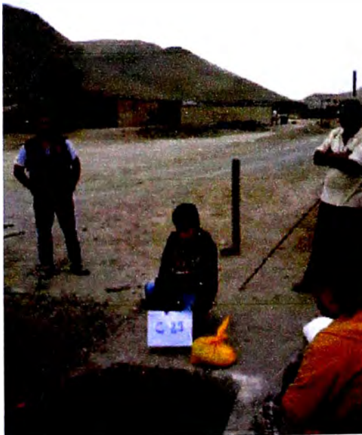
Foto N° 01: Vista panorámica de la Calicata.
