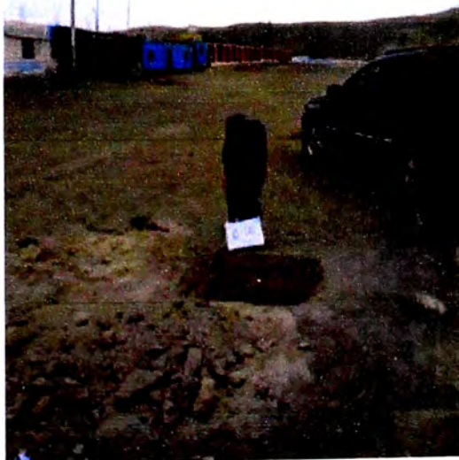
Foto N° 01: Vista panorámica de la Calicata.
