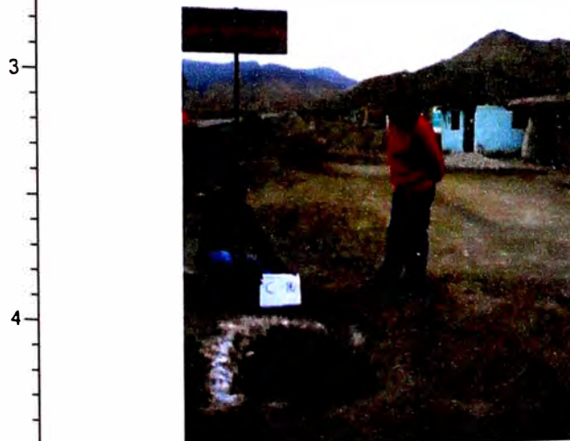
Foto N° 01: Vista panorámica de la Calicata.
