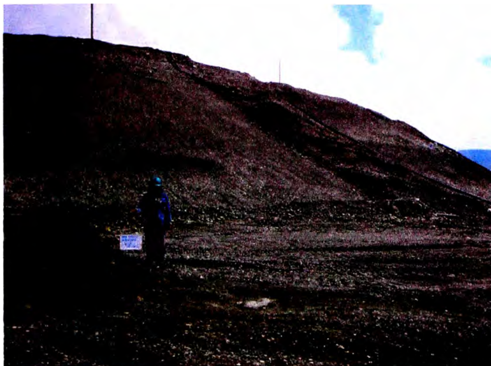
Foto N° 05: Vista del talud Sureste de aguas abajo del Depósito Integral de Relaves N°7
