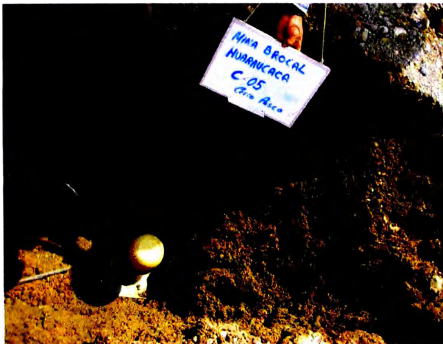
Foto N° 10: Vista del interior de la Calicata C-5 y ensayo de densidad In-situ
