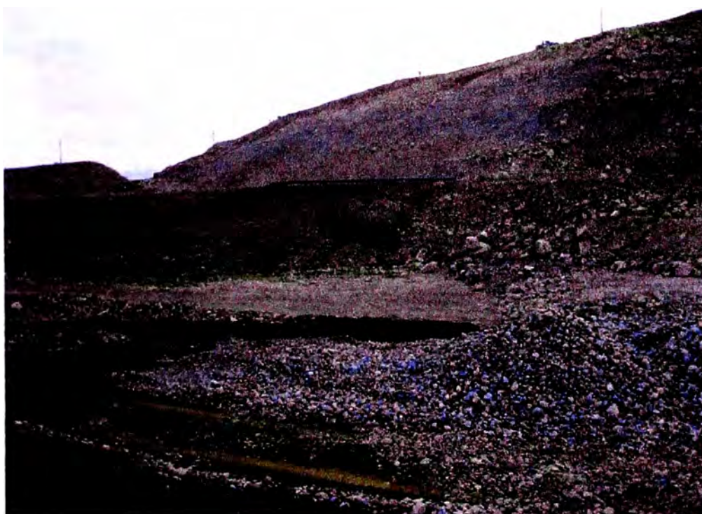
Foto N° 06: Vista del talud Suroeste de aguas abajo del Depósito Integral de Relaves N°7
