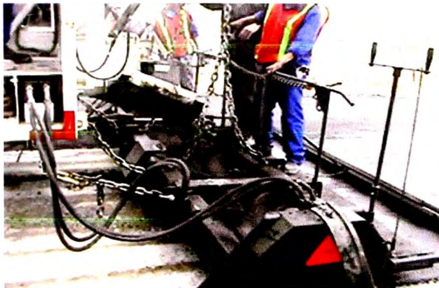
**Figura N° 5.4: Extendido del Slurry Seal**
