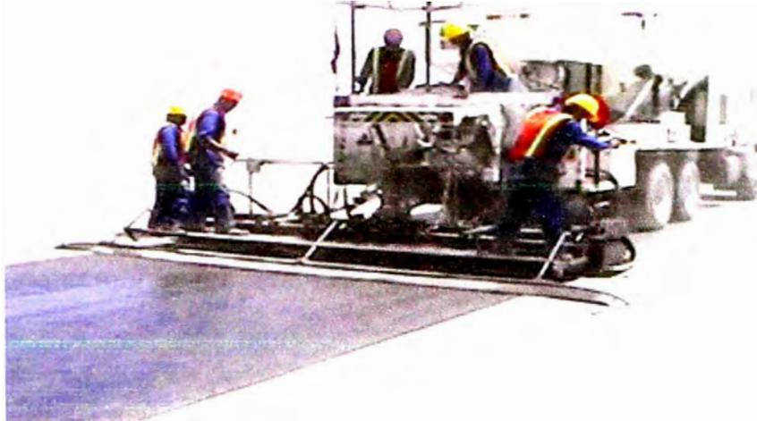
**Figura N° 5.5: Extendido del Slurry Seal con el Camión Slurry**
