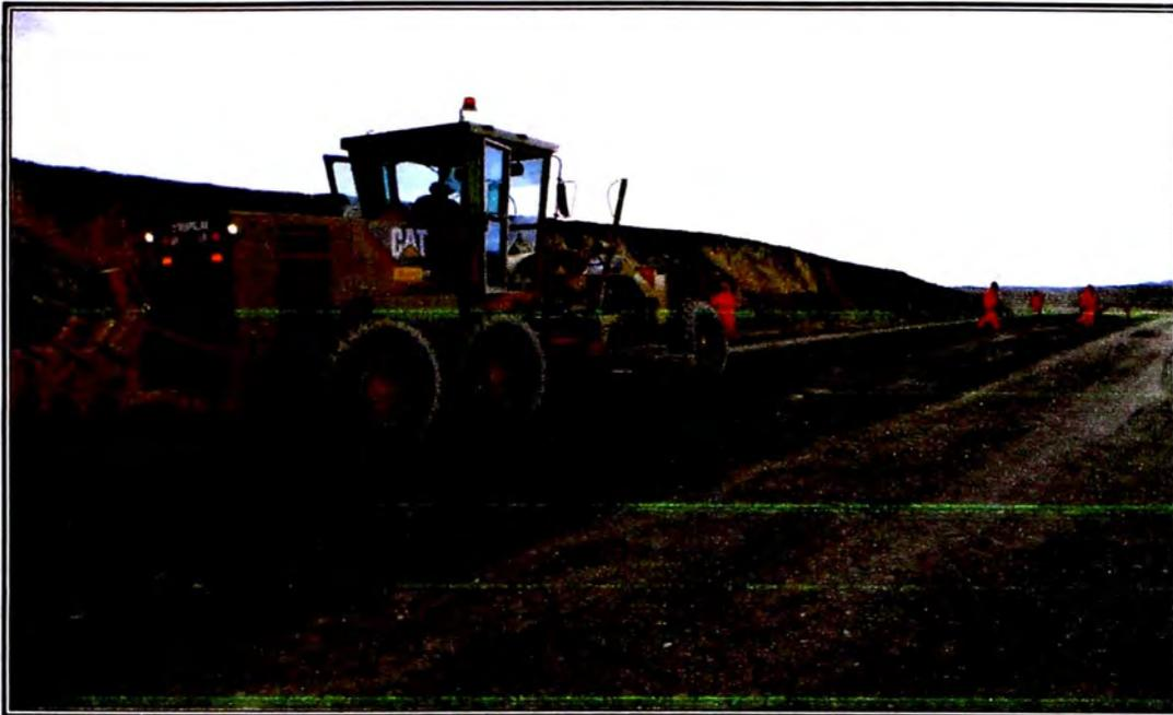
**Figura 2.10: Perfilado y refine con motoniveladora**
