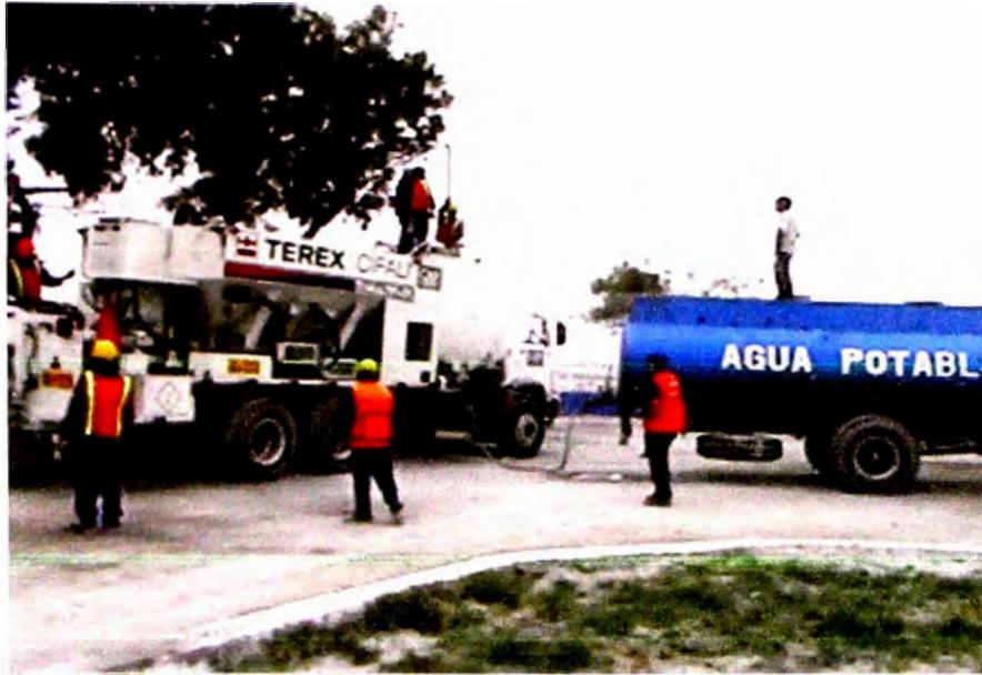
**Figura N° 5.1: Carguio De Agua A La Planta Móvil Extendedora De Micropavimento.**
