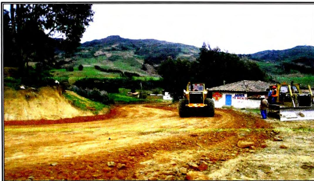
**Figura 2.11: Conformación y compactación de afirmado  $e=0.20m$**
