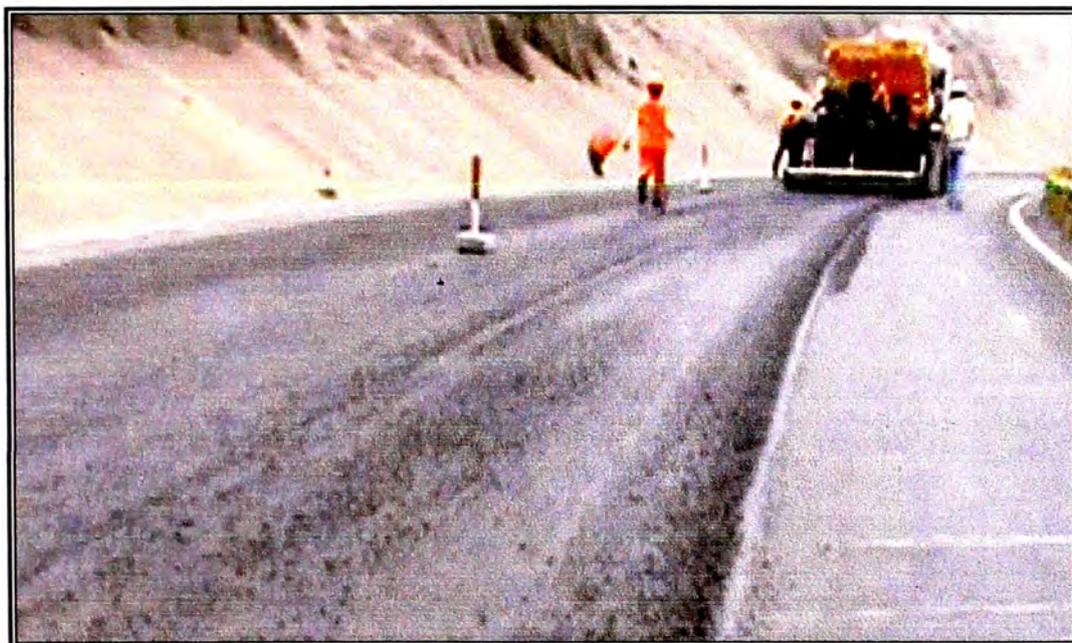
**Figura 2.13: Colocación de la mezcla con emulsión  $e=0.05m$**
