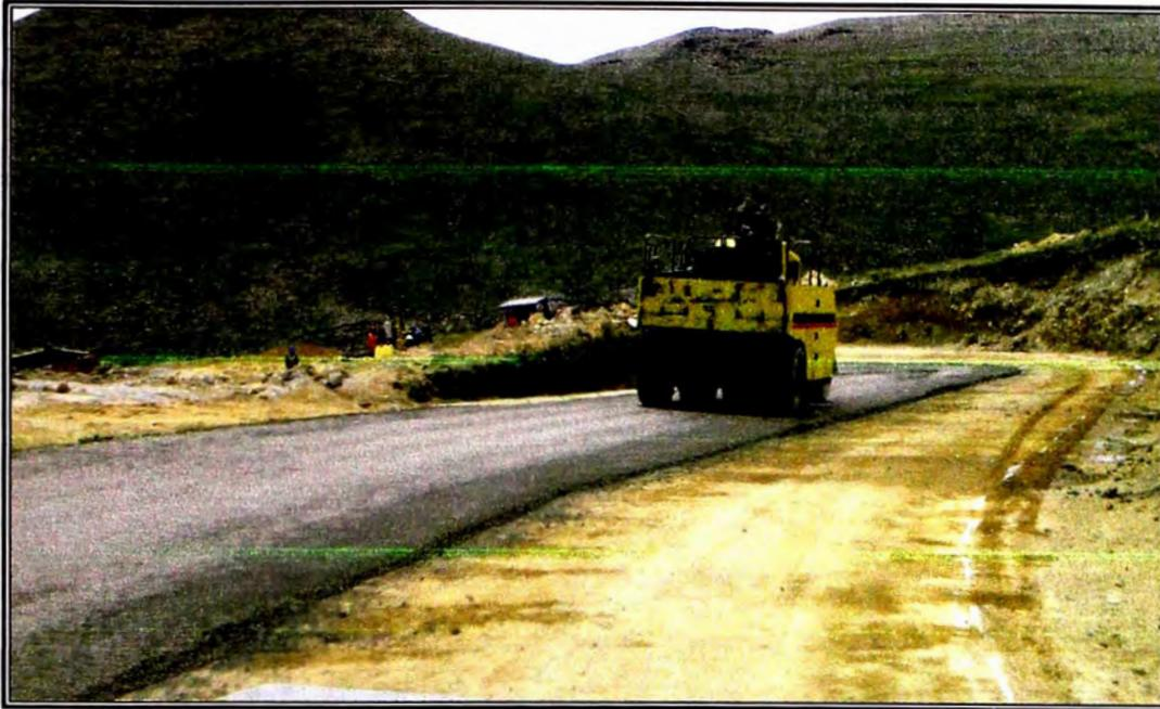
***Figura 2.14: Compactación de la base estabilizada con emulsión con rodillo neumático.***
