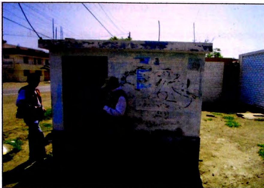
Figura N° 08: Estación de rebombeo en San Isidro-Végueta
