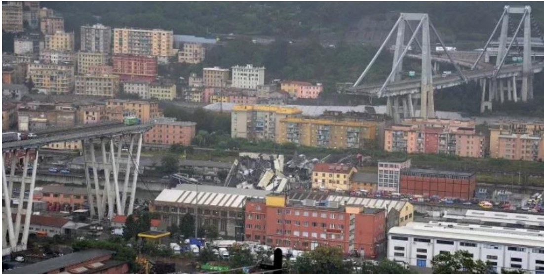
Figura 2. Puente Morandi (Génova) después del accidente
