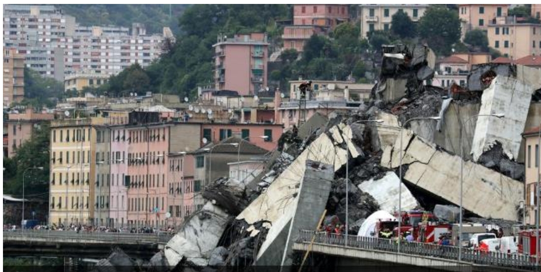
Figura 7. Monitoreo y mantenimiento periódico de puentes para prevenir accidentes
