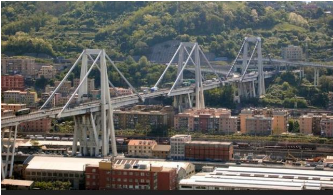
Figura 1. Puente Morandi (Génova) antes del accidente
