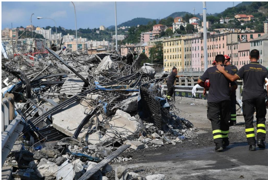
Figura 5. Corrosión y ataque químico en estructuras, oscilaciones por viento con caída por frecuencia resonante
