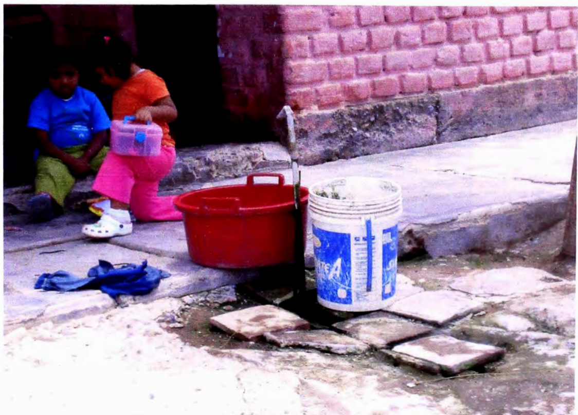
FOTO 4: CONEXIÓN DOMICILIARIA DE AGUA POTABLE FUERA DE LA VIVIENDA
