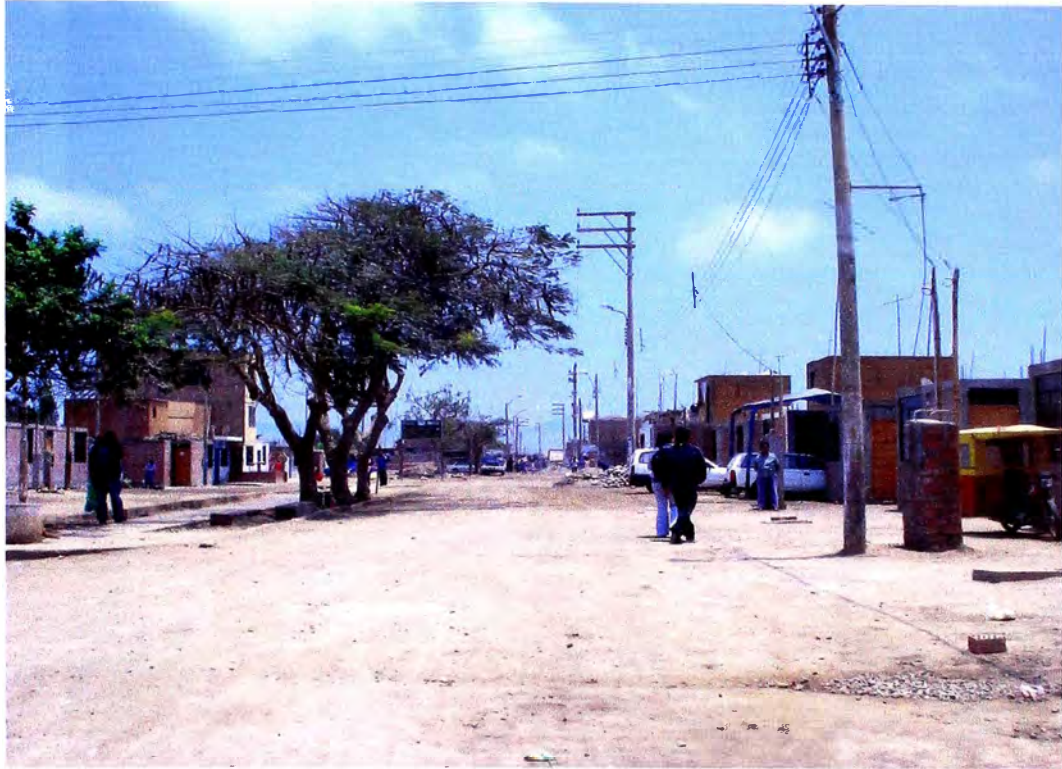
FOTO 5: VISTA DE LA CALLE PROGRESO POR DONDE SE HA PROYECTADO EL PASO DE LA RED DE AGUA POTABLE
