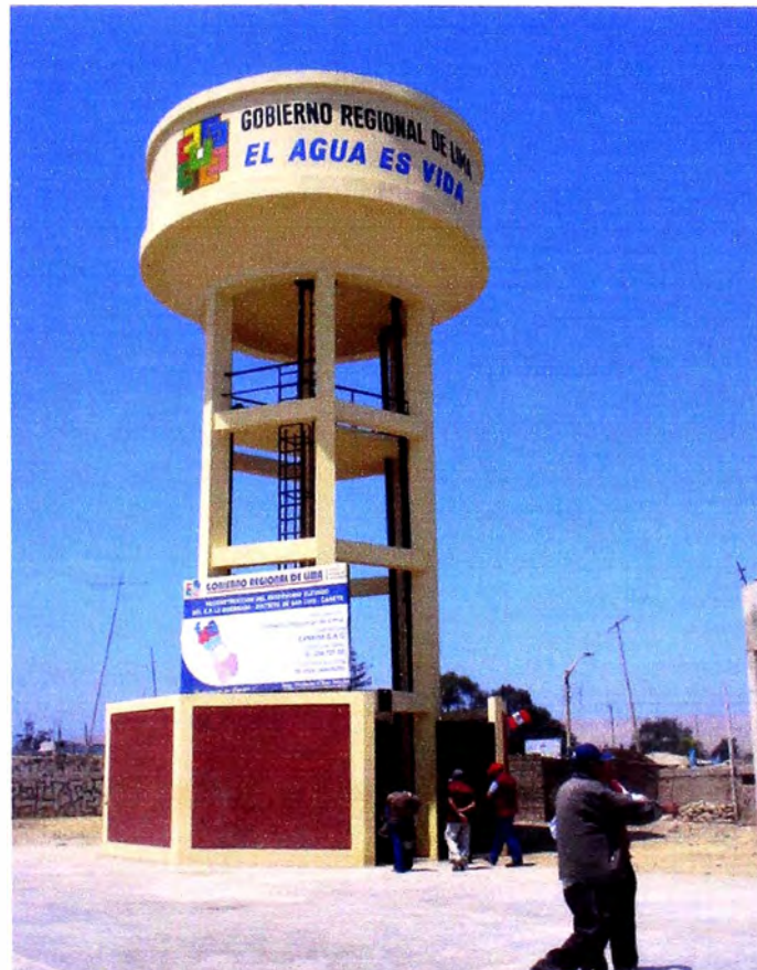
FOTO 6: VISTA DEL RESERVORIO NUEVO QUE ABASTECE DE AGUA POTABLE AL CP LA QUEBRADA
