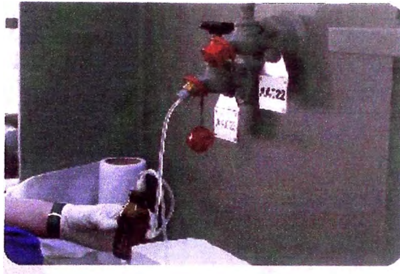
Fig. 5.2. Diagnóstico del Transformador. Toma de muestra de aceite dieléctrico.
