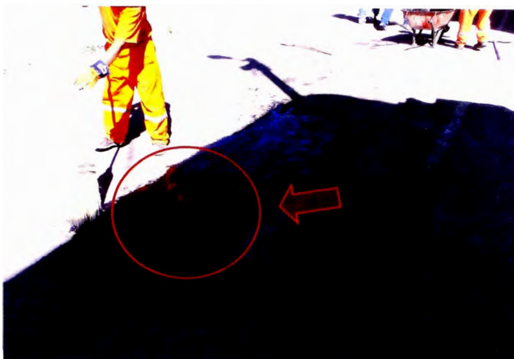
Foto N°11: En la foto se aprecia la aplicación del cemento asfáltico para el parchado de la vía, poblado puente Auco Km 115+240.
