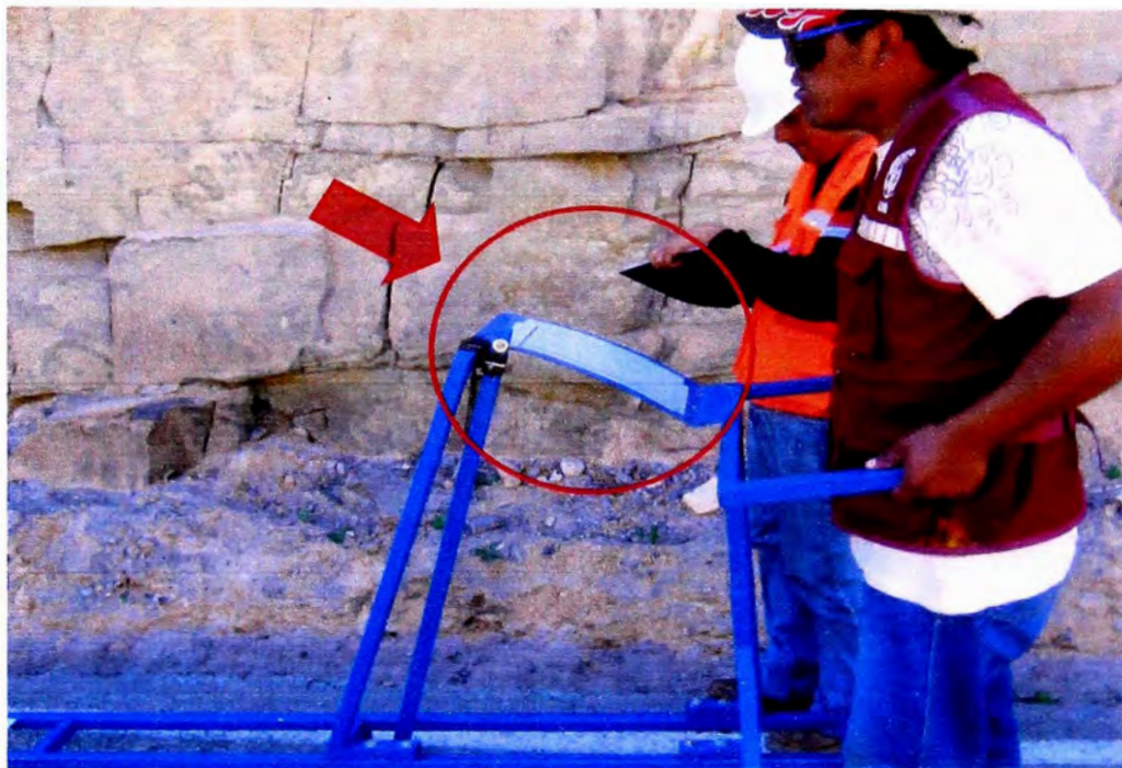
Foto N°04: Aquí también se aprecia la hoja pegada al tablero con las divisiones para obtener los datos de rugosidad, Km 115+620.
