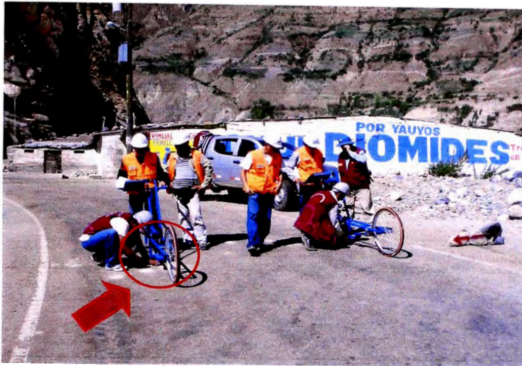
Foto N°01: En la foto se aprecia el instante en que el equipo MERLIN se calibra para posteriormente realizar el ensayo, Km 115+200.
