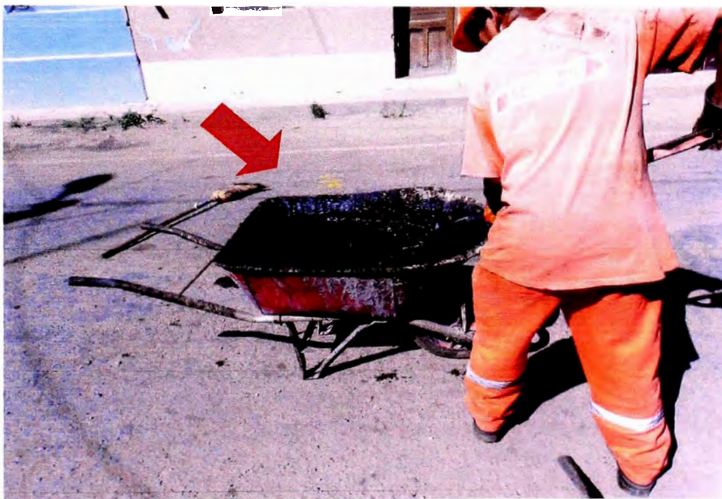
Foto N°10: Se puede apreciar en la foto el material con el cual se realizará el mantenimiento de la vía, caserío puente Auco Km 115+240.
