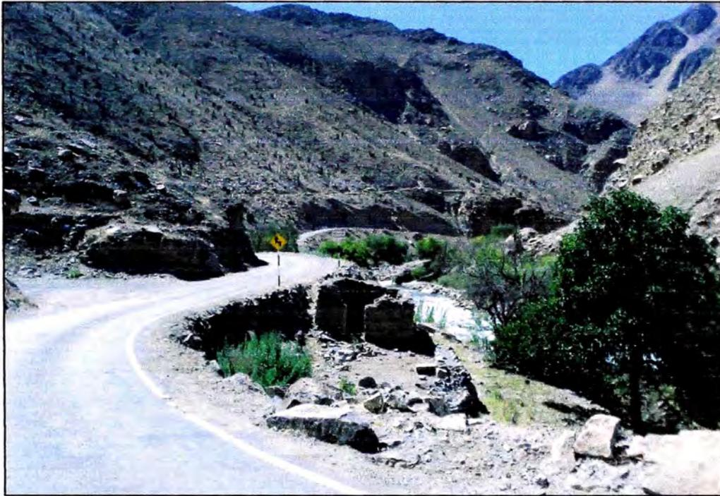
**Fotografía N° 11:** Curva sinuosa, no existe longitud de transición.
