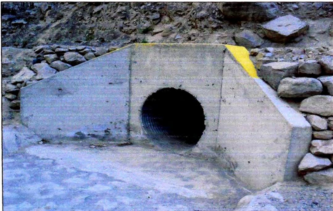
**Fotografía N° 6:** Enrocado para protección de alas de alcantarilla.
