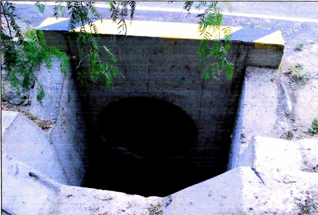
**Fotografía N° 5:** Acumulación de agua en alcantarilla.
