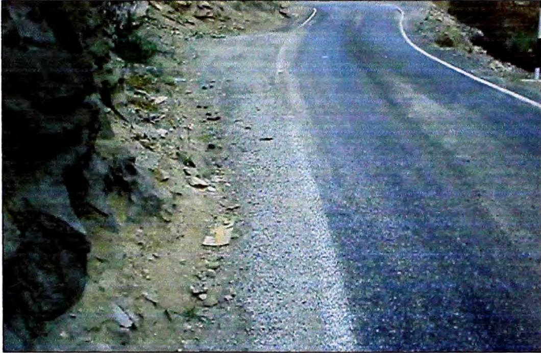
**Fotografía N° 9:** En algunos tramos no existen cunetas transversales.
