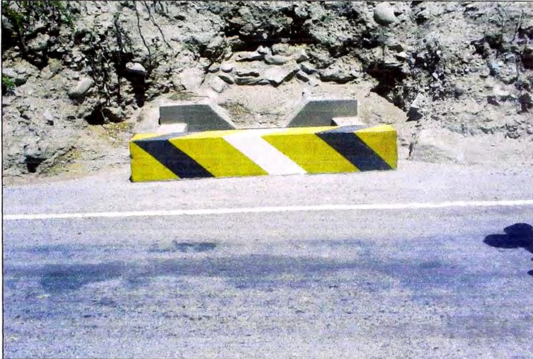
**Fotografía N° 3:** Alcantarilla sin cunetas en sus extremos.
