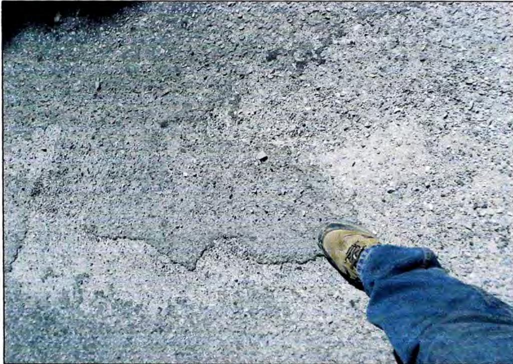
**Fotografía N° 23: Desintegración superficial en la vía.**
