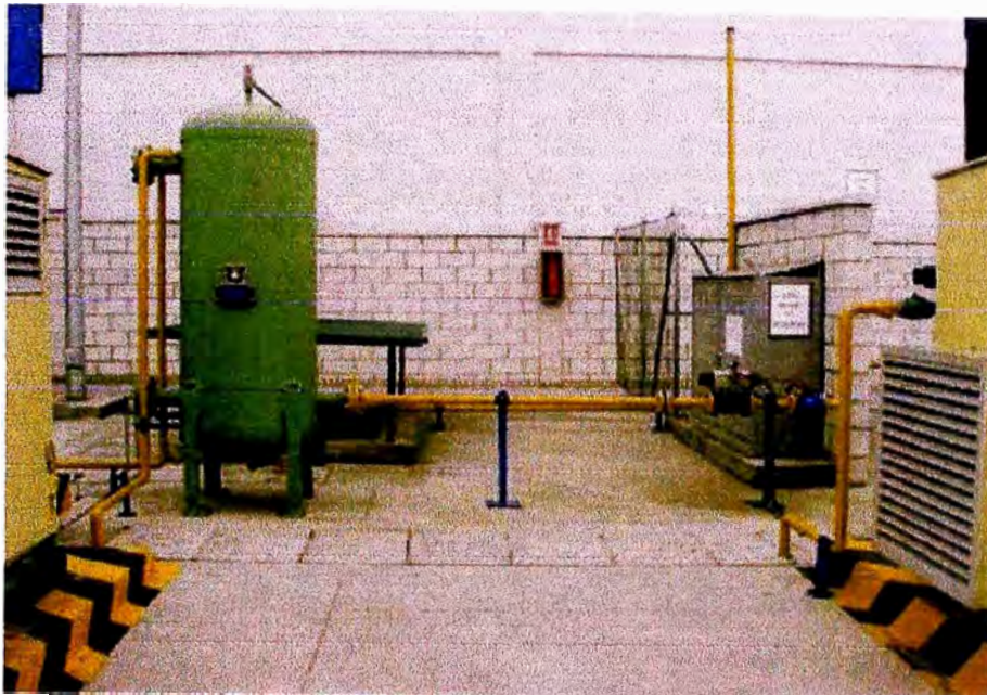
Deposito pulmon a la entrada de compresores e Instalación de los Cubogas
