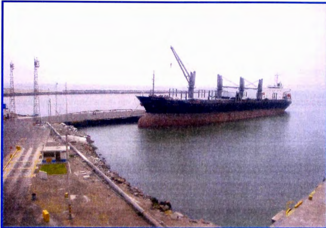
FIGURA N° 2.04 Nave atracada en el Muelle 1 del TPS
