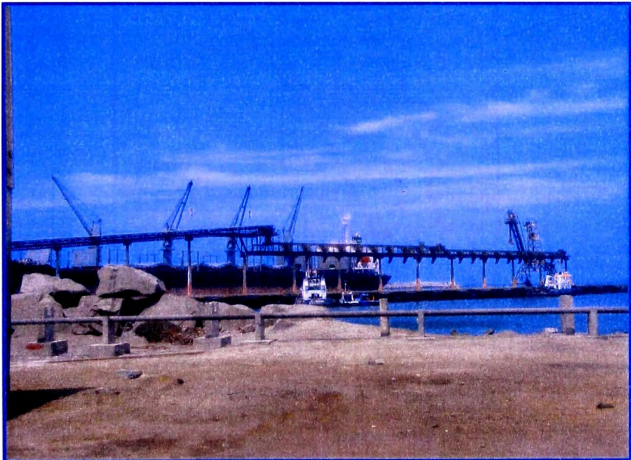
FIGURA N° 1.10 Faja transportadora que opera en el TPS
