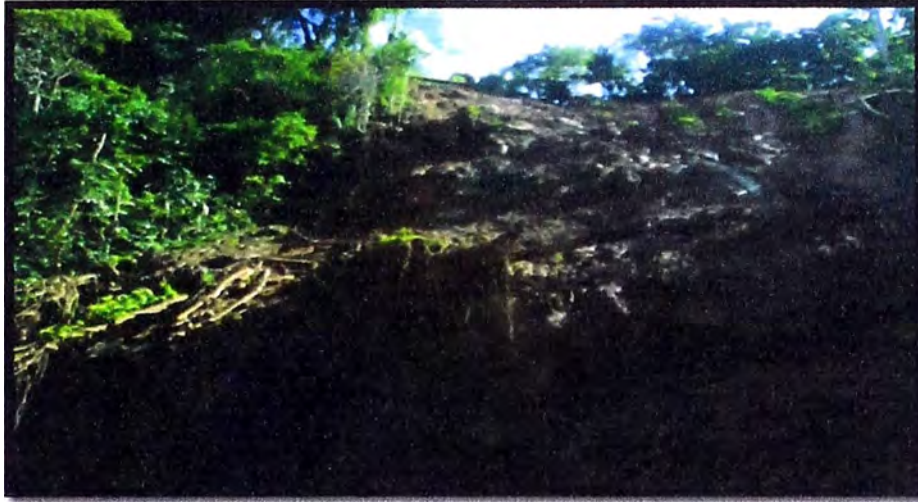
Figura. N°5.02. Deslizamiento de iodo y Arboles
