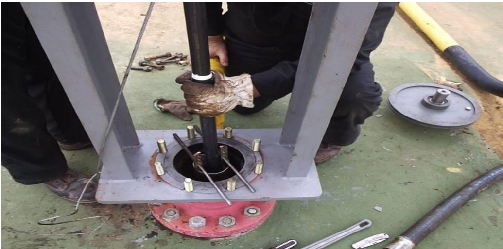
Fig. 6.5 Instalación Tubo de Aspiración de PVC (va dentro del tubo colector)
