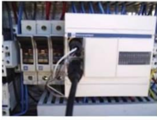
Fig. 24 El sistema, totalmente automático, es comandado por medio de un ordenador programable (PLC).
