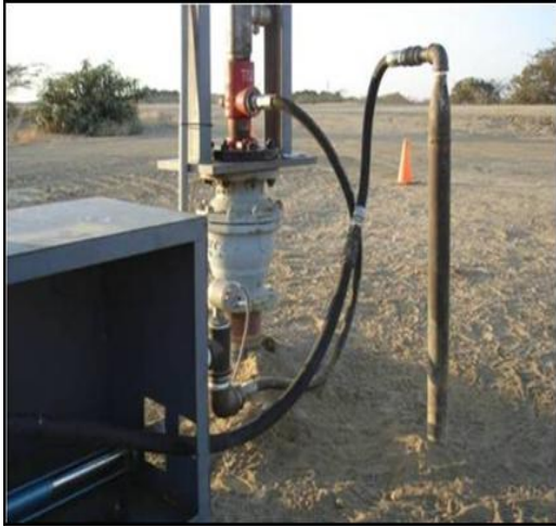
Fig. 2.15 Línea de Succión y Línea de Descarga
