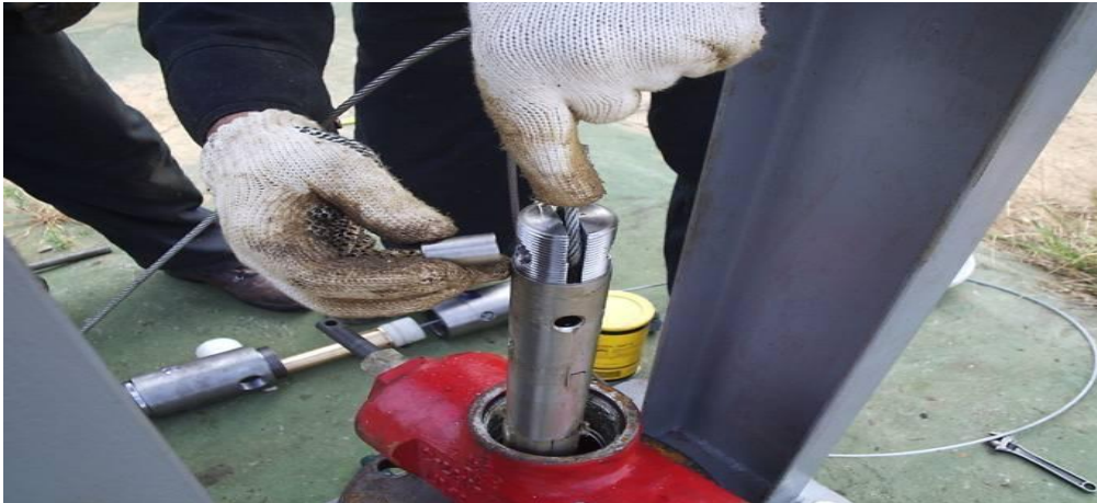
Fig. 6.7 Fijación del Cable de Acero
