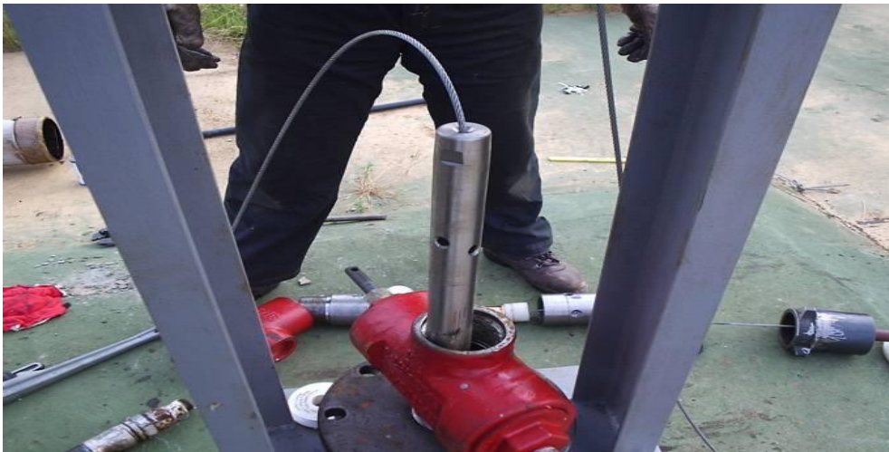
Fig. 6.8 Fijación del Cable de Acero al Tubo de Aspiración
