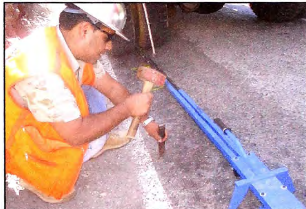
FIGURA N° 3.02. TOMA DE MUESTRA DE CARPETA ASFALTICA
