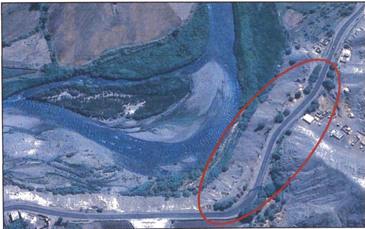
Figura 3.9. Zona crítica por erosión del talud del terraplén km 29+000 al km 29+245
