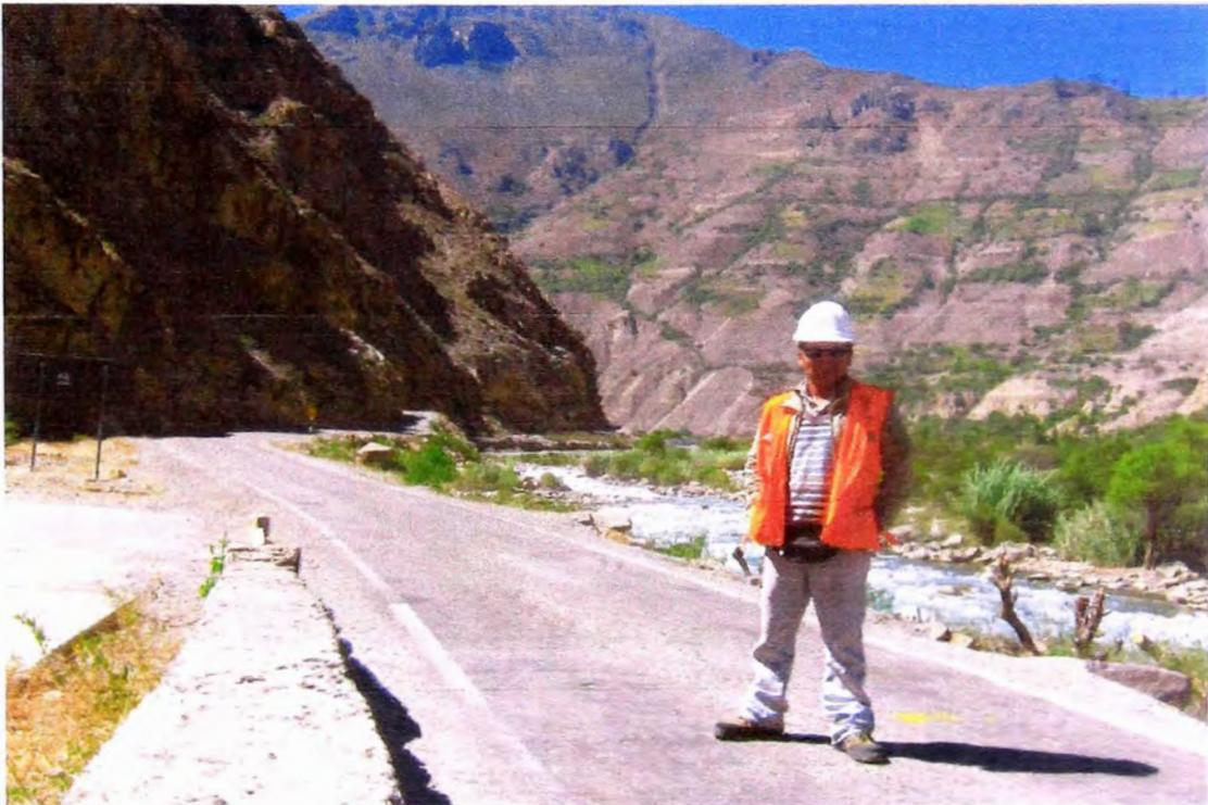
5. Talud en material aluvional compuesto de 40% de bloque (desde 10 cm a 1.5 m de diámetro) al borde la vía que viene desde el Km. 113+000 al Km. 114+045
