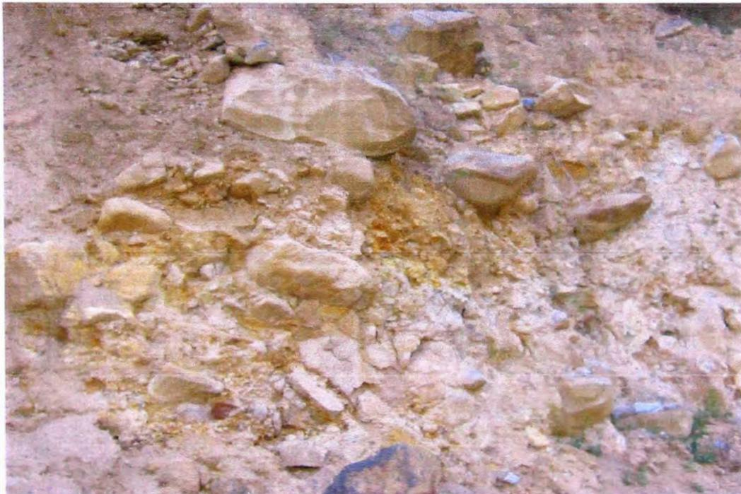
6. Talud en material rocoso fracturado con diaclasas distanciadas desde 0.1, 0.6 y 1.2m., que va desde el Km. 114+045 al Km. 116+000
