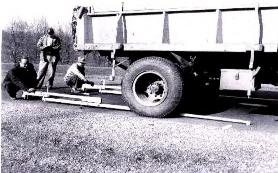
Figura Nº 2.01. Pruebas con Viga Benkelman (1952)
