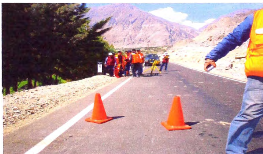
Figura N° 3.1: Conos de seguridad
