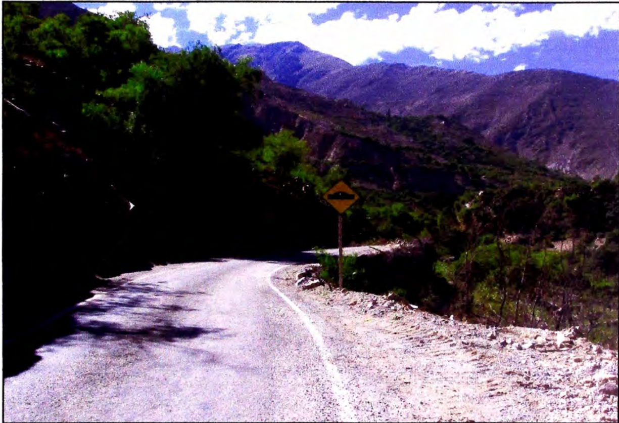
Se observa elementos para la reducción de velocidad de los vehículos (giba), así como el buen estado de la señalización vertical.
