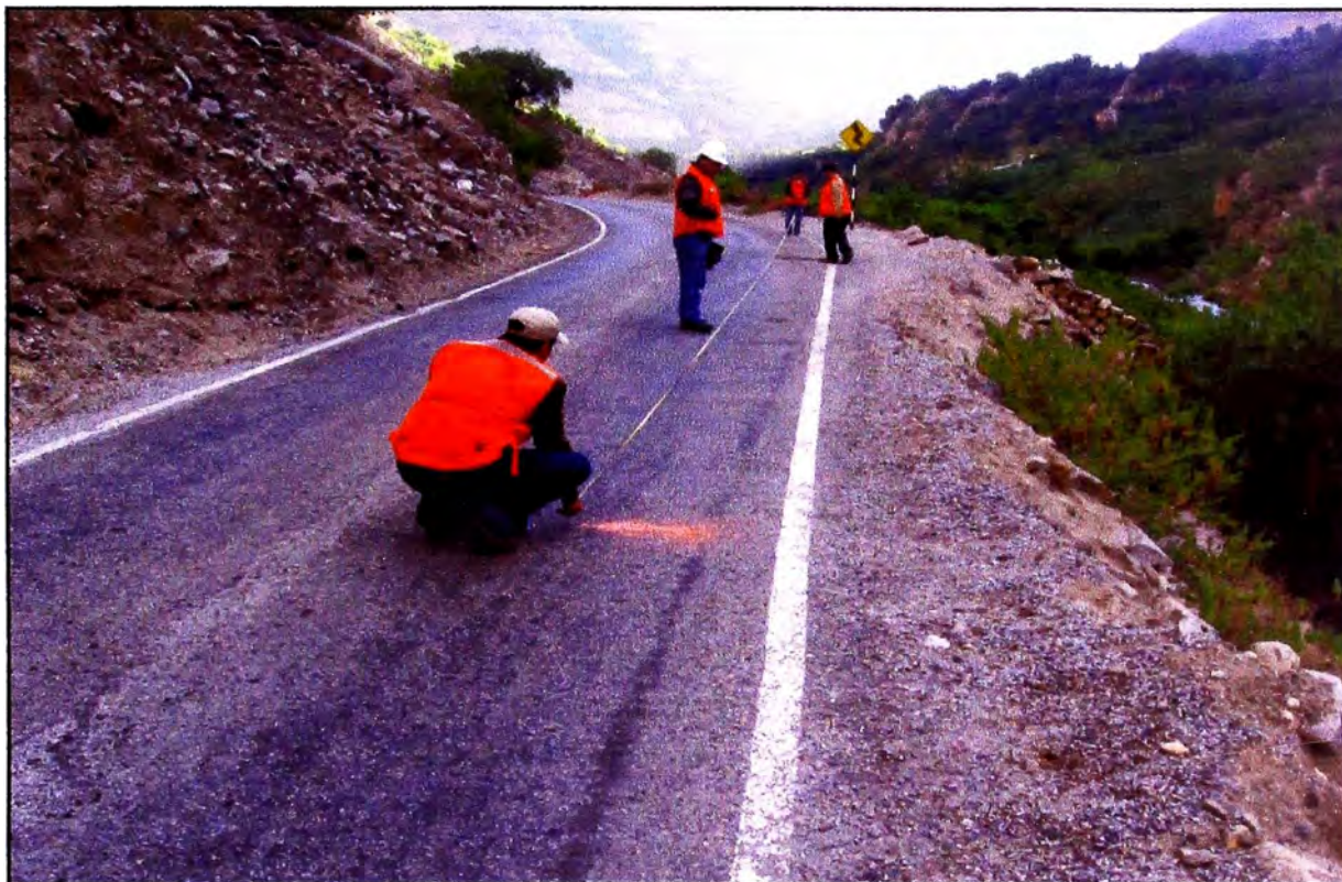
Medición y localización de las progresivas a ensayar.
