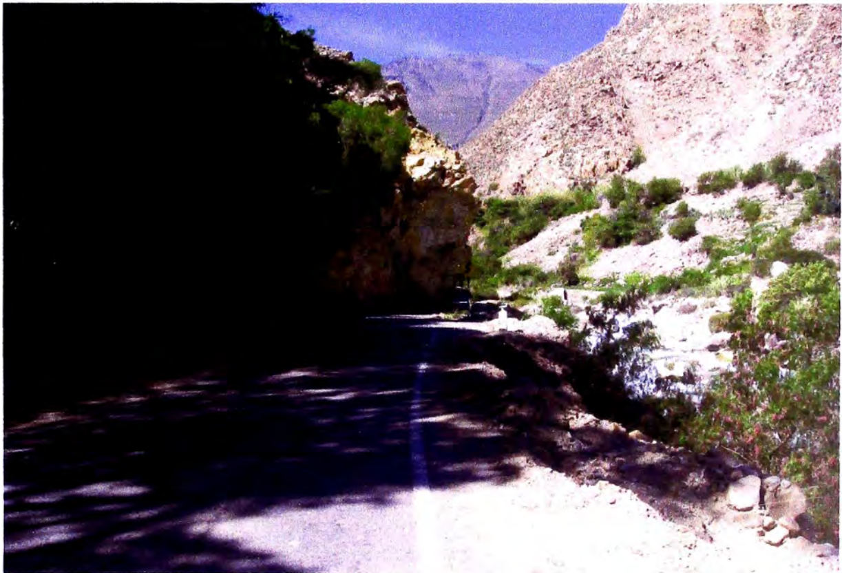
Se aprecia el talud de roca que supera los 90° de pendiente.
