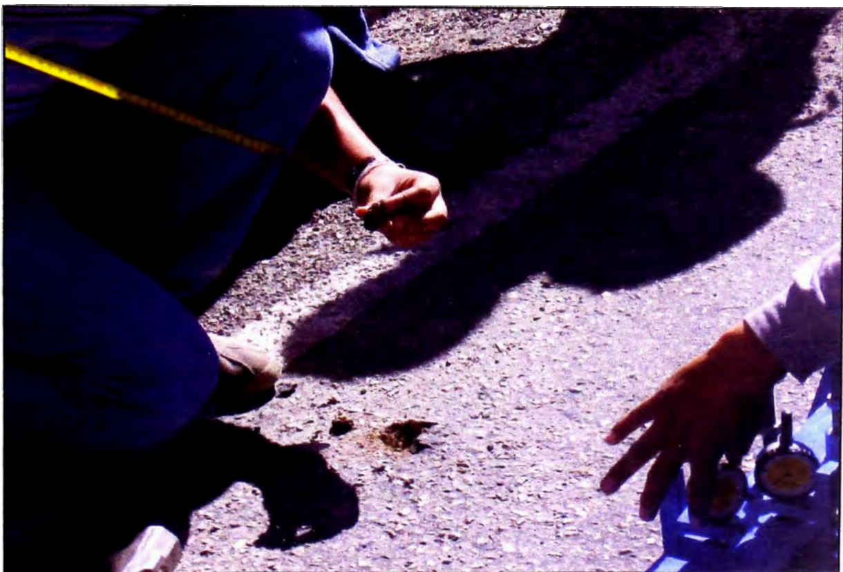
Determinación del espesor de la superficie de rodadura (monocapa asfáltica).
