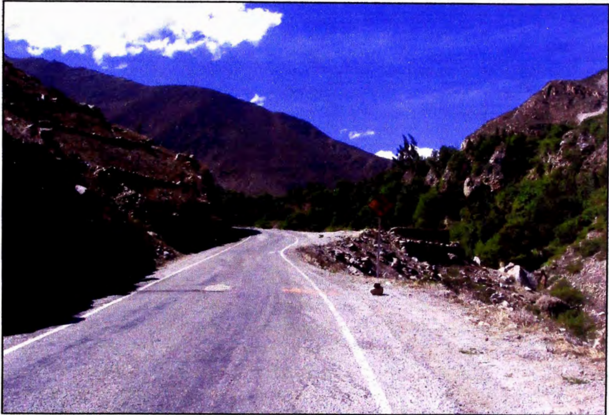
Se observa la repentina reducción del ancho de la calzada.
