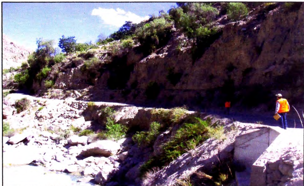
Se aprecia los muros secos construidos con el fin de reducir el desprendimiento de las rocas superficiales de talud hacia la calzada.
