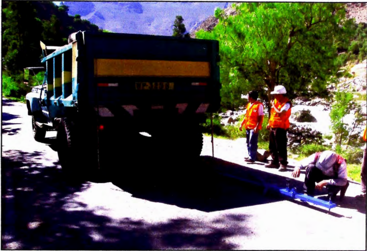
Fijación de pemos de los brazos pivotantes, se estabiliza el cuerpo fijo de la viga sobre sus tres apoyos y se coloca los diales en cero (0).
