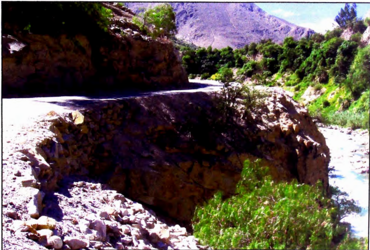
Presencia de enrocados (muros secos).
