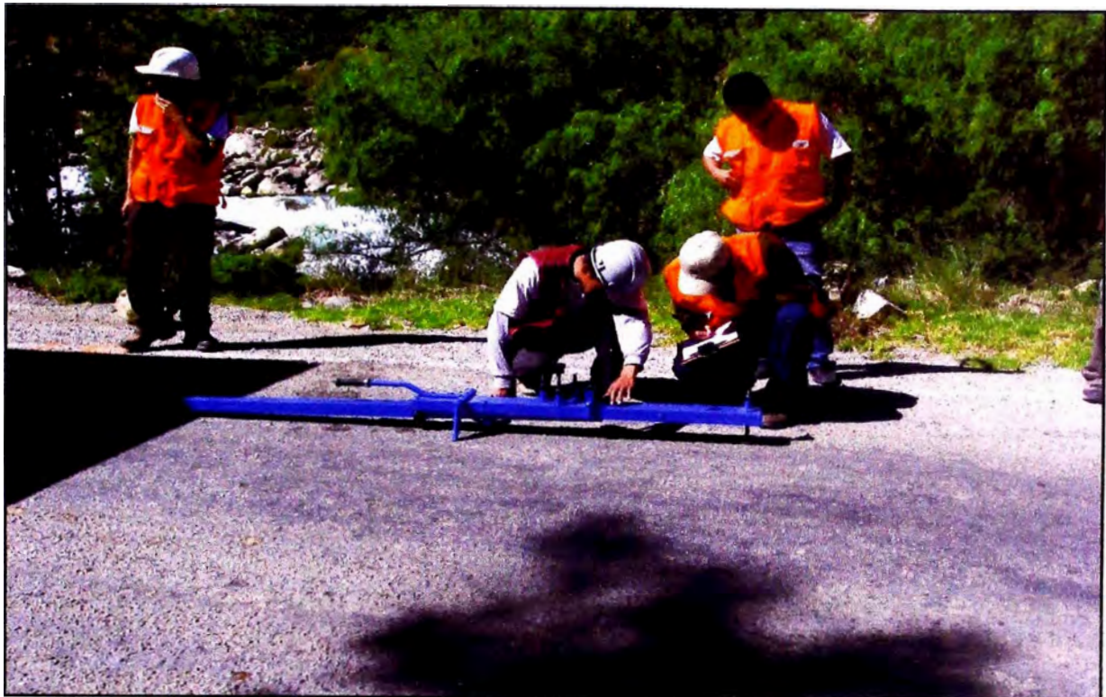
Toma de datos de los diales (máxima recuperación del pavimento).
