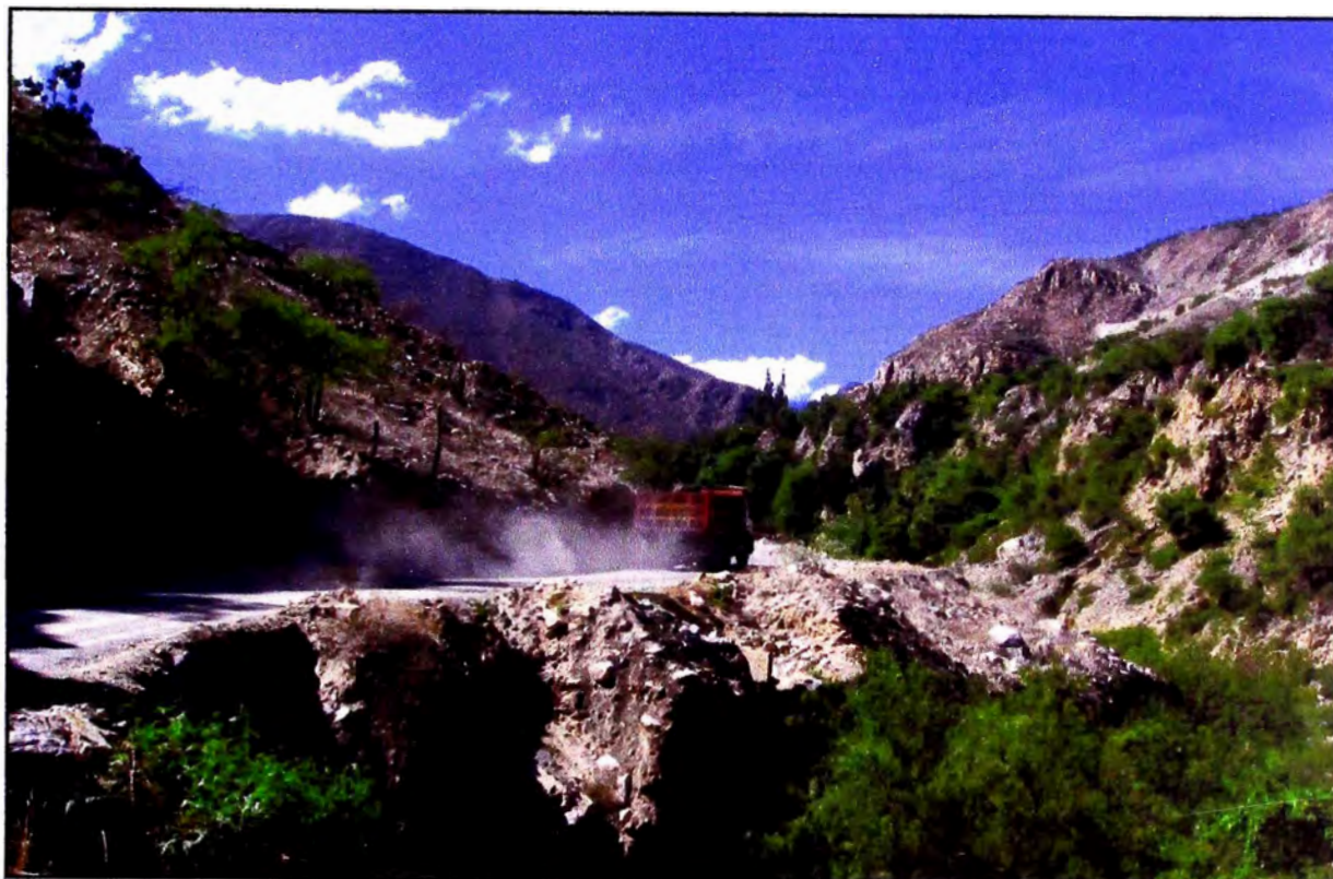
Se observa la presencia de polvo generada por el paso de los vehículos.
