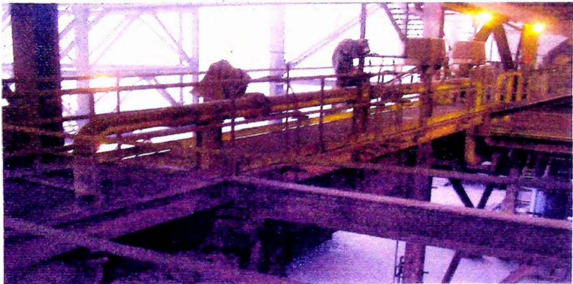
Foto 5.2 Vista llegada de ramal de nueva línea de oxígeno a Reverbero No 3
