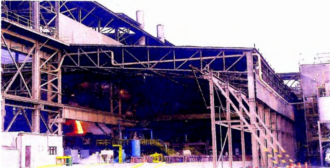
Foto 5.1 Vista nueva línea de oxígeno hacia Hornos Reverberos
