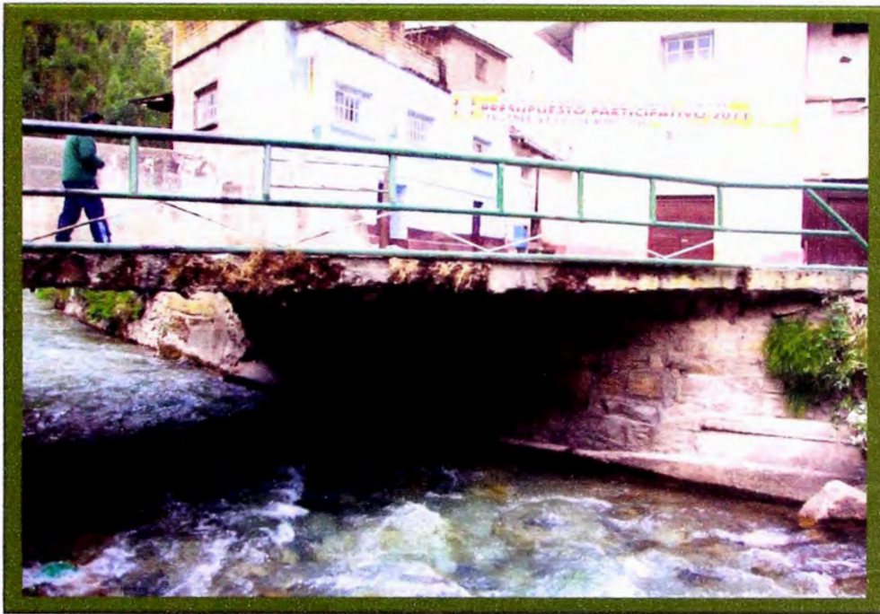
Foto N°05 : estribos en estado regular, no presenta socavación del cauce.
