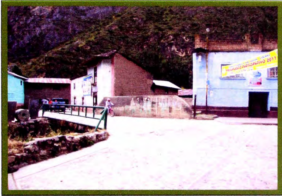
Foto N°03: acceso lateral izquierdo al Pontón (orientado según el curso de aguas)
