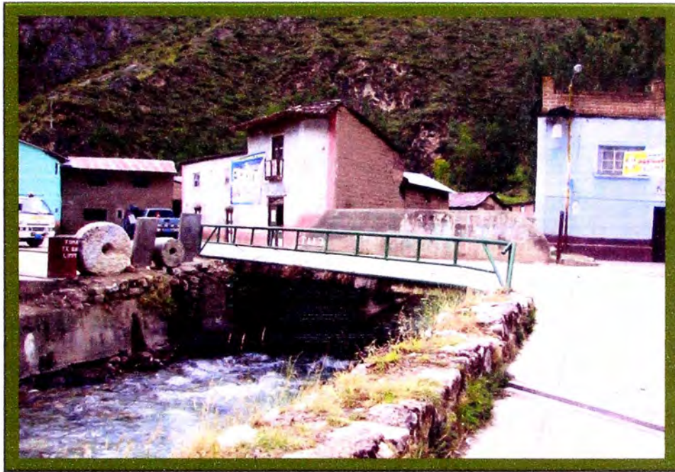
Foto N°01 : vista panorámica del Pontón
