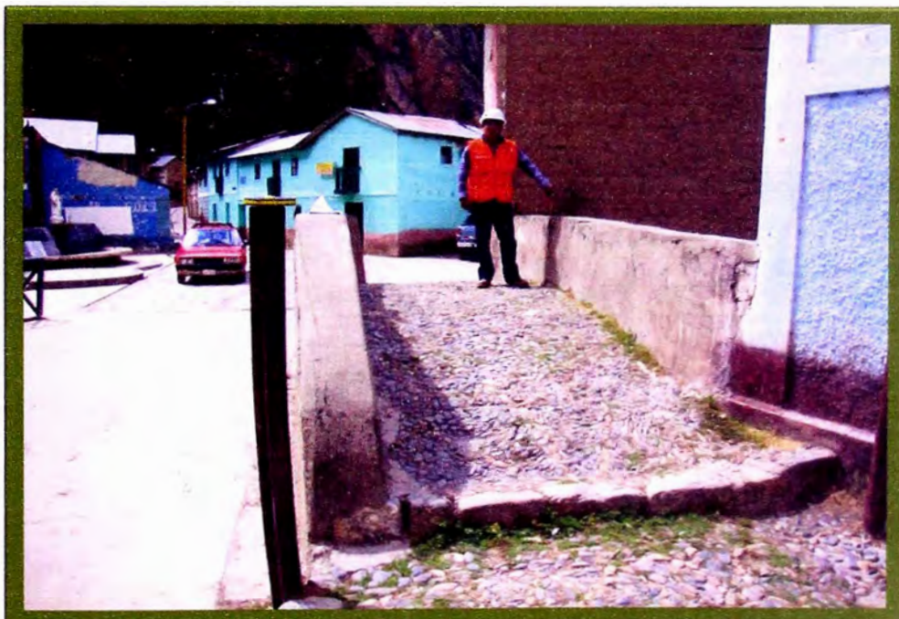
Foto N°06 : cruce peatonal empedrado, en buen estado.
