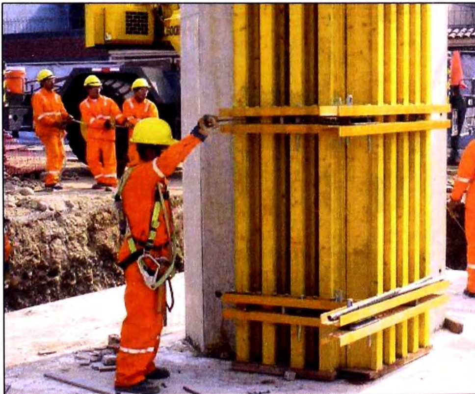
Figura N° 2.03 Vista desencofrado de paneles con sistema Enkoform
