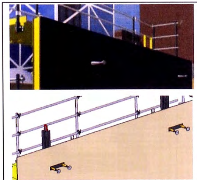
Figura N° 3.09 Colocación de conos en el panel de encofrado
