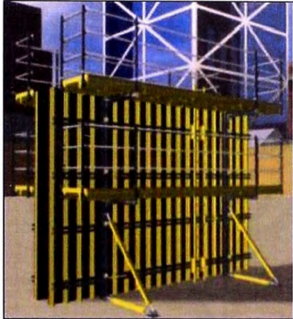
Figura N° 3.10 Paneles de encofrado. Primer vaciado de concreto
