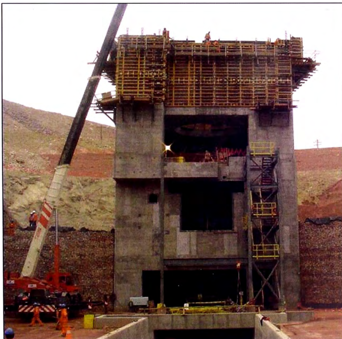
Figura N° 2.01 Vista de encofrado vertical en Chancadora Primaria
