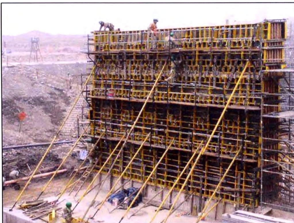
Figura N° 2.02 Encofrado vertical Nevi de la empresa Ulma Encofrados
