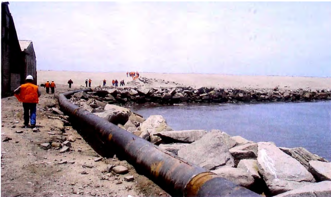
Se observa la tubería que draga hacia la zona de descarga de arena.
