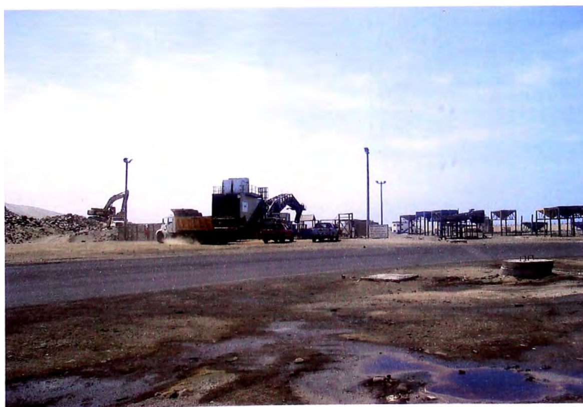
Se observa maquinaria realizando trabajos, originado ruidos y contaminaciones.
