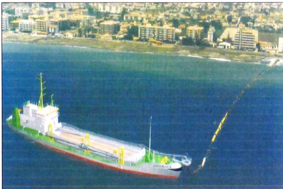
Figura N° 3: Vista panorámica del sistema de acoplamiento de la tubería de descarga a la draga
