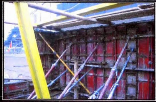
Después de colocado el encofrado procedemos con la colocación de andamios para el momento de vaciado de concreto.
