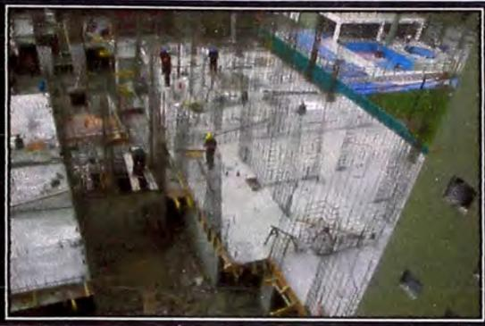
Simultáneamente a la colocación de dowels se realiza la colocación de armadura.
