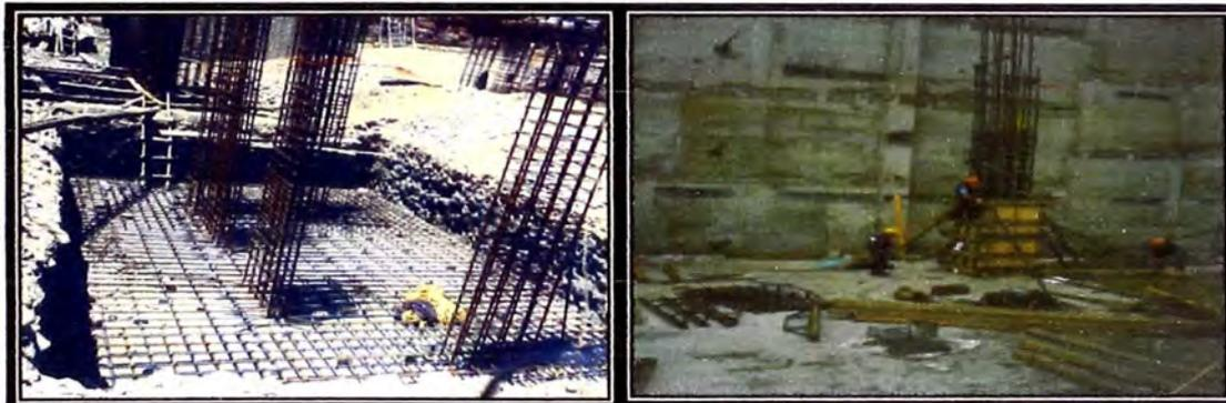
Luego del armado de las columnas y vaciado de sus cimientos se alinean y se aploman.
