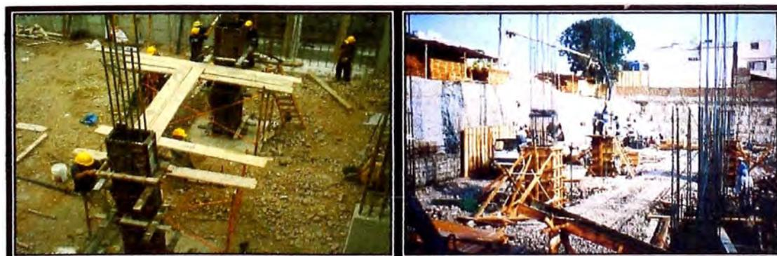
Se observa colocación de andamio para vaciado de columnas evitar de asegurar el andamio al encofrado de columnas ya que por el movimiento de pueden desplomar las columnas.
