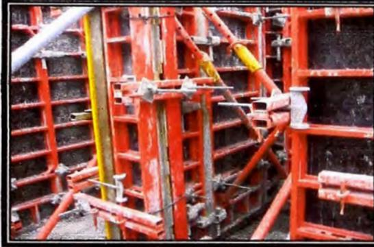
Luego de colocado el encofrado se comienza al apuntalado asegurado y alineamiento de estas, colocándole rigidizadores y llevándolo a su posición final.
