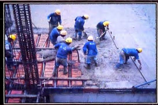
Luego de terminar de colocar las tuberías de instalaciones sanitarias, tenemos que revisar los recubrimientos, la colocación del acero y encofrado para poder luego de esto iniciar con el vaciado de concreto.
