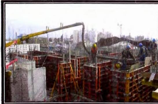
Tener ciertas consideraciones antes de programar el vaciado de concreto como la temperatura del ambiente que se debe de encontrar entre 5 y 28°C, que no haya lluvia ni granizada y que la temperatura de los encofrados no deben de exceder los 50°C.
