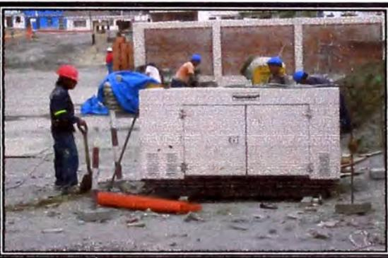
**1.03 Energía eléctrica para la construcción:** Para la obra contamos con grupo electrógeno de 100kw, para abastecer de energía para los trabajos a realizarse como para las oficinas.
