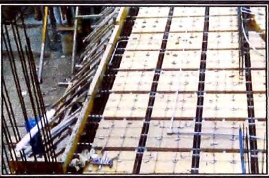
Simultáneamente se coloca el acero de las vigas chatas o peraltadas para que podamos proceder con la colocación de las instalaciones eléctricas y sanitarias.
