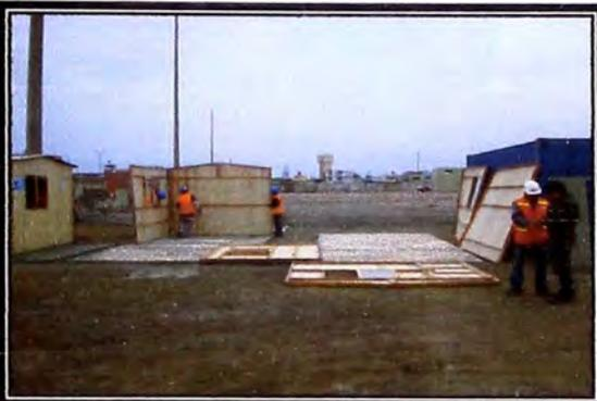
**1.01 Construcciones Provisionales:** Continuando con el proceso de construcción de las instalaciones provisionales observamos el levantamiento de los ambientes de la obra.
