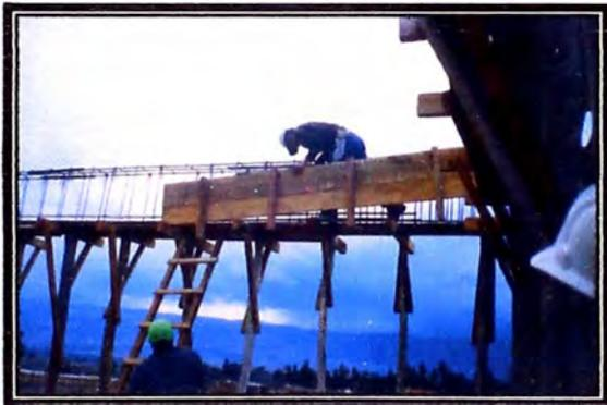
Luego de tener la armadura lista, continuamos con el encofrado colocando los costados y luego procedemos con la verificación de recubrimientos alineamiento y verticalidad respectivos.
