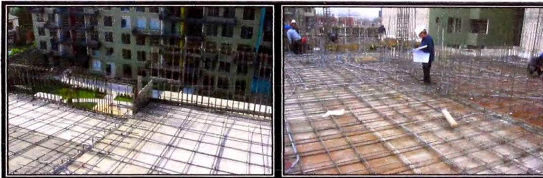
No olvidar los refuerzos donde la losa cambia de espesor
