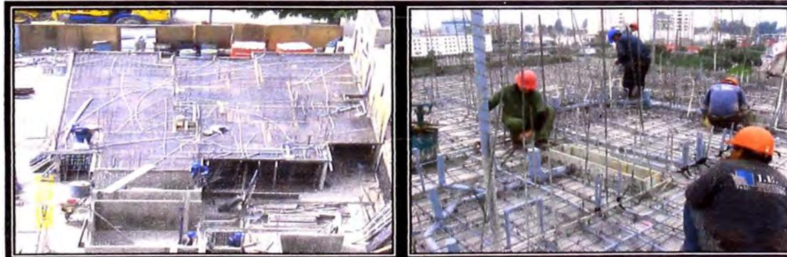
No olvidar de revisar tanto el acero como las tuberías de las instalaciones que estén conformes según indique el plano.
