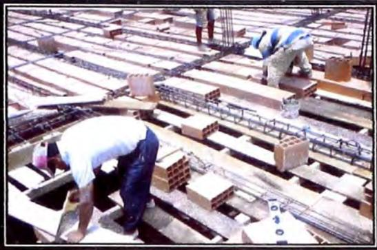
Se inicia con el apuntalamiento y colocación de viguetas debajo de la losa para poder colocar los tablonces
