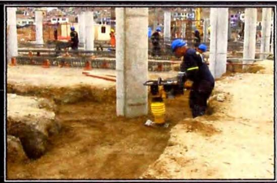
**3.06 Nivelación interior y apisonado:** En las zonas pequeñas donde no puede ingresar equipo pesado el refine y nivelación se realiza manualmente.
