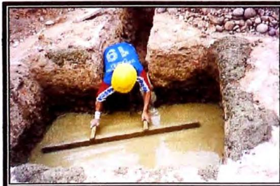
3.06 Nivelación interior y apisonado: En las zonas pequeñas donde no puede ingresar equipo pesado el refíne y nivelación se realiza manualmente.
