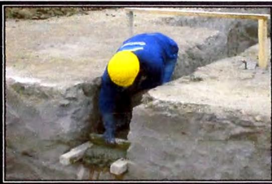
**4.05 Solados:** Se observa vaciado de solado, tener en cuenta espesor según especificaciones.
