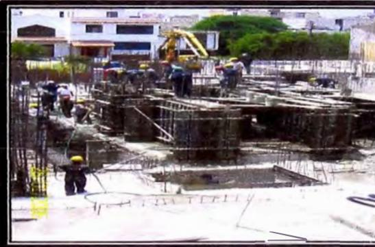
Tener ciertas consideraciones para el vibrado como, el tiempo de vibrado es de 3 a 15 segundos la separación entre zona de vibrado es de 0.30 a 0.45m y evitar que el vibrador choque con el encofrado.
