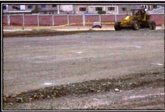
**3.01 Excavaciones:** Previo a la excavación se realizo el trazo respectivo, y con ayuda del topógrafo realizamos este trabajo teniendo en cuenta el fondo de cimentación.
