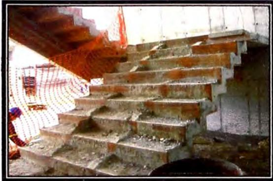
**4.03 Gradadas:** Se observa el encofrado para escaleras y gradadas.
