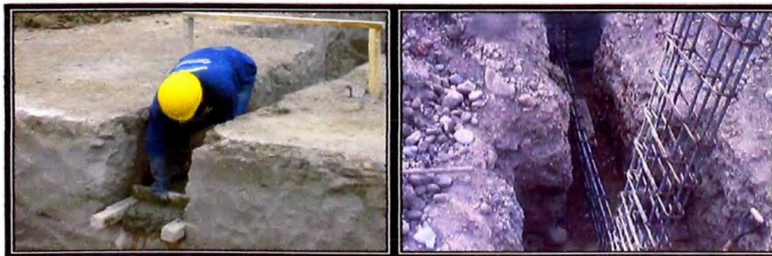
Luego de tener listo los niveles de la viga de cimentación podemos iniciar con la colocación del solado según las especificaciones técnicas del proyecto y los niveles que indican los planos
