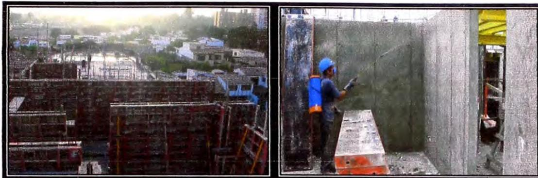
Para este proceso de desencofrado comenzamos con la remoción de andamios y puntales que se utilizaron para asegurar la verticalidad y alineamiento del encofrado
