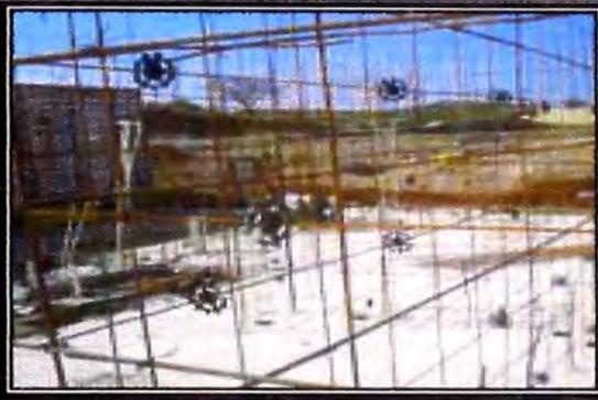
Simultáneamente a la colocación de las armaduras se procede a colocar las instalaciones eléctricas y sanitarias
