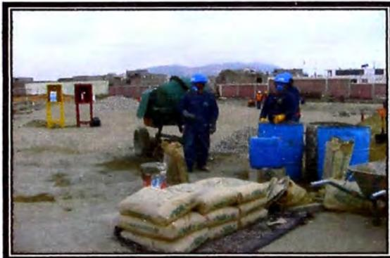
**4.05 Solados:** Es necesario tener una cuadrilla de la preparación de solados y vaciado del mismo teniendo en consideración la relación cemento:hormigón.
