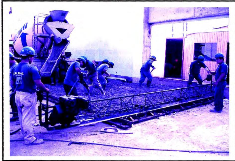
Continuación del extendido del concreto una vez colocada la malla de dowells
