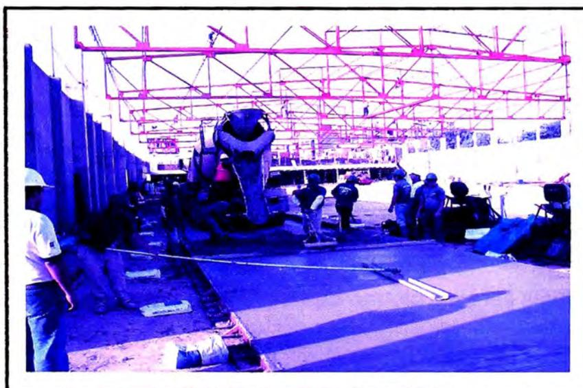
Nivelación del concreto con el avión tipo canal
