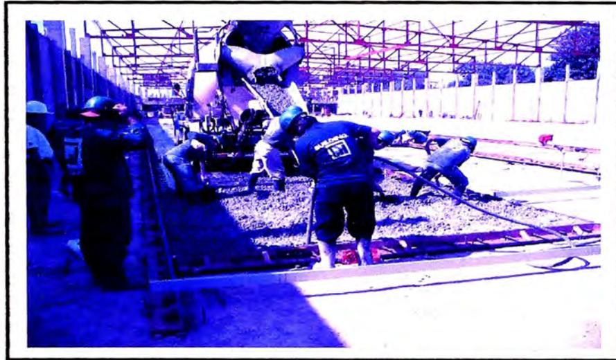
Descarga del concreto después de colocado la malla de dowells
