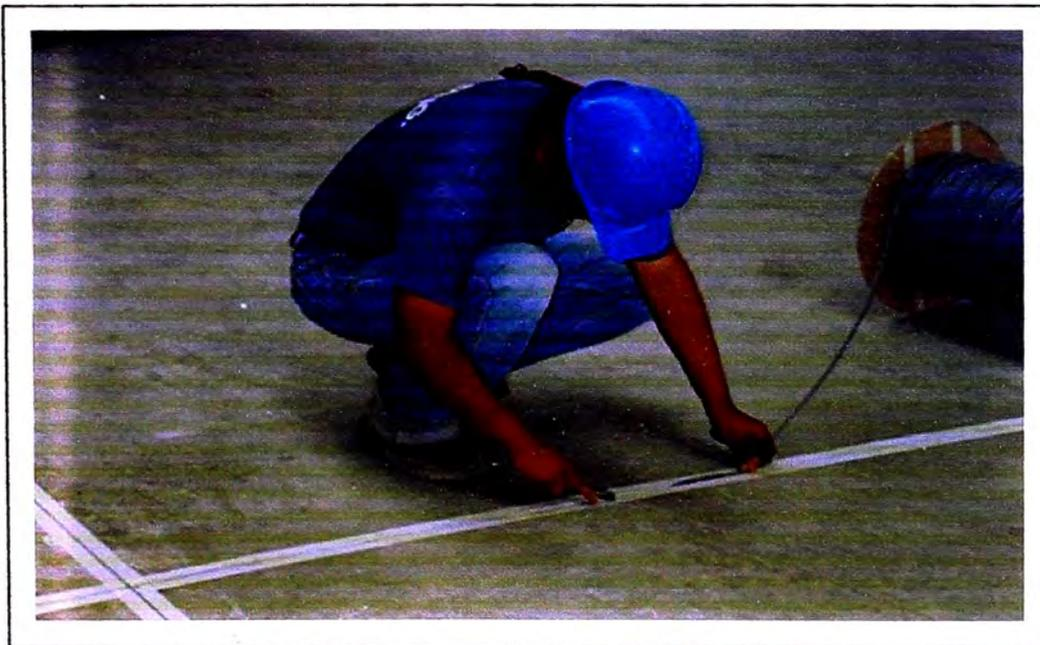
Protección de juntas con cinta masking type para sellado de juntas
