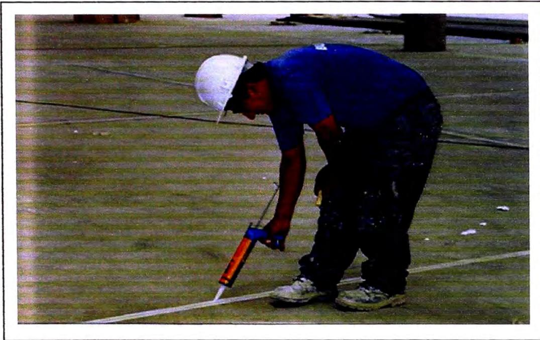
Sellado de juntas de contracción y construcción, con Sonolastic NP1
