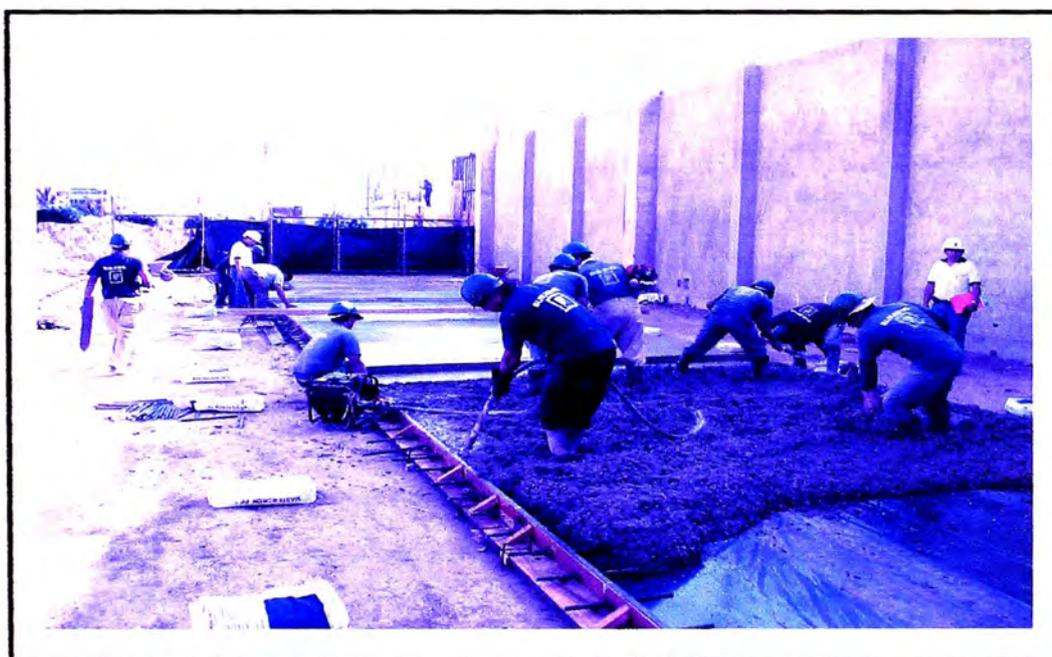
Extendido del concreto de manera uniforme con palas de borde cuadrado
