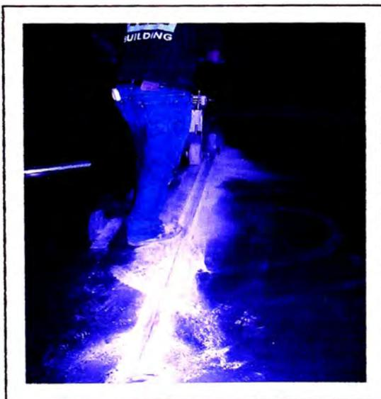
Corte de juntas con la cortadora convencional h=2" profundidad
