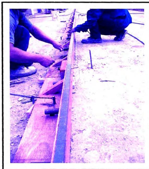
Fijación del encofrado con fierro de
