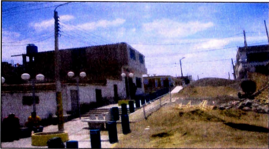
Foto N° 2.19 : Vista del sistema eléctrico en el distrito de Rázuri
