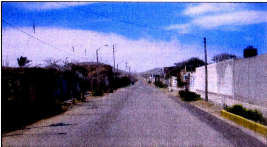
Foto N° 2.20 : Vista de las viviendas y alumbrado eléctrico del distrito de Rázuri
