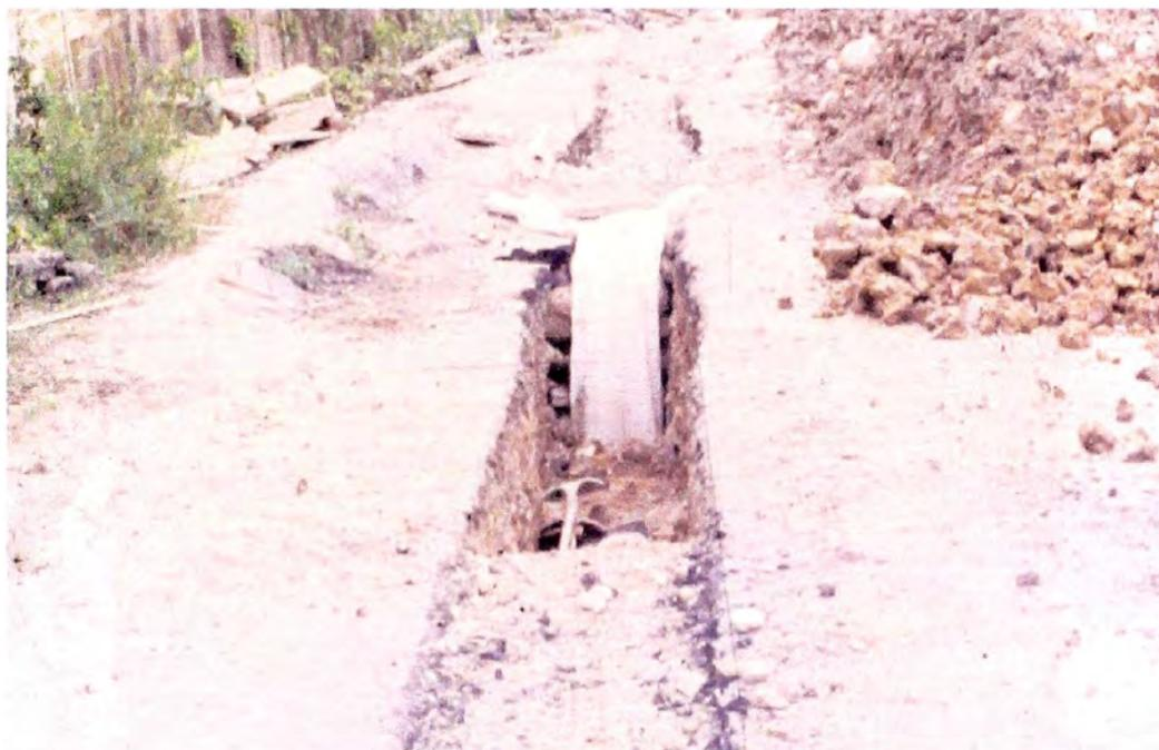
**Foto N1 – Zanja con un elemento permeable filtrante en su interior**
