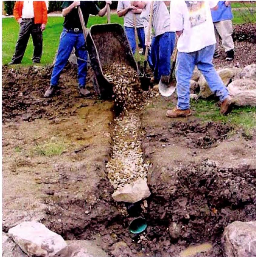
**Foto N3 – Relleno de zanja con tubería, con material filtrante.**
