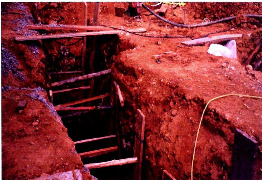
**Foto N2 – Profundidades de zanja, generalmente de 1 a 2mts, excepcionalmente hasta 6mts.**
