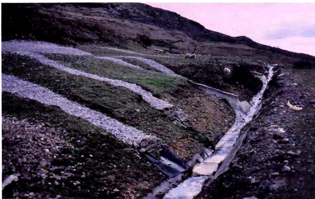
**Foto N4 – Proyecto de subdrenaje usando geotextil.**
