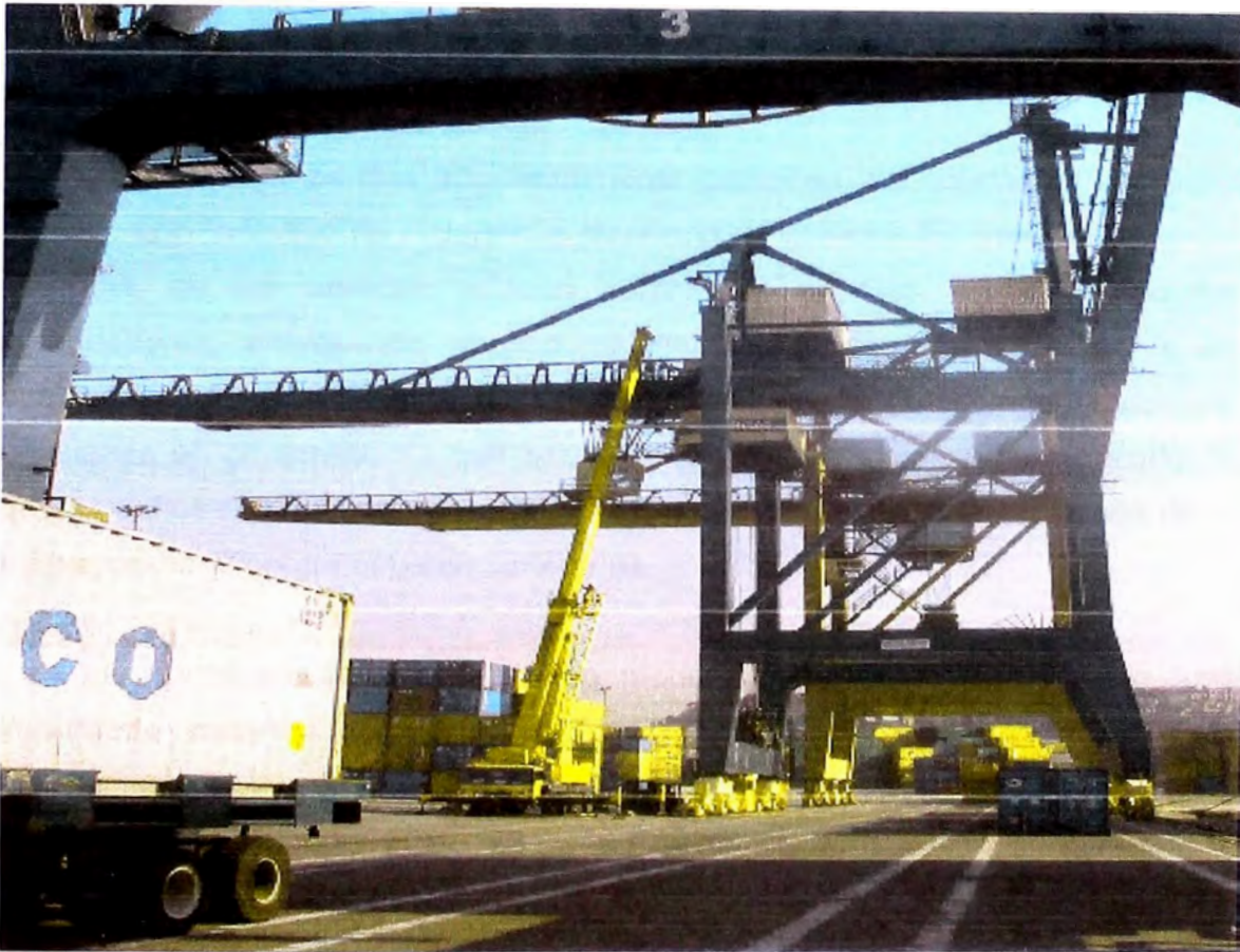
Fotografía N° 3.21 Grúas de tipo pórtico
