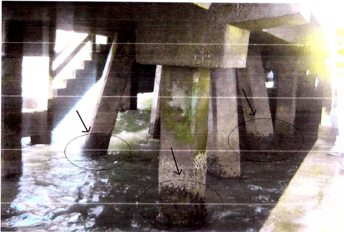
Fotografía N° 1.04 Pilotes de sección rectangular, frente a la agresividad del las olas del mar
