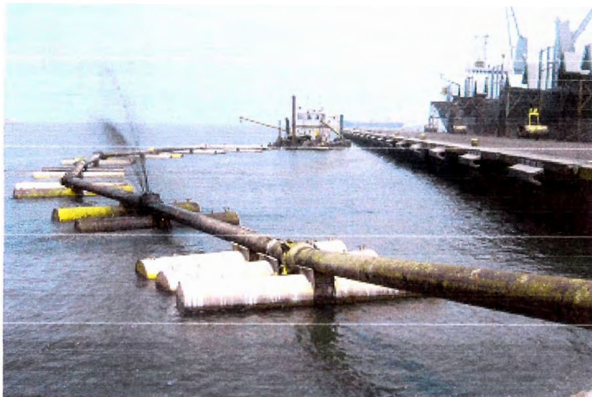
Fotografía N° 1.02 Dragado en el terminal Portuario de Salaverry
