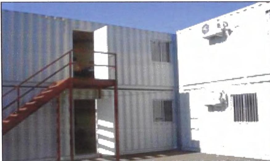
Fig. N° 2.5. Construcción modular de campamentos en base a contenedores acondicionados.
