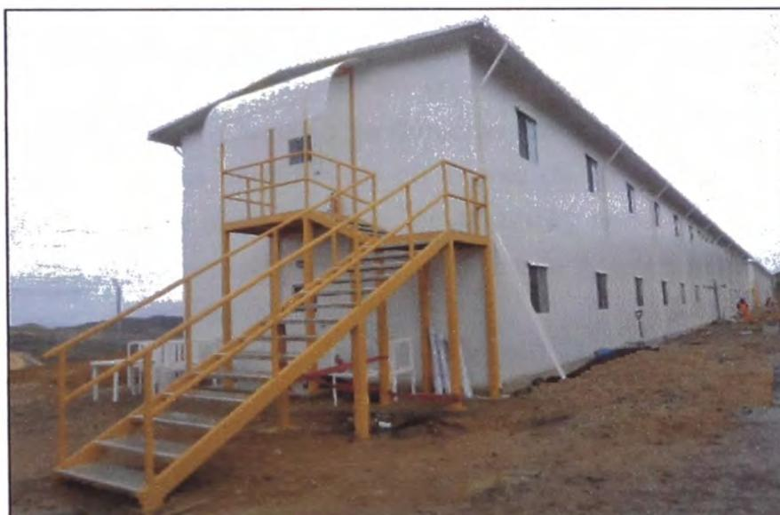
Fig. Nº 2.6. Modulo fijo de uso para alojamiento a base de paneles termoacústicos.
