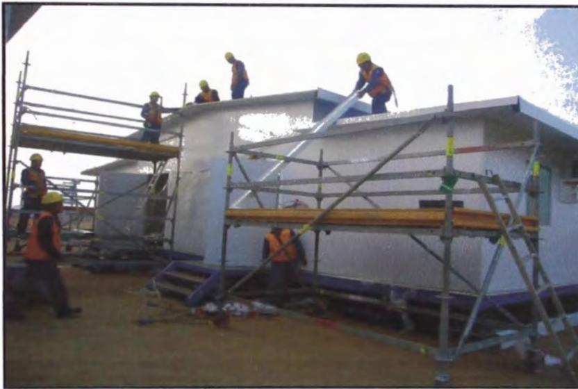
Fig. N° 4.27 se muestra el correcto uso de andamios para la realización de trabajos en altura
