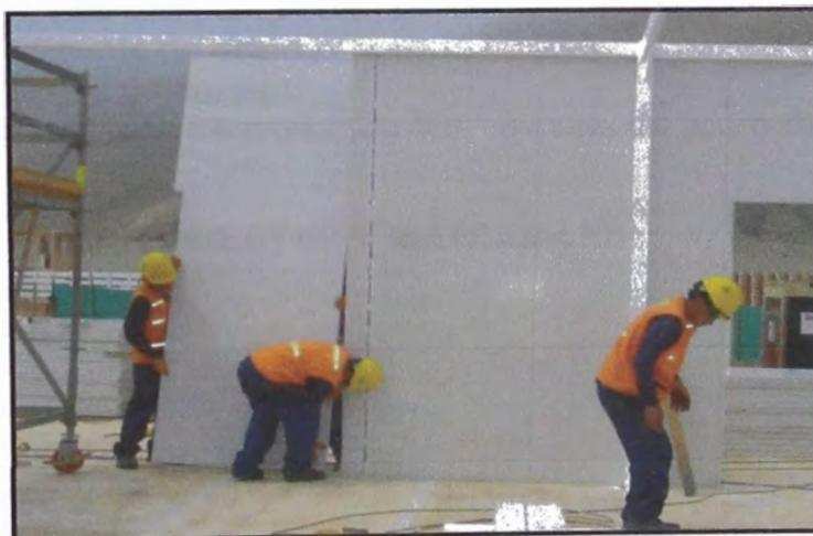
Fig. N° 4.25 trabajos de colocación de panel TAP 1180 para muros.
