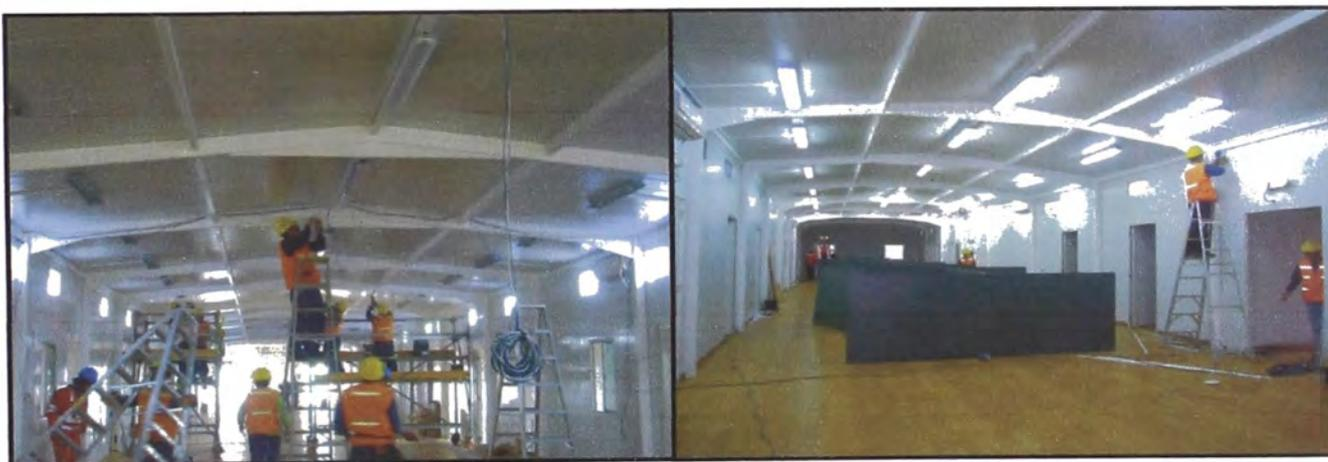
Fig. N° 4.28 trabajos de colocación de luminarias.
