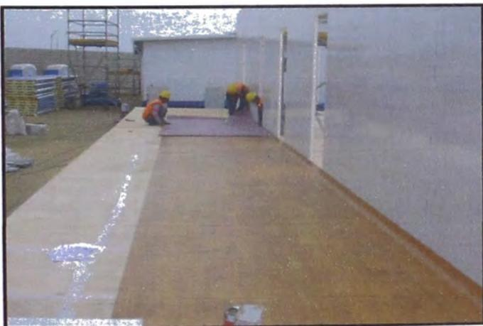
Fig. N° 4.23 trabajos de colocación de piso vinílico.
