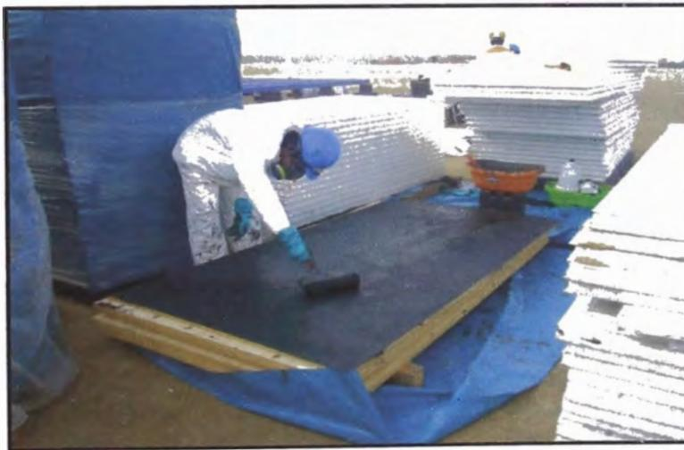
Fig. N° 4.19 aplicación de impermeabilizante a superficie de triplex fenólico.
