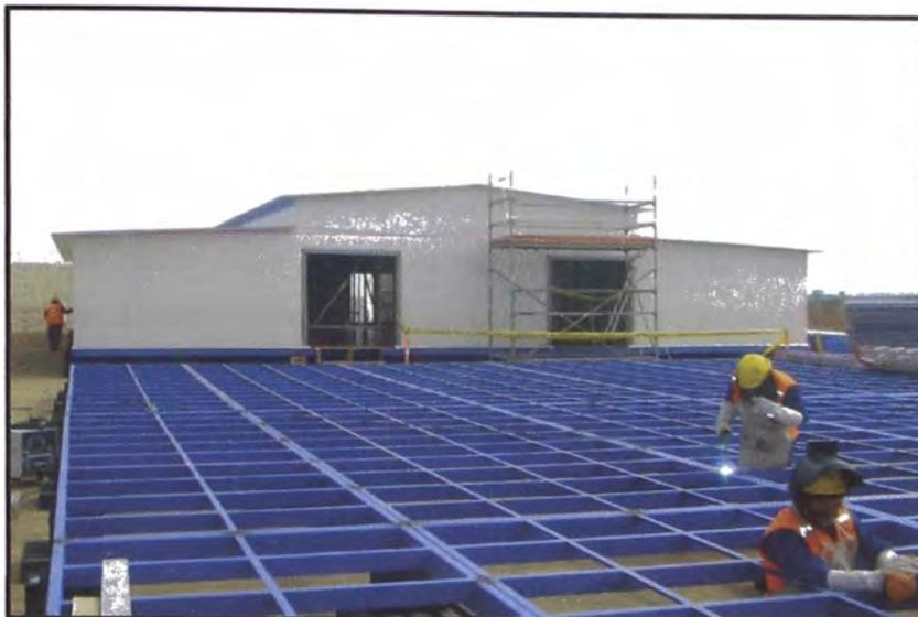
Fig. Nº 4.18 posicionamiento de plataformas metálicas según plano de ubicación.
