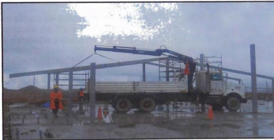
Fig. N° 4.21 montaje de estructuras metálicas con camión grúa.
