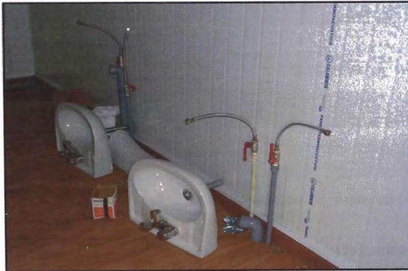
Fig. N° 4.29 trabajos de redes sanitarias; salida de agua fría y agua caliente.
