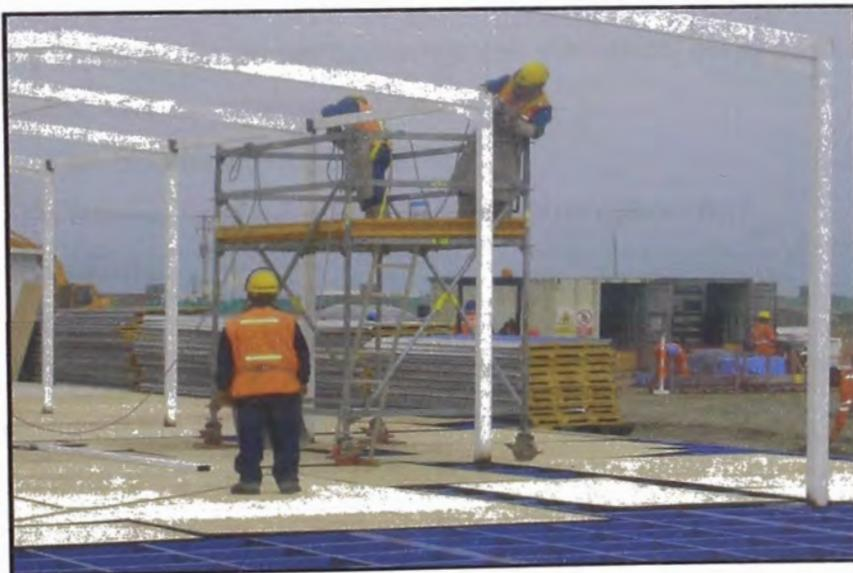
Fig. N° 4.22 trabajos de soldadura en pórticos metálicos.
