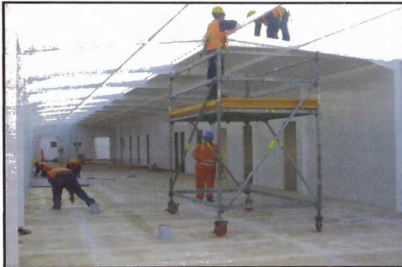
Fig. N° 4.26 trabajos de colocación de panel TAT 1060 para techos.
