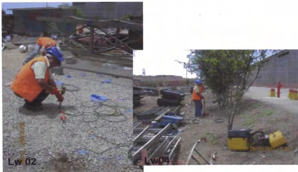
Foto N°18: Tendido de líneas sísmicas Lw 02 y Lw 04
