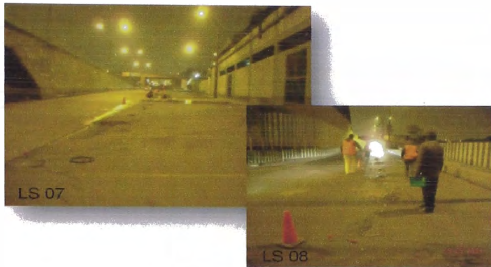
Foto N°15: Instalación de líneas sísmicas Ls 07 y Ls 08
