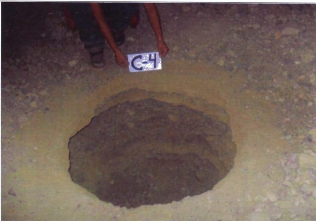
Calicata C-4: Esta calicata de 1.50 m de profundidad se realizo en la zona del centro poblado, en la intersección de la Avenida Jorge Chavez y Avenida Domingo Ramos.
