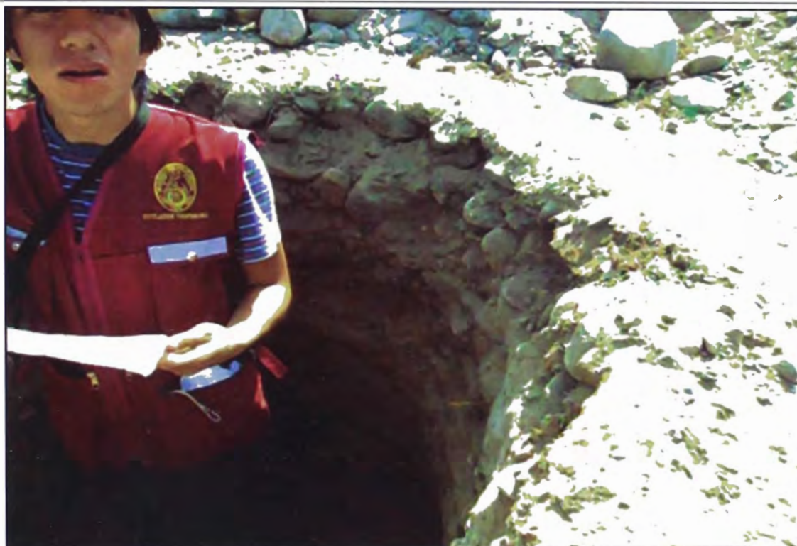
Calicata C-2: Esta calicata de 1.50 m de profundidad se realizo en la zona del centro poblado, en la intersección de la Avenida Lima y el borde del Canal.
