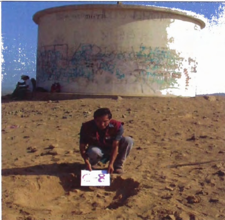
Calicata C-8: Esta calicata de 0.20 m de profundidad se realizo en la parte alta del cerro cueto, en la zona donde se proyectara el nuevo reservorio.
