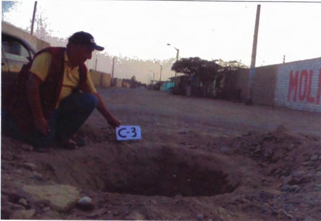
Calicata C-3: Esta calicata de 1.50 m de profundidad se realizo en la zona del centro poblado, en la intersección de la Avenida Italia y el Jr. Callao
