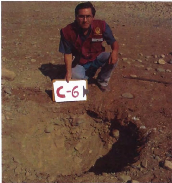
Calicata C-6: Esta calicata de 0.60m de profundidad se realizo en la zona donde se proyectara la tubería de ingreso a la planta de tratamiento.
