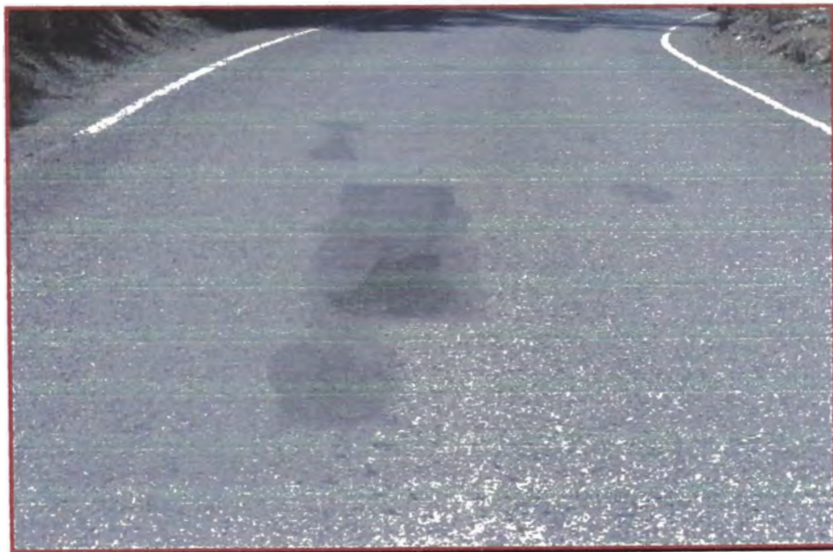
Fotografía No.4.02 Tramo No. 1 PRG 139+000 AL 140+000
