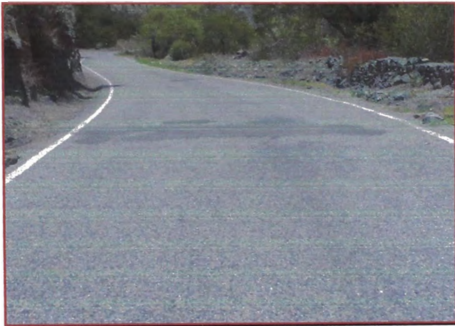
Fotografía No. 4.04 Tramo No. 1 PRG 140+000 AL 141+000
