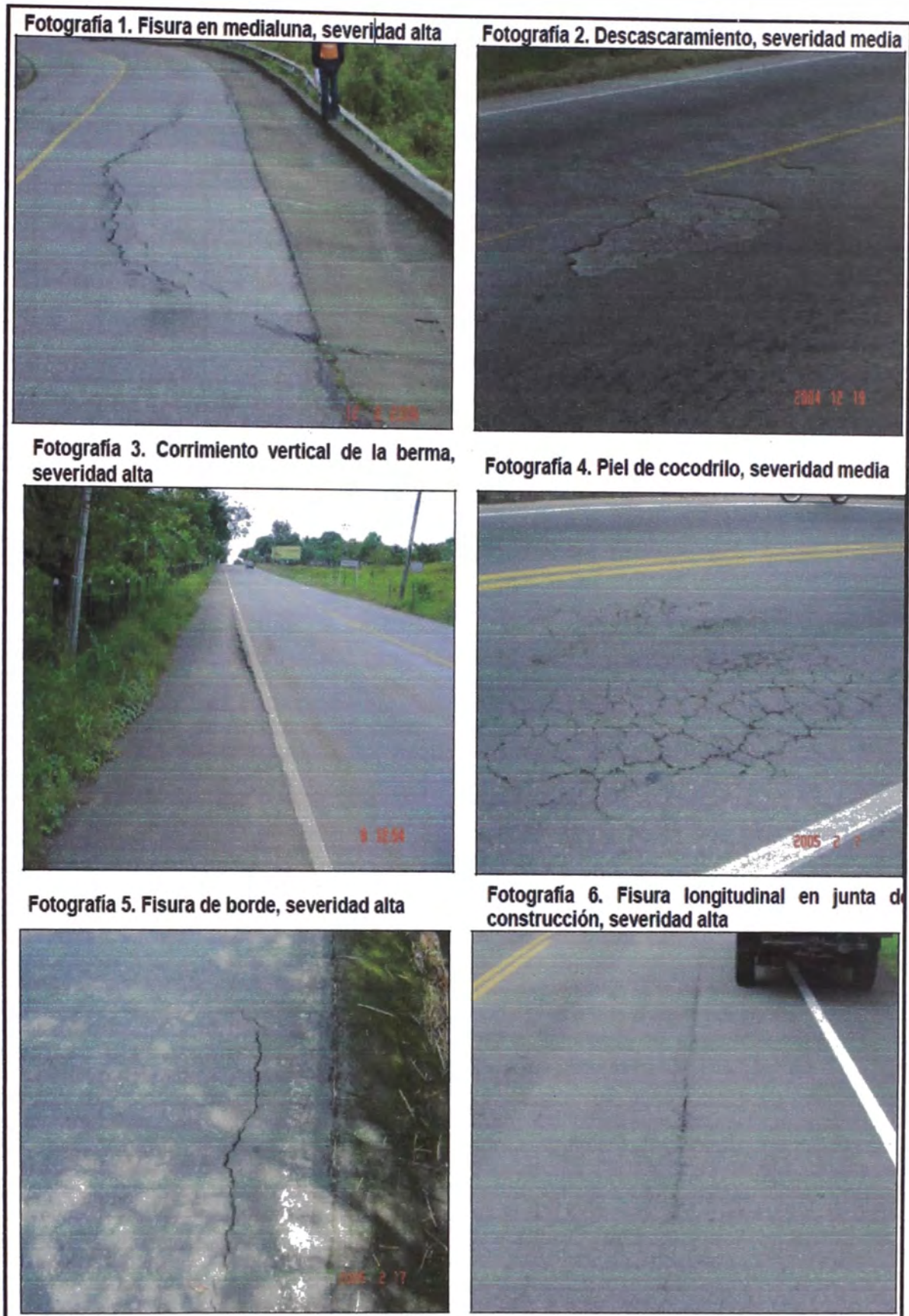
Figura N°3.10 : Fotografías de Ejemplo de Llenado Formato para la evaluación (Fuente : Manual de Inspeccion visual para pavimentos Felibles, Min. Transporte, 2006 - Colombia)
