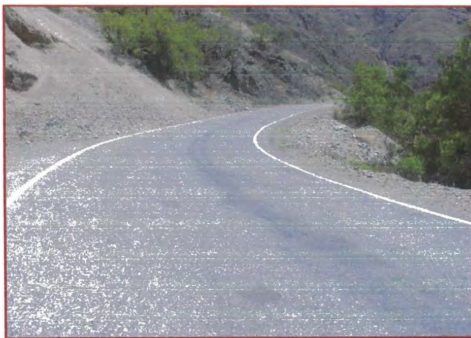
Fotografía No. 4.06 Tramo No. 1 PRG 141+000 AL 142+000
