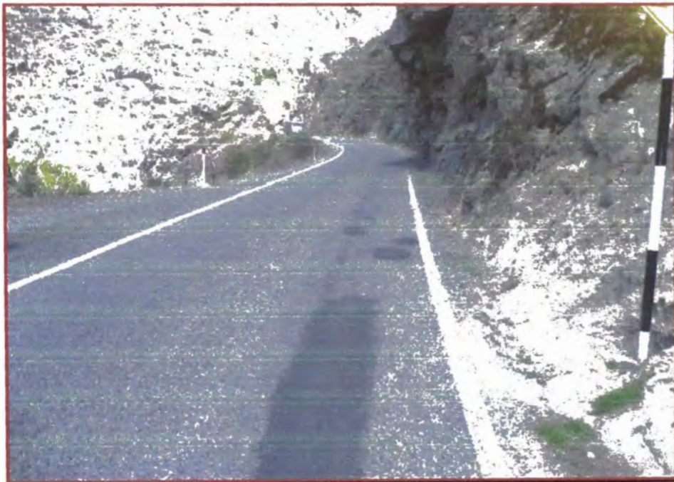
Fotografía No. 4.08 Tramo No. 1 PRG 143+000 AL 144+000
