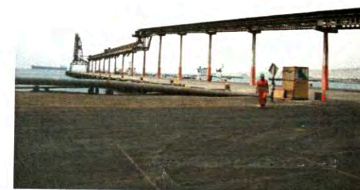
Foto N° 08: Faja Transportadora de Azúcar Hacia el Muelle
