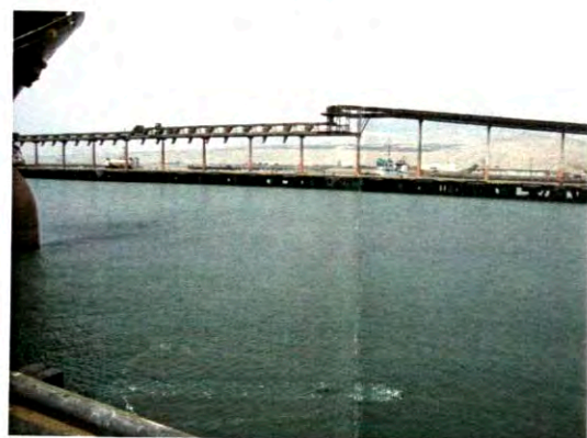
Foto N° 06: Faja Transportadora de Azúcar Hacia el Muelle
