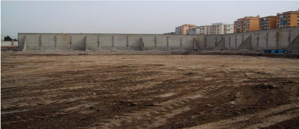
Fig.3.14 Reposición del Suelo Tratado
