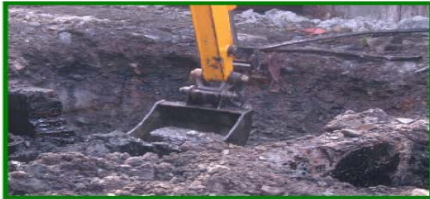
Fig. 3.7 Excavación para la Instalación de las Biopilas
