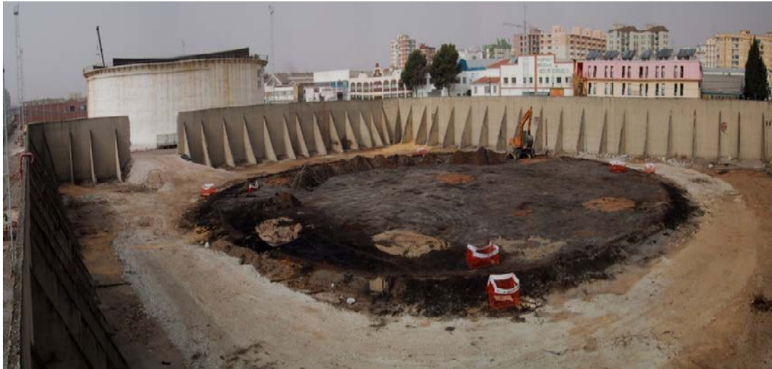
Fig 3.2: Almacenamiento en Pozas en Superficies de Hidrocarburos
