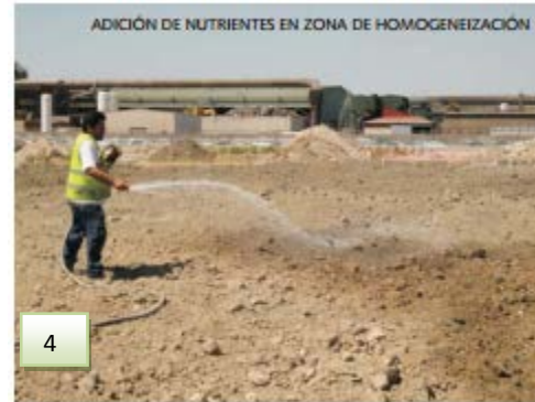
Fig. 3.8 Instalación de la Biopilas
