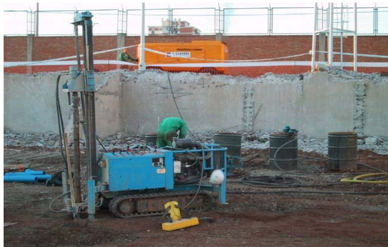
Fig. 2.2 Instalación de Puntos de Investigación
