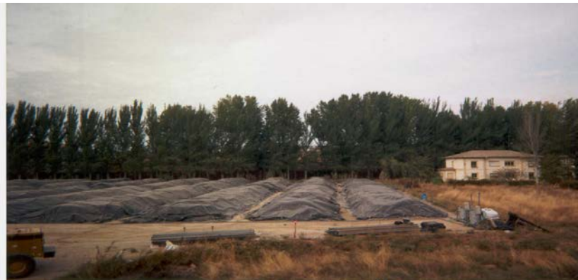
Fig. 3.9 Operación de las Biopilas Concluida
