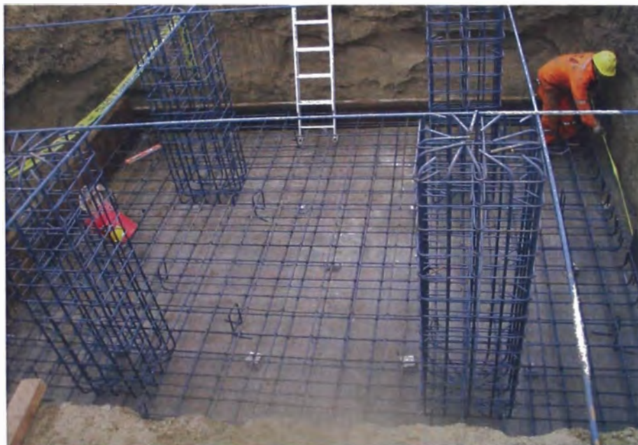
R.F. 06: Encofrado previo al vaciado final de zapatas
