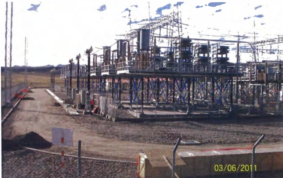
R.F. 16: Subestación en proceso de culminación
