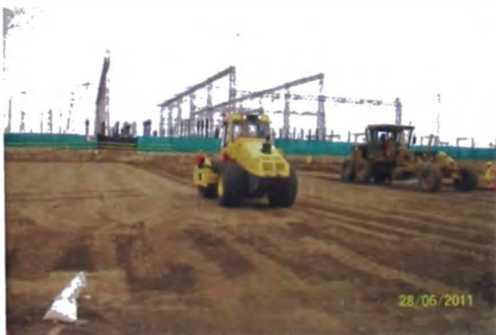
Fig. No. 2.1 Proceso de explanación Fig. No. 2.2 Área lista para el trazo
