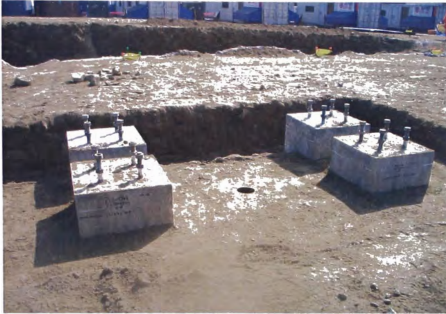
R.F. 09: Compactación estructural de zapatas
