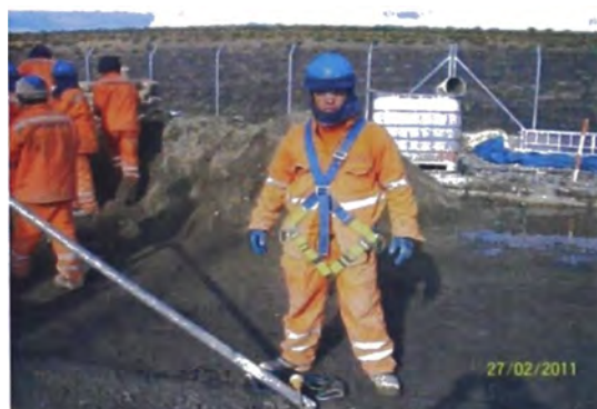
Fig. No. 1.5 Trabajos en altura
