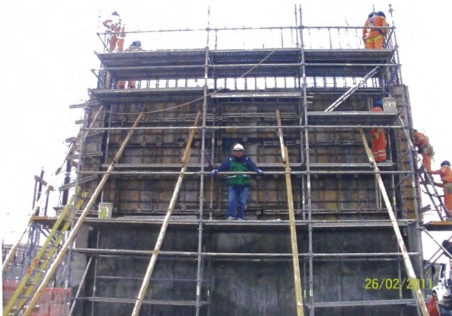
R.F. 21: Última etapa de muro cortafuego
