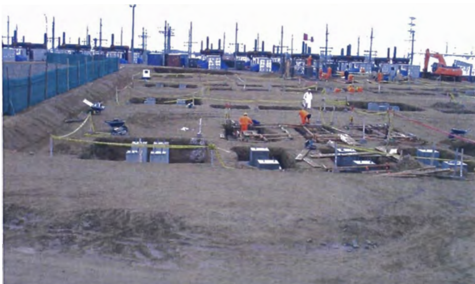
R.F. 08: Patio de 220 kV con total de vaciado de zapatas y pedestales
