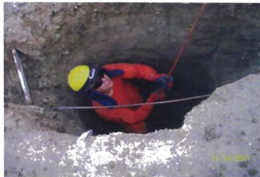
Fig. No. 1.2 Trabajos en áreas restringidas
