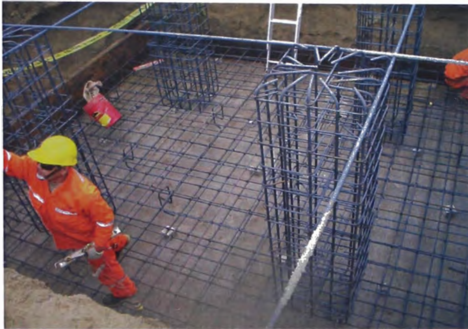
R.F. 05: Colocación de acero de zapatas y pedestales
