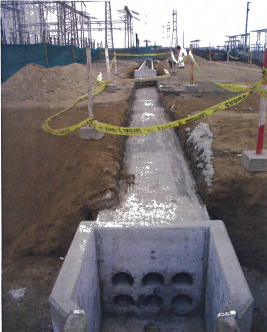
R.F. 13: Duct-bank luego de vaciado de concreto
