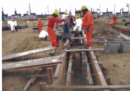
Fig. No. 2.11 Vaciado de canaletas
