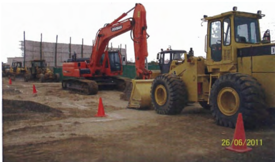
R.F. 02: Maquinaria para inicio de proceso de explanación.
