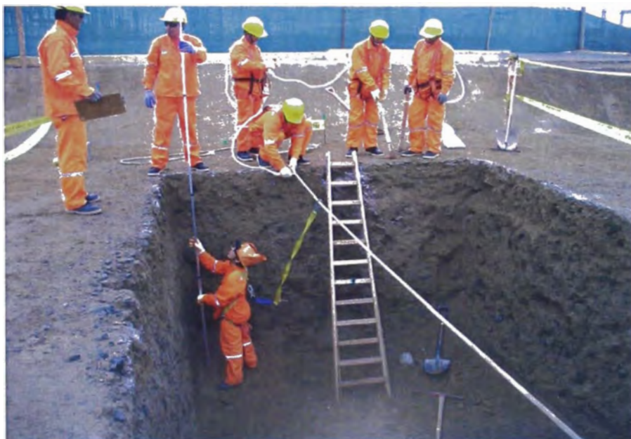
R.F. 04: Excavación de zanjas para zapatas de pórticos
