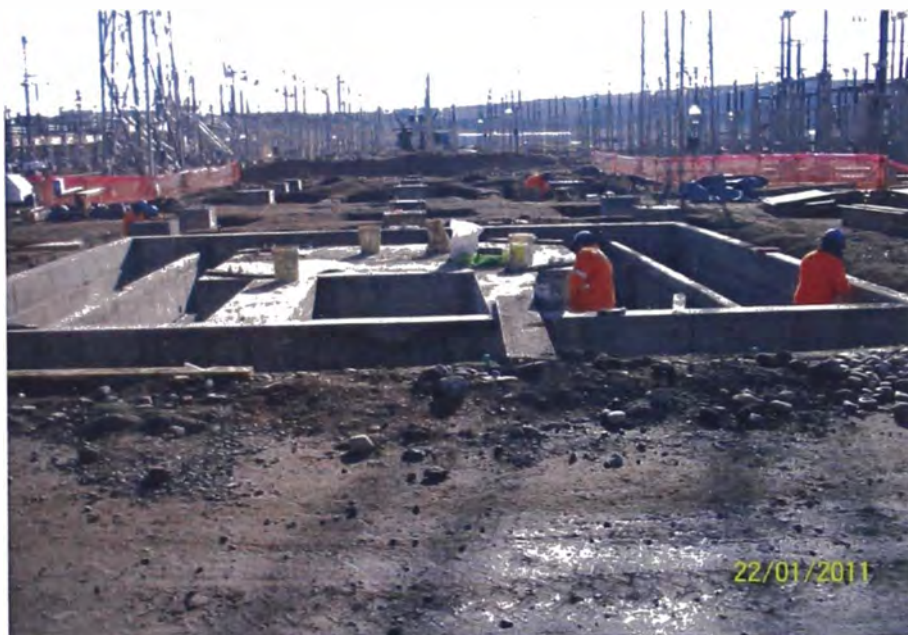
R.F. 17: Terminación-solaqueado de base de transformador
