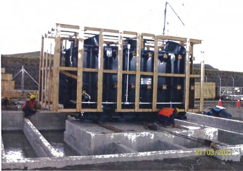
R.F. 22: Transformador de potencia en proceso de colocación final
