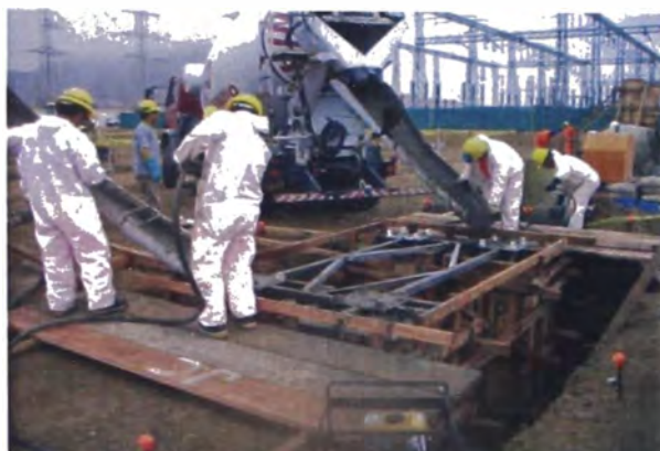
Fig. No. 2.4 Vaciado de concreto
