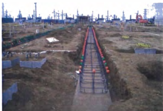
Fig. No. 2.10 Canaletas en proceso
