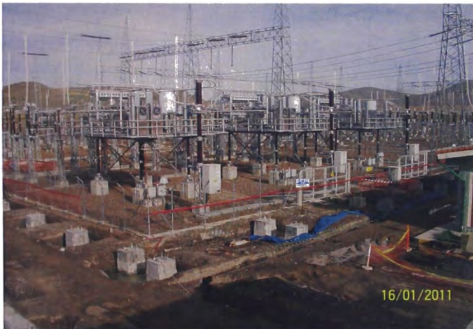
R.F. 15: Construcción de pedestales para Pipe rack de concreto
