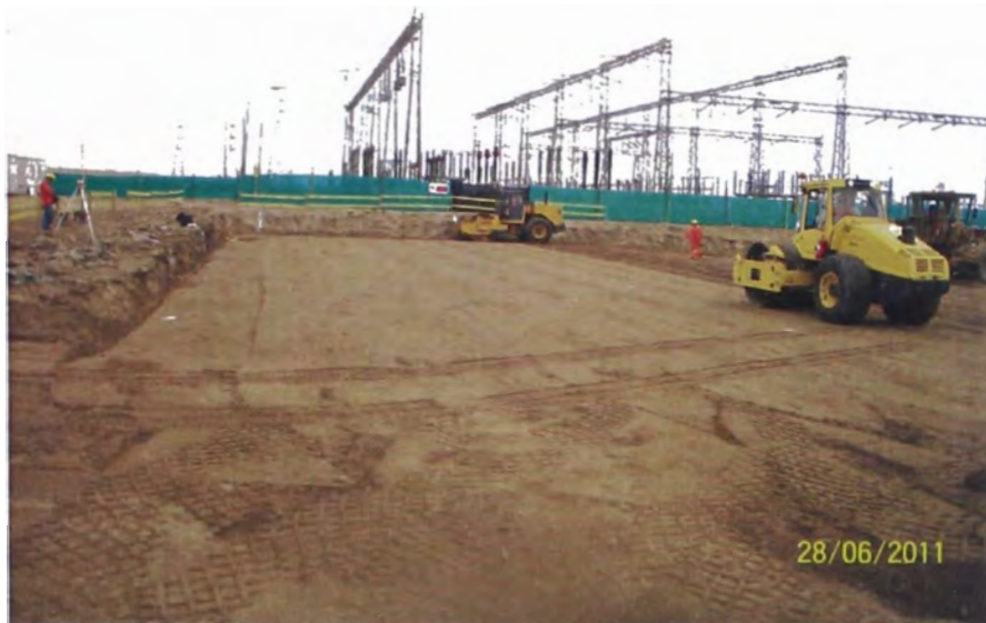
R.F. 03: Plataforma en proceso de explanación
