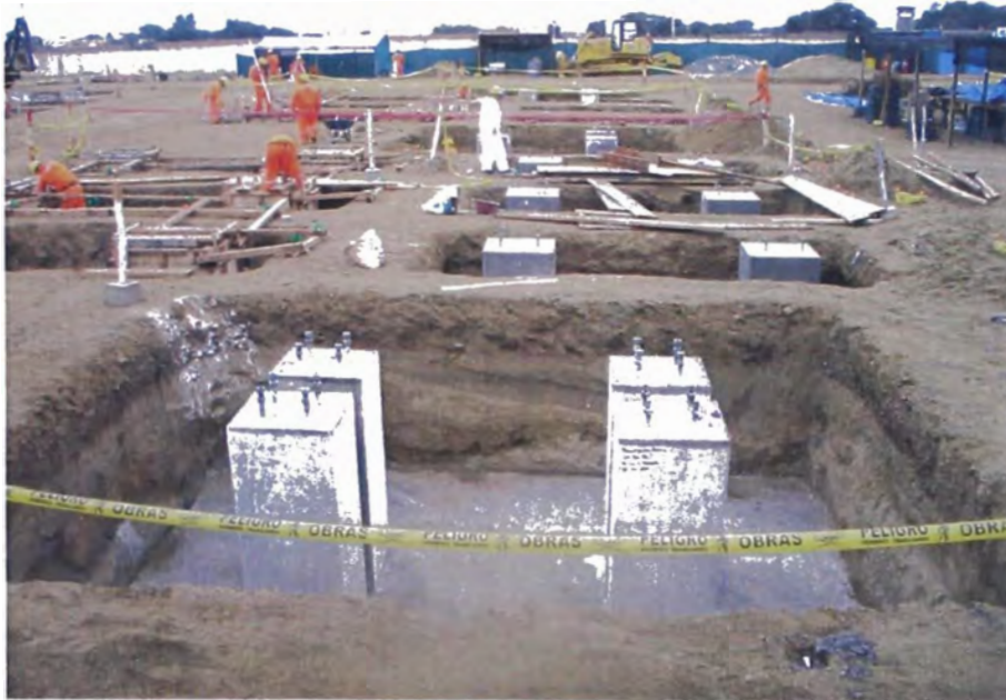
R.F. 07: Estado final de zapatas y pedestales, incluyendo pernos de anclaje
