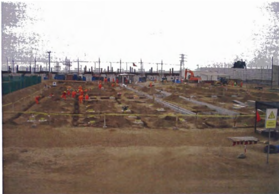
R.F. 10: Excavación para malla puesta a tierra
