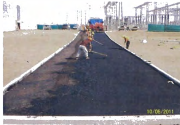
Fig. No. 2.12 Colocación de carpeta asfáltica
