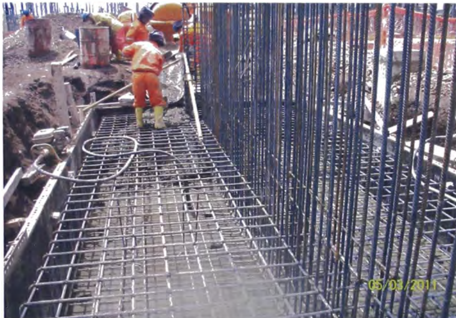
R.F. 19: Vaciado de zapata de muro cortafuego
