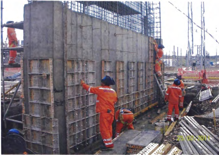
R.F. 20: Muro cortafuego en proceso de construcción
