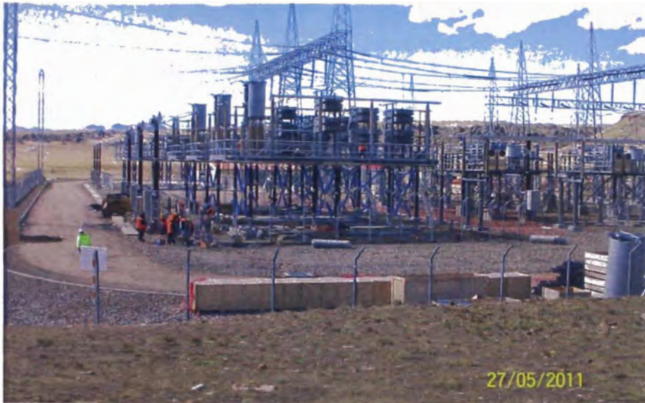
R.F. 24: Subestación eléctrica-patio de condensadores en proceso de culminación
