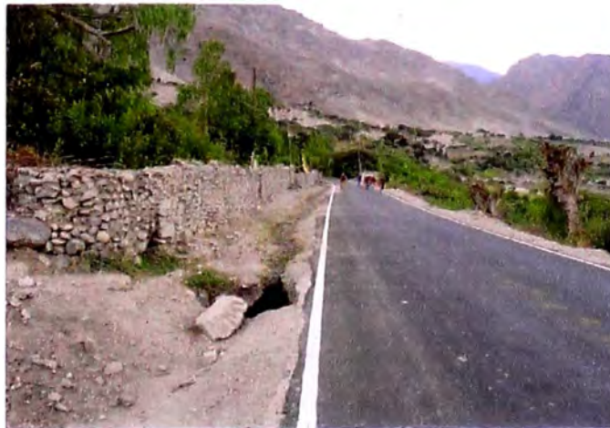
Progresiva Km 80+600. Vista hacia Catahuasi, en donde se puede apreciar la geografía de la zona
