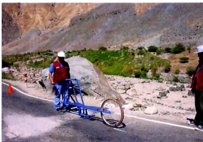
Progresiva Km 75+200. Operación en campo del equipo MERLIN
