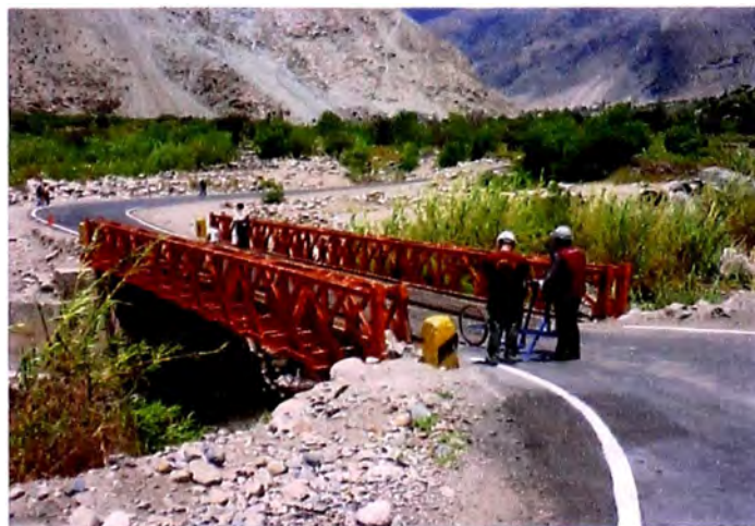
Progresiva Km 77+800. Puente ubicado en el tramo de estudio
