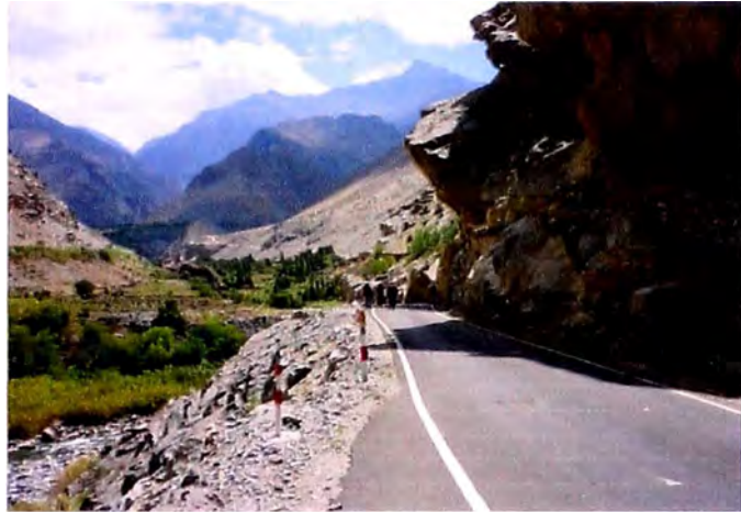
Progresiva Km 76+000. Vista hacia Catahuasi, en donde se observa la geografía de la zona. A la derecha de la vía un cerro con rocas y a la izquierda el valle y el río de la zona
