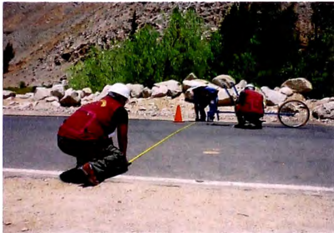
Progresiva Km 76+800. Trabajos de medición en campo
