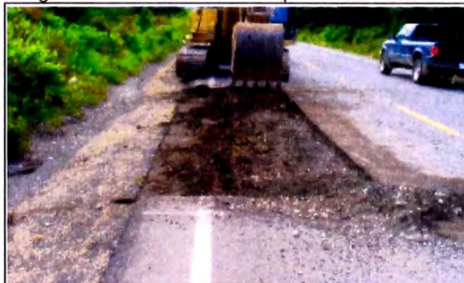
Figura N° 5.07: Bacheo de un pavimento asfáltico
