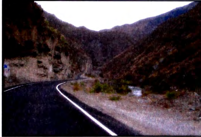
Figura N° 5.05: Vías de bajo tránsito, conservación por niveles de servicio
