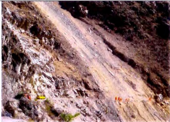
Foto 08: Zona de talud inestable, produce desprendimientos del material disgregado, Km 135+600 al Km 135+700.
