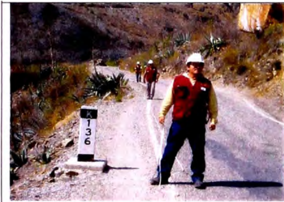
Foto 03: Tercer tramo a evaluar, Km 136+000, presenta la monocapa en estado necesario para un mantenimiento.
