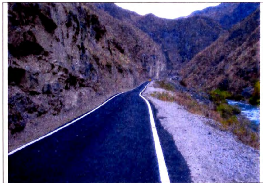
Foto 12: Rehabilitación de superficie de protección en el Km 137+400 al Km 139+000
