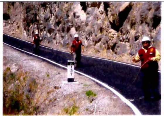
Foto 04: Cuarto tramo a evaluar, Km 137+000, se ha realizado un mantenimiento.
