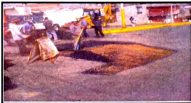
Reparación de bache
