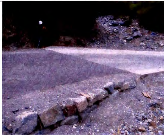
Foto 11: Obra de arte, Inicio del badén, Km 136+200 al Km 136+300.
