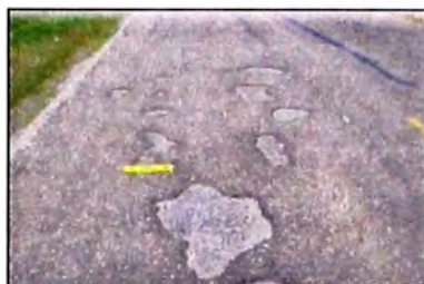
Figura N° 5.11: Descacaramiento
