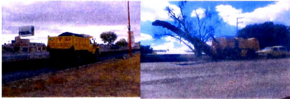
Recuperadora de asfalto y transportado a la planta de reciclado
