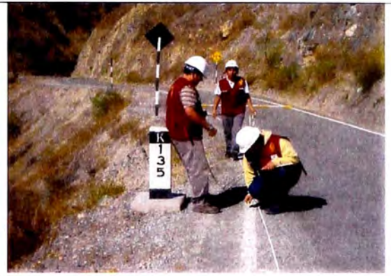
Foto 02: Segundo tramo a evaluar, Km 135+000, se procede a la marcación de su inicio y segmentar cada 100m en cada Km.
