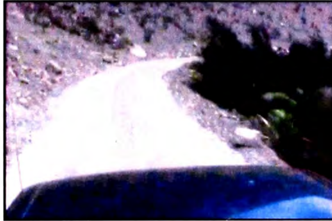
FIGURA N°1.1 ESTADO INICIAL DE LA VÍA EN EL KM 98
