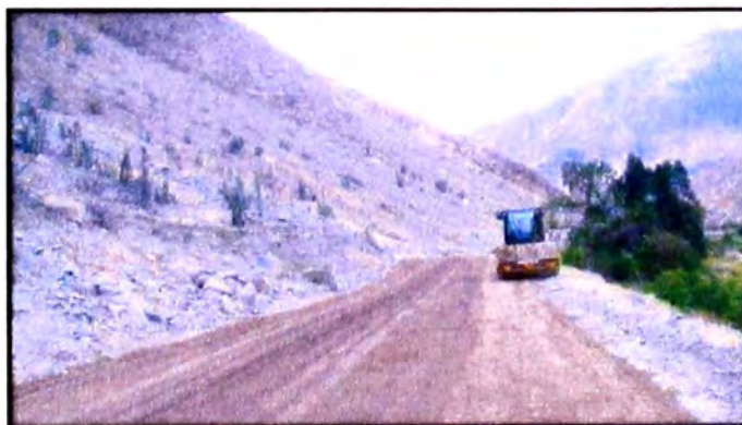
FIGURA N°1.2 MEJORAMIENTO DE LA SUBRASANTE, COLOCANDO UNA CAPA DE MATERIAL EN EL KM 98
